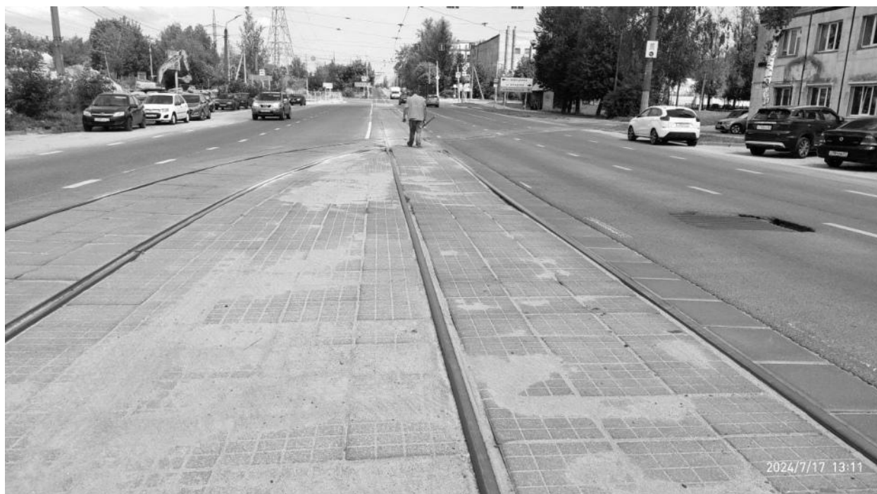
Рисунок 2.813 – Общий вид участка трамвайных путей – узел «кольцо Заводская»
