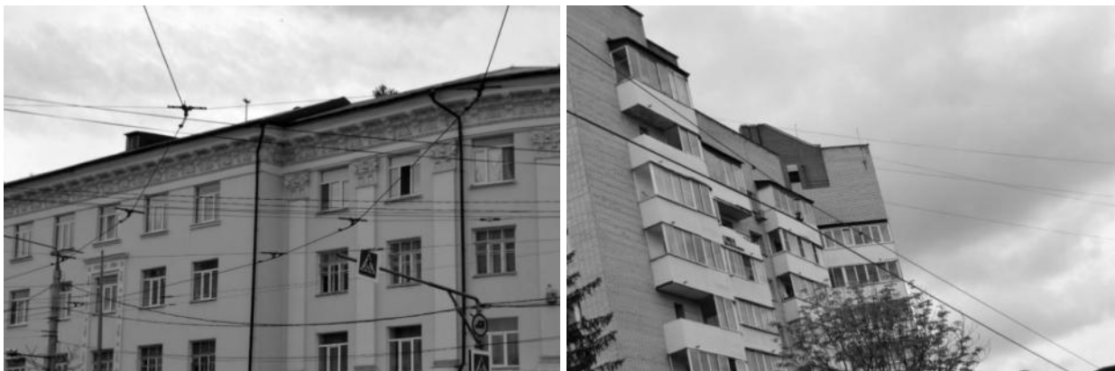
Рисунок 2.349 – Контактный провод трамвая
