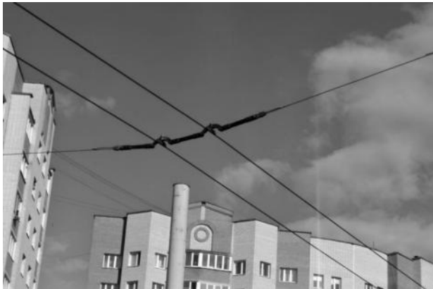
Рисунок 2.566 – Контактный провод троллейбуса
