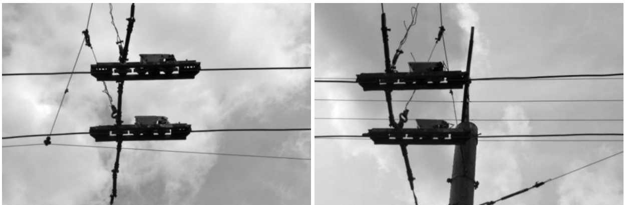
Рисунок 2.632 – Секционные изоляторы
