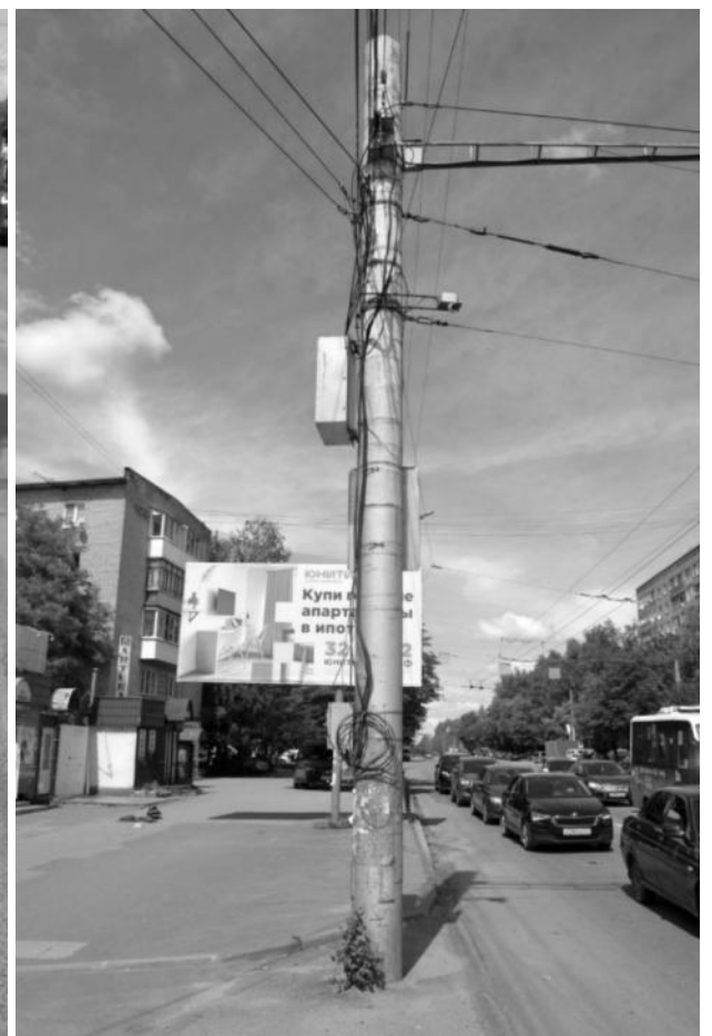
Рисунок 2.498 – Опоры контактной сети
