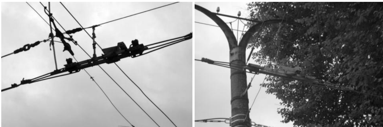
Рисунок 2.369 – Секционные изоляторы
