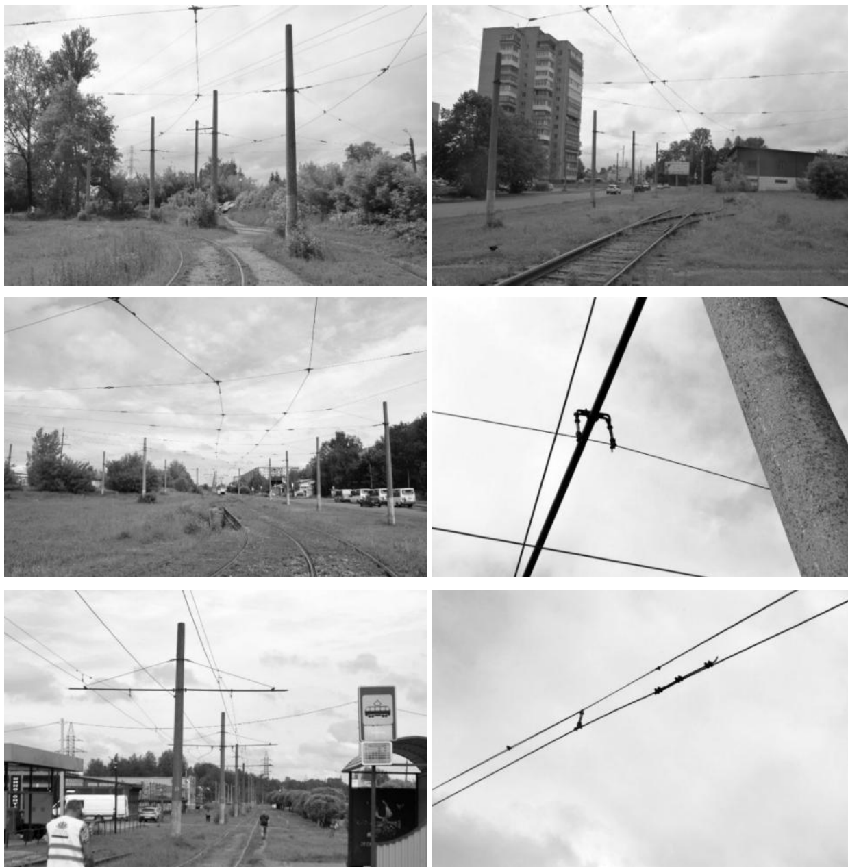
Рисунок 2.263 – Системы подвески из стальных канатов
