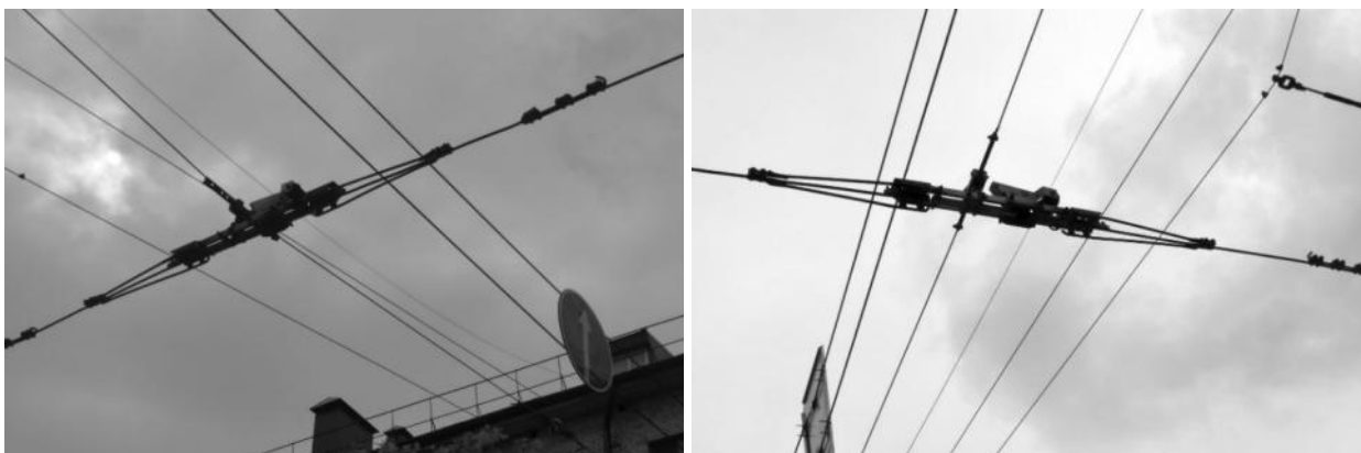
Рисунок 2.350 – Секционные изоляторы
