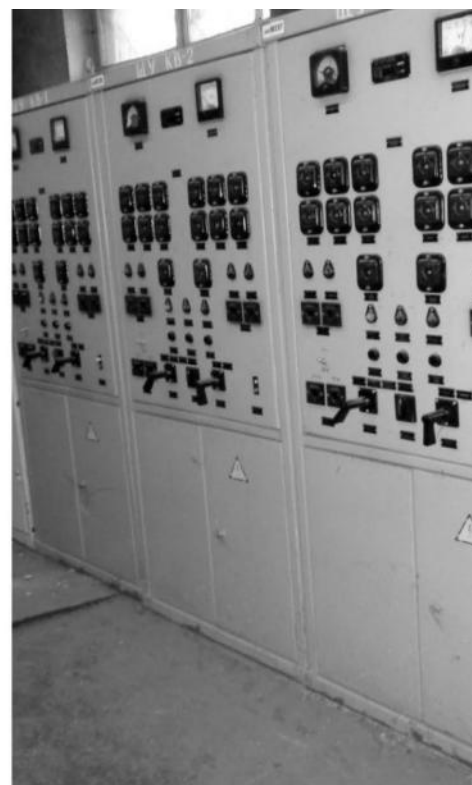
Рисунок 2.225 Блоки выпрямителя БВКЛЕ-1000 и шкафы управления ШУЛЕ-1000 (ТП-8)
