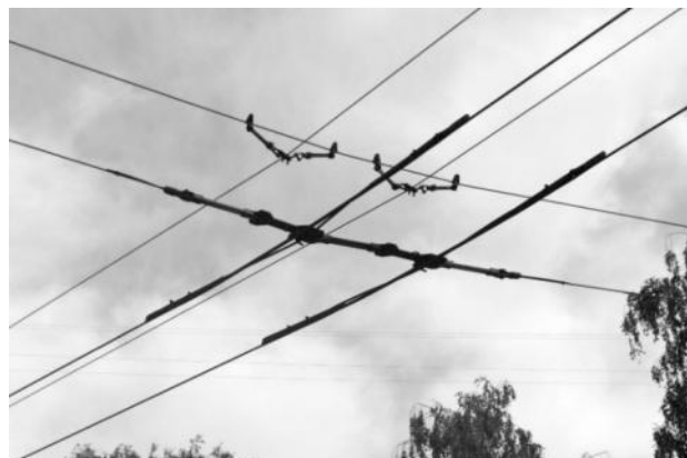
Рисунок 2.526 – Кривой держатель
