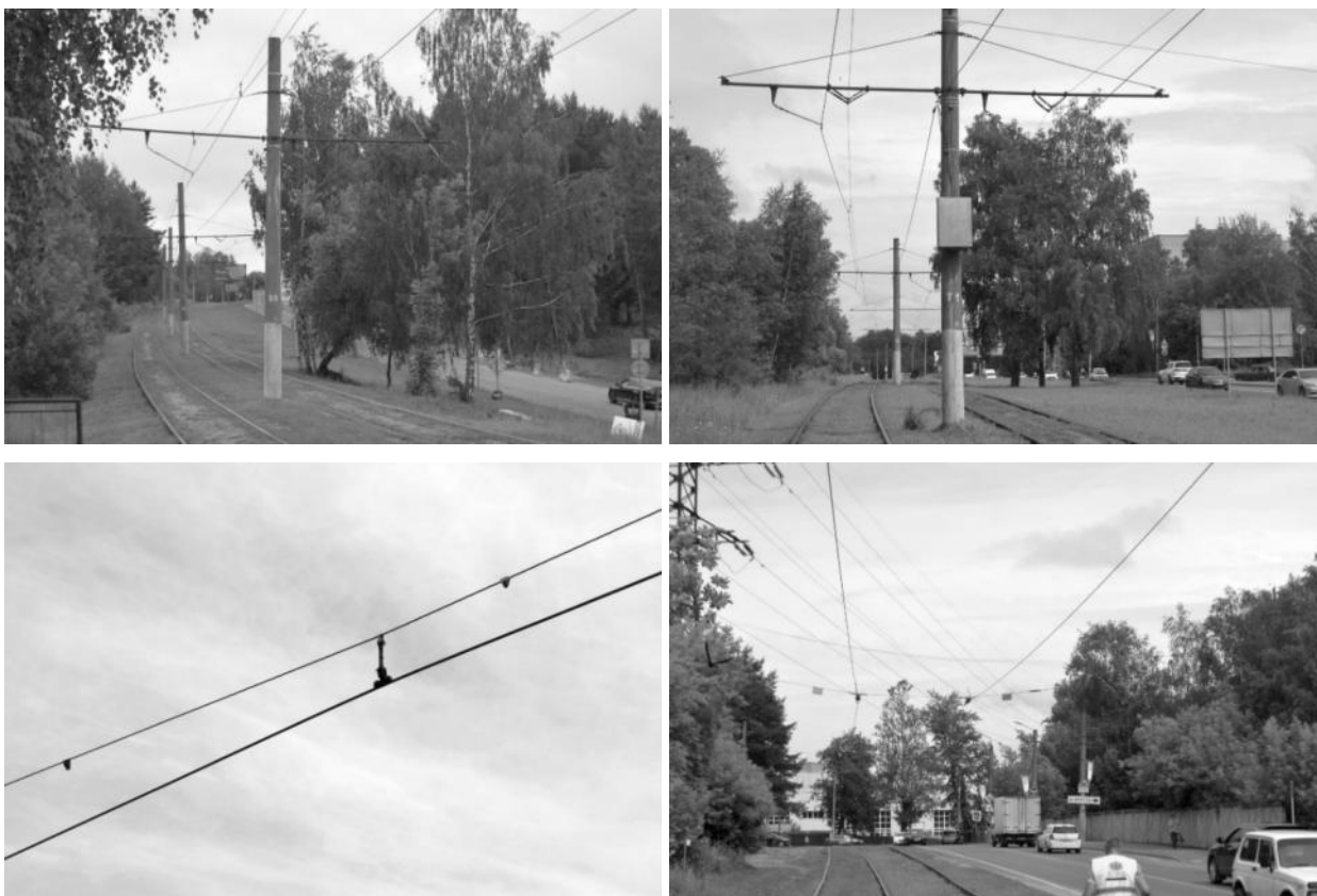
Рисунок 2.269 – Системы подвески из стальных канатов
