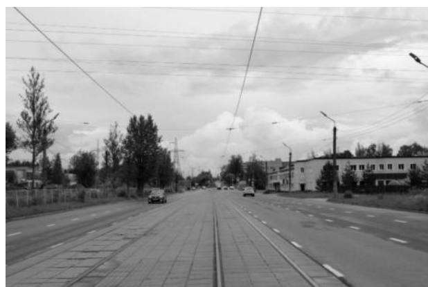
Рисунок 2.434 – Контактный провод трамвая
