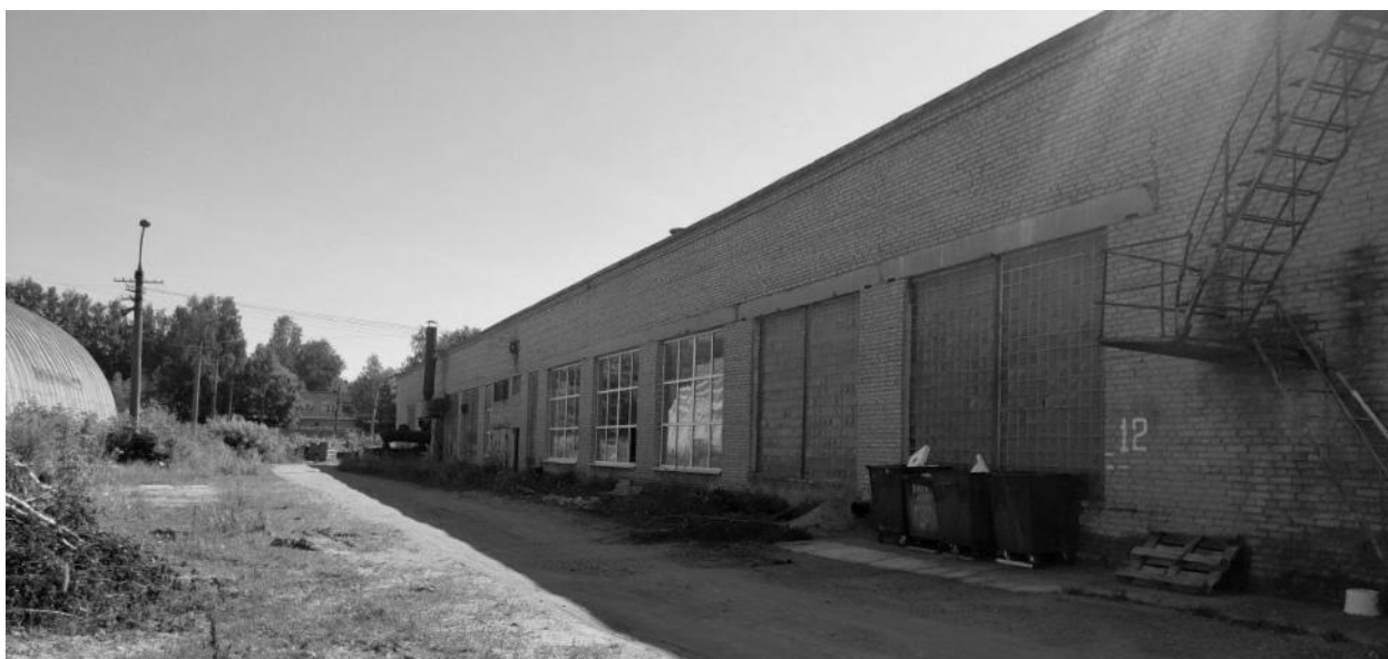
Рисунок 2.58 – Общий вид ПК депо №2 на дату проведения обследования
