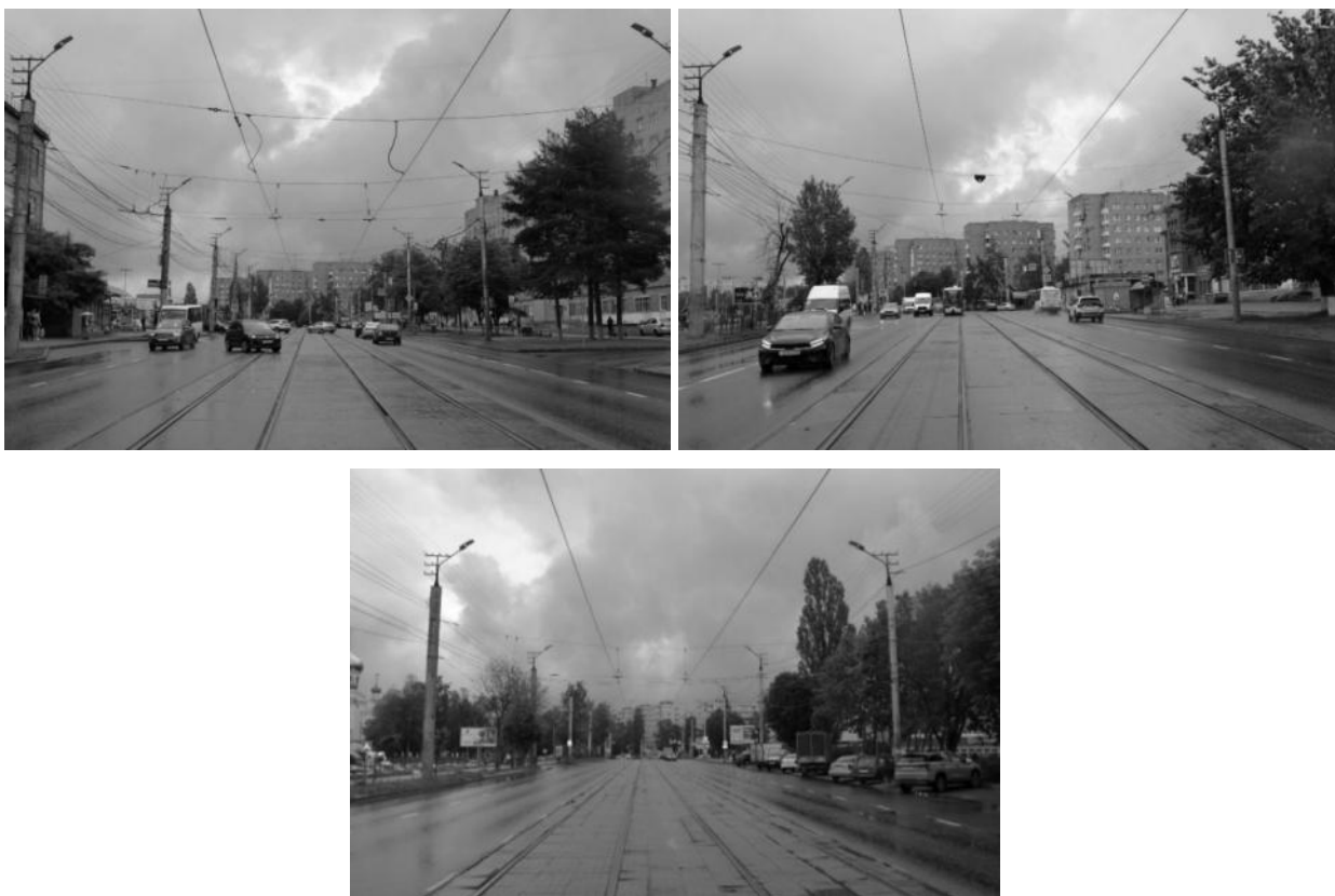
Рисунок 2.413 – Существующие опоры контактной сети
