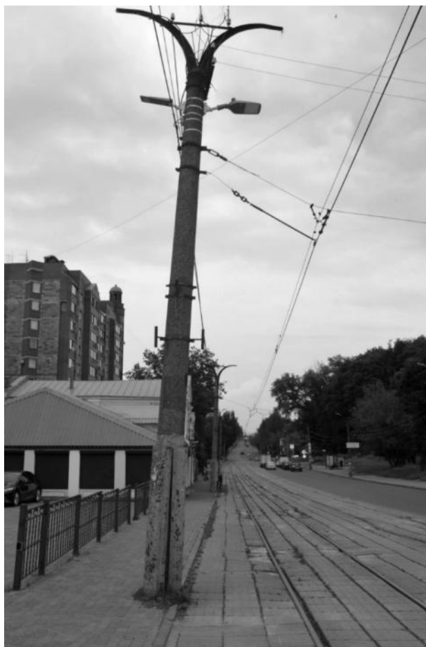
Рисунок 2.365 – Железобетонная опора
