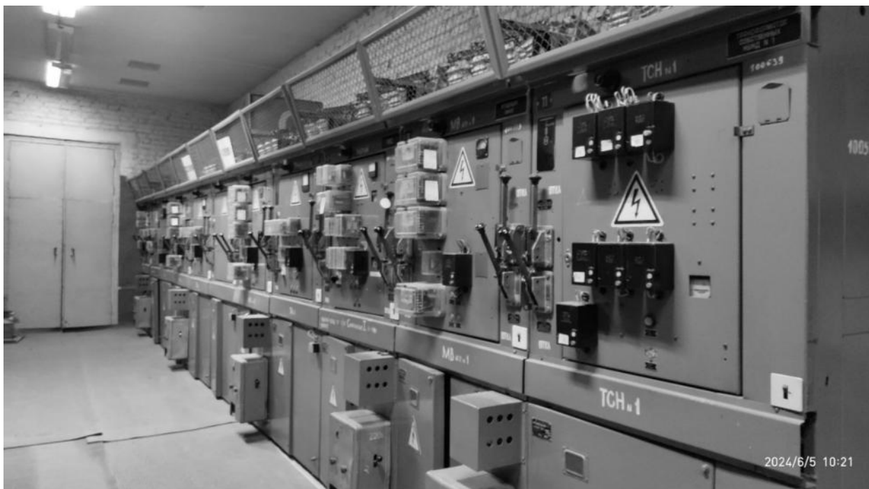
Рисунок 2.230 – Камеры РУ-6 кВ типа КСО-285 на ТП-6
