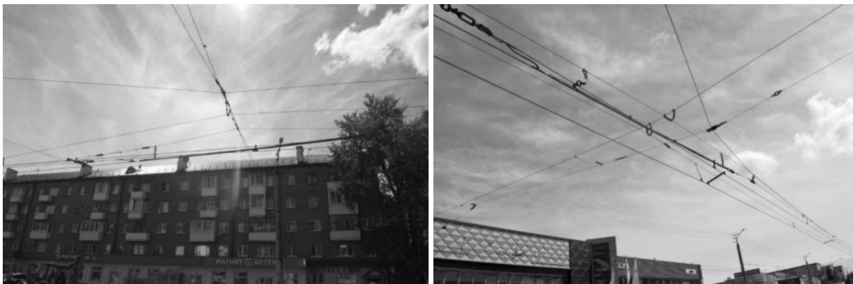
Рисунок 2.496 – Поля грузовой компенсации
