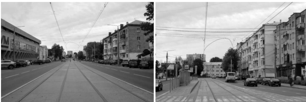
Рисунок 2.353 – Существующие опоры контактной сети
