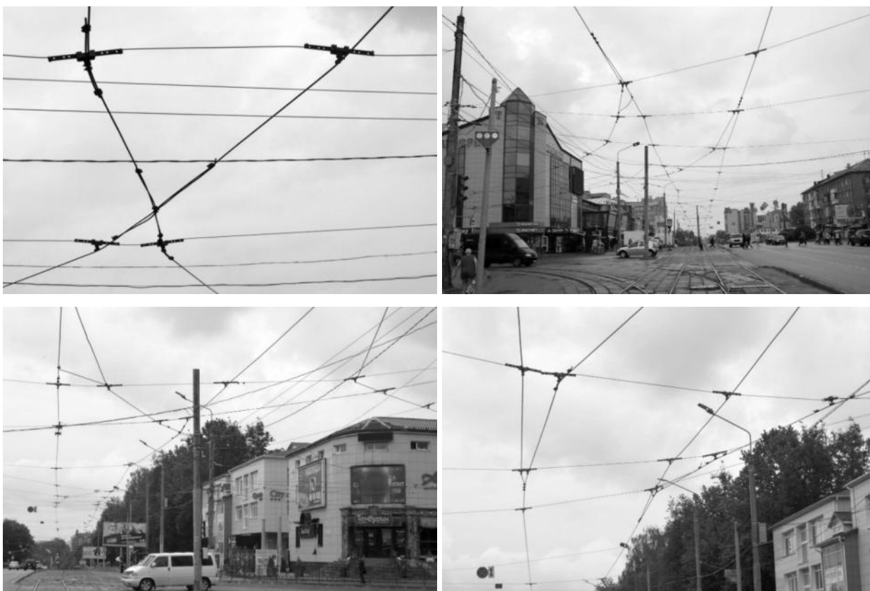
Рисунок 2.385 – Стальной канат на участке контактной сети
