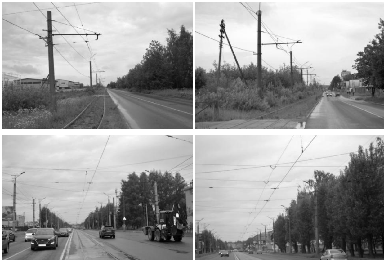
Рисунок 2.444 – Существующие опоры контактной сети
