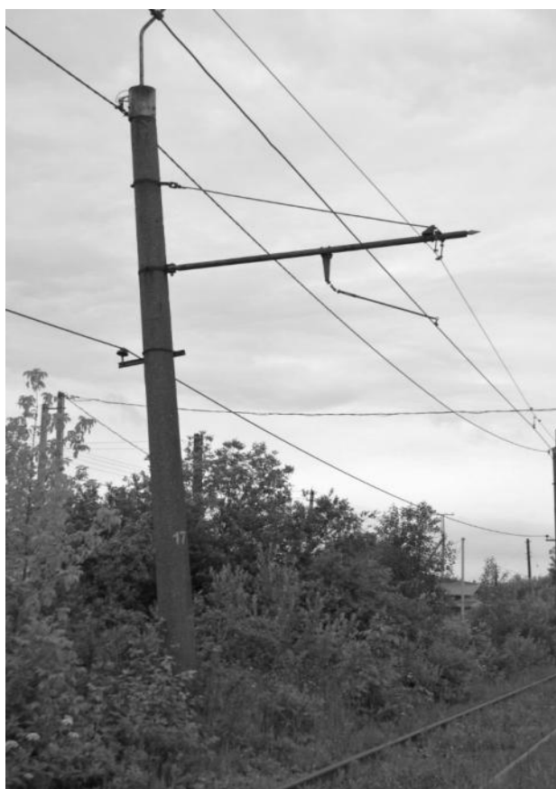
Рисунок 2.445– Существующие опоры контактной сети
