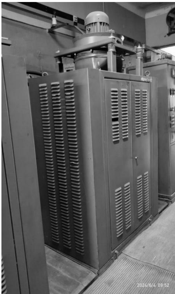
Рисунок 2.224 – Блоки выпрямителя БВКЛ-1000 и шкафы управления ШУЛ-1000 (ТП-2)
