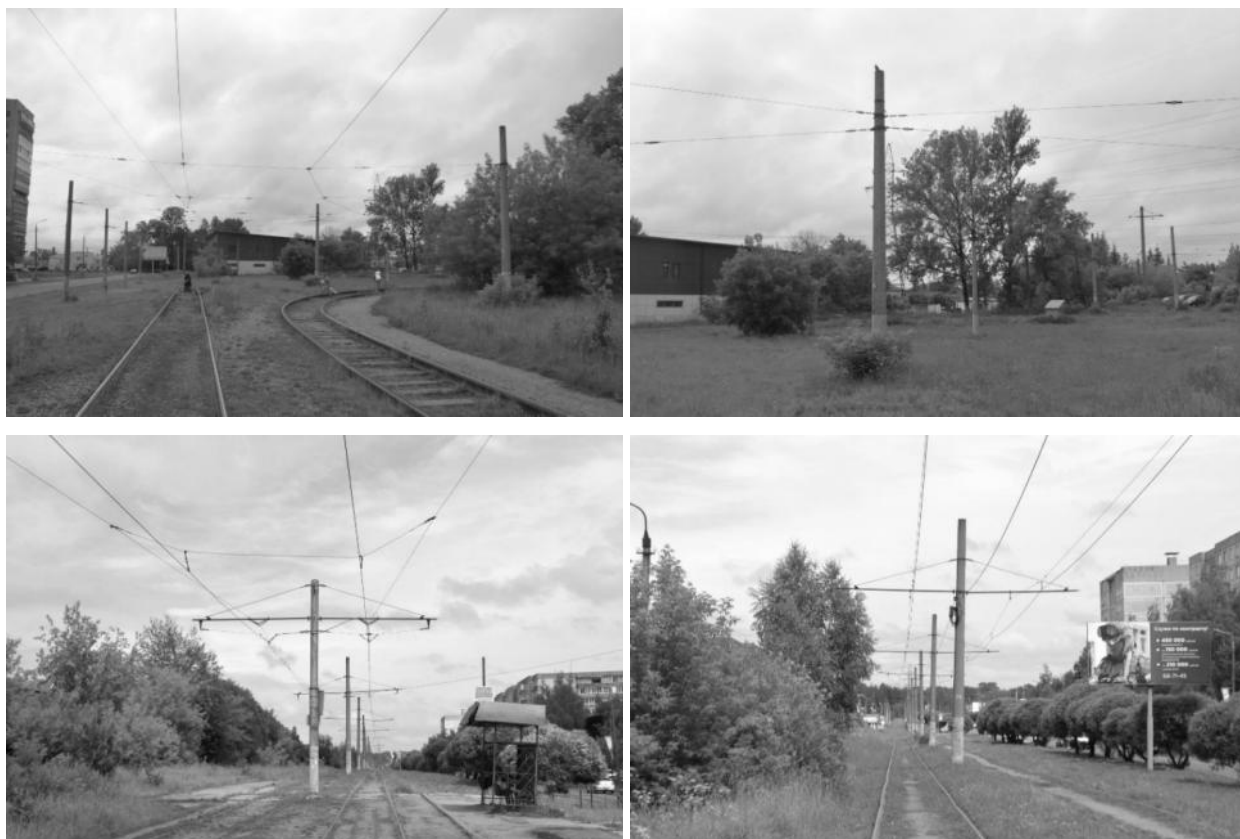
Рисунок 2.258 – Существующие опоры контактной сети
