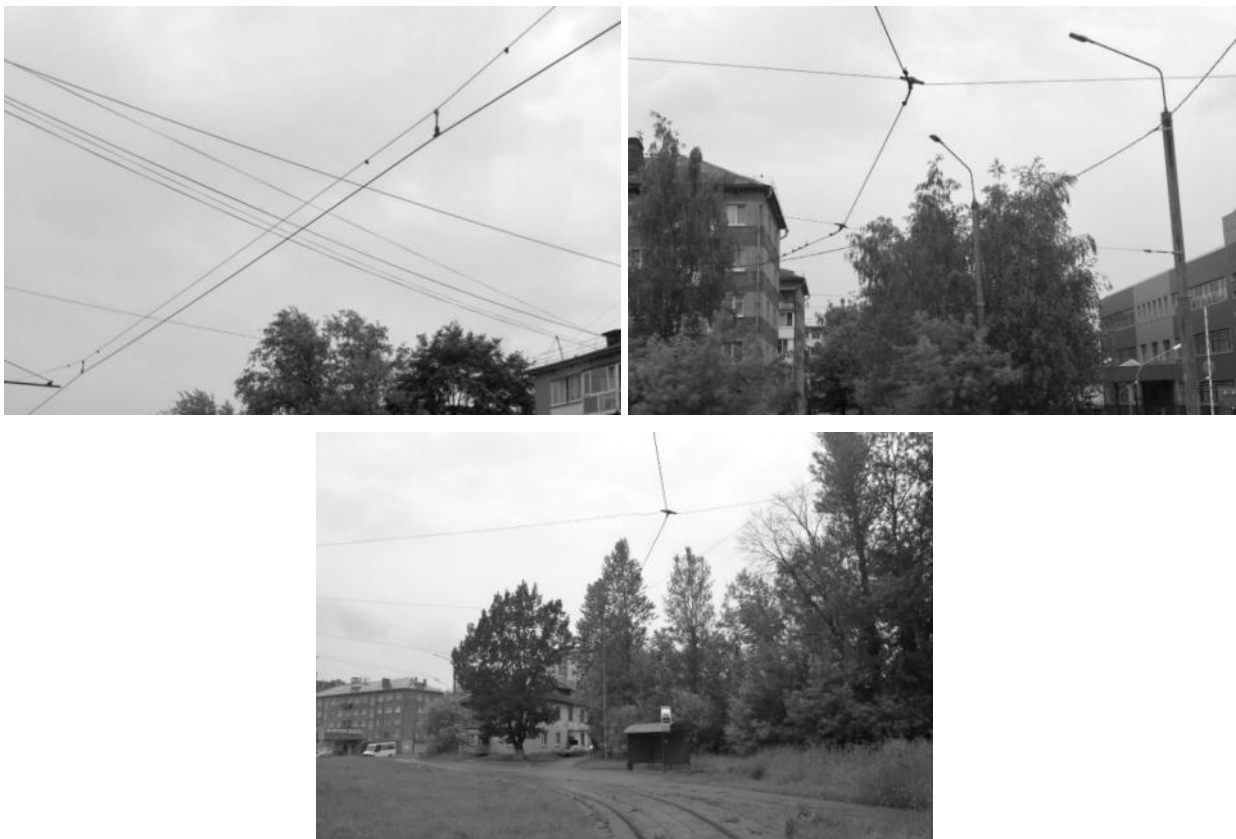
Рисунок 2.392 – Стальной канат на участке контактной сети
