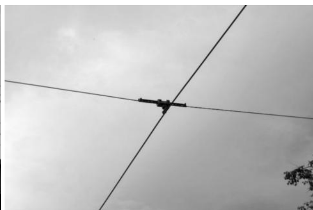
Рисунок 2.335 – Контактный провод трамвая
