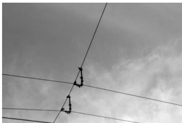
Рисунок 2.510 – Системы подвески из стальных канатов
