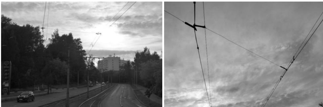
Рисунок 2.329 – Оттяжки из стального каната
