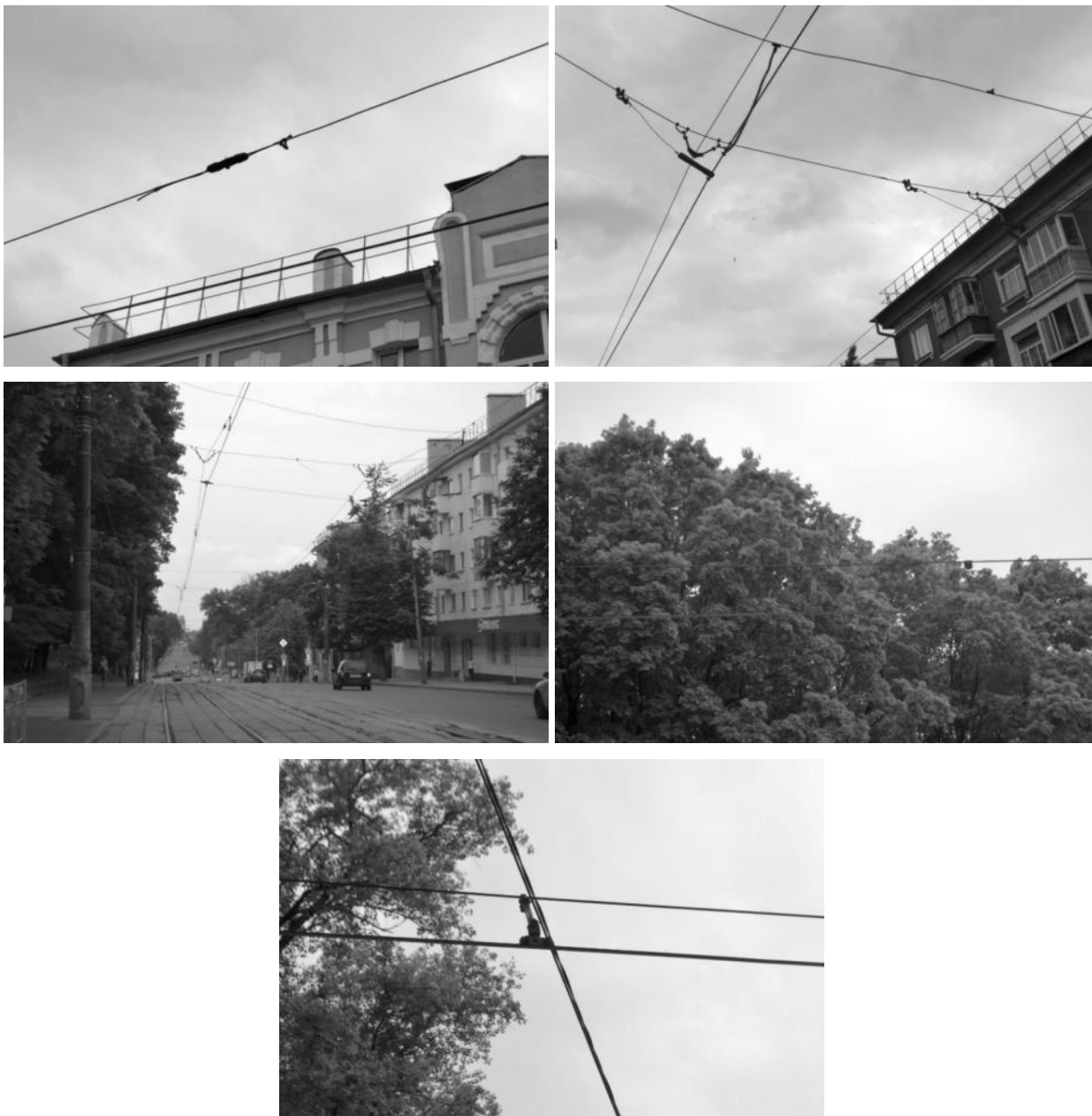
Рисунок 2.371 – Продольный стальной канат
