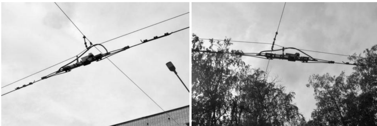
Рисунок 2.276 – Секционные изоляторы
