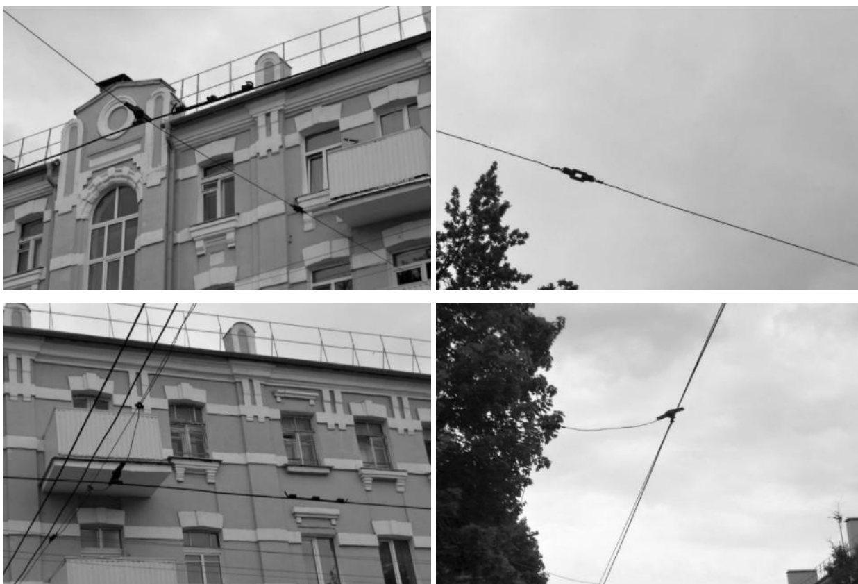
Рисунок 2.370 – Системы подвески из стальных канатов
