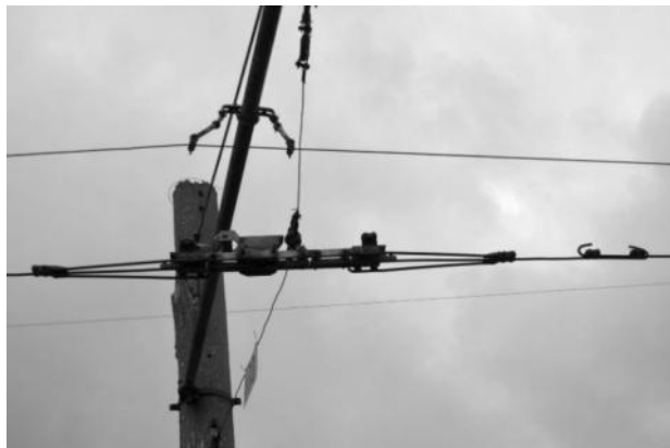
Рисунок 2.442 – Секционный изолятор
