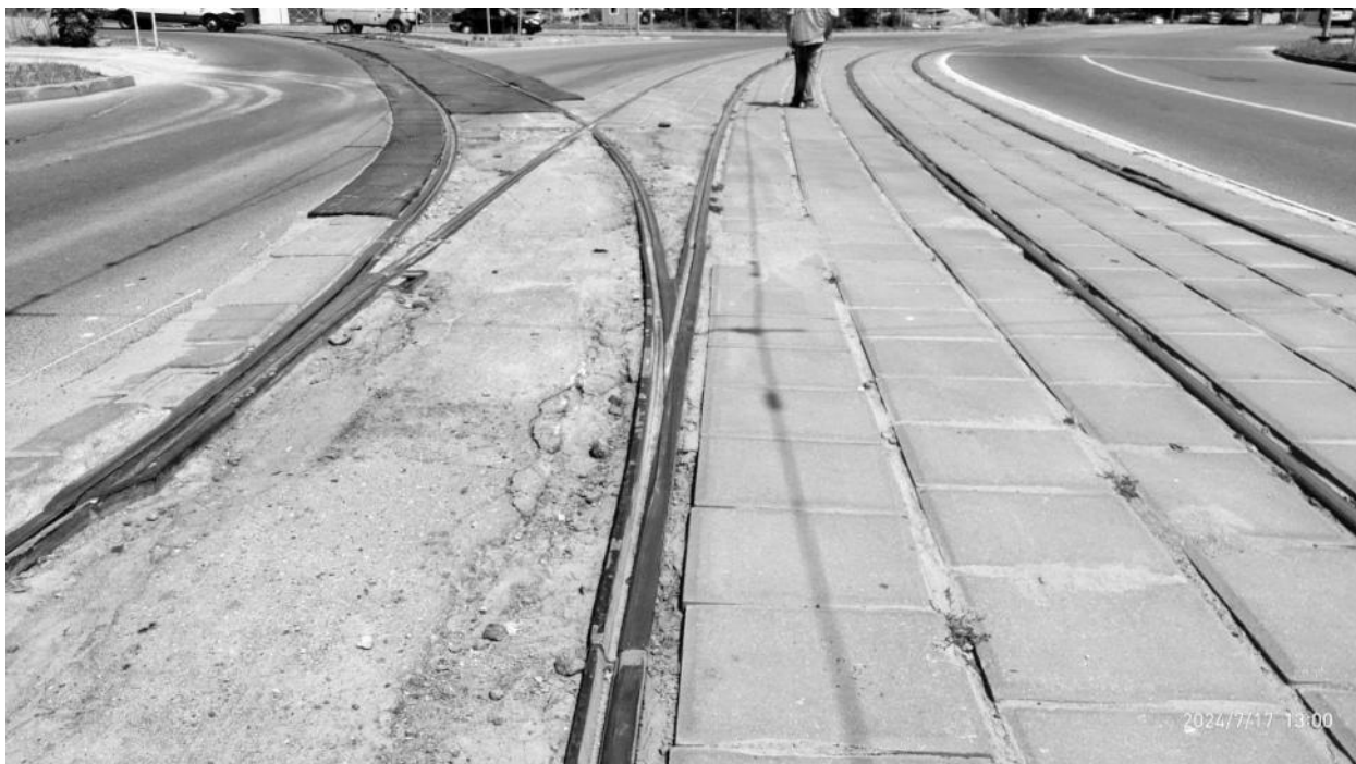
Рисунок 2.811 – Общий вид участка трамвайных путей – узел «Разъезд»
