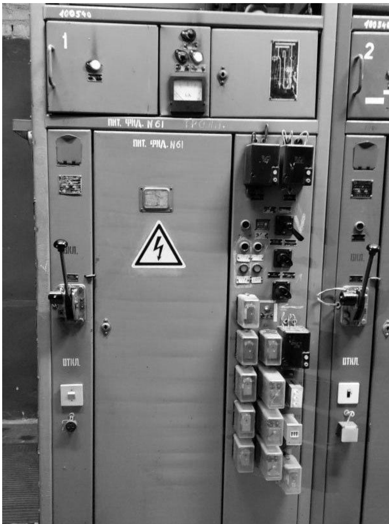
Рисунок 2.237 – Релейная аппаратура РУ-600
