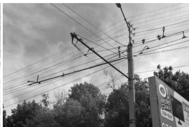
Рисунок 2.562 – Поля грузовой компенсации
