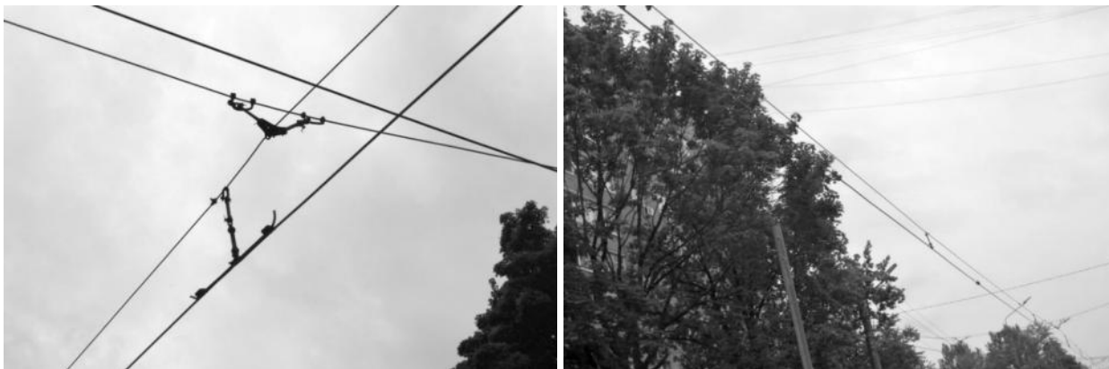
Рисунок 2.379 – Продольный стальной канат
