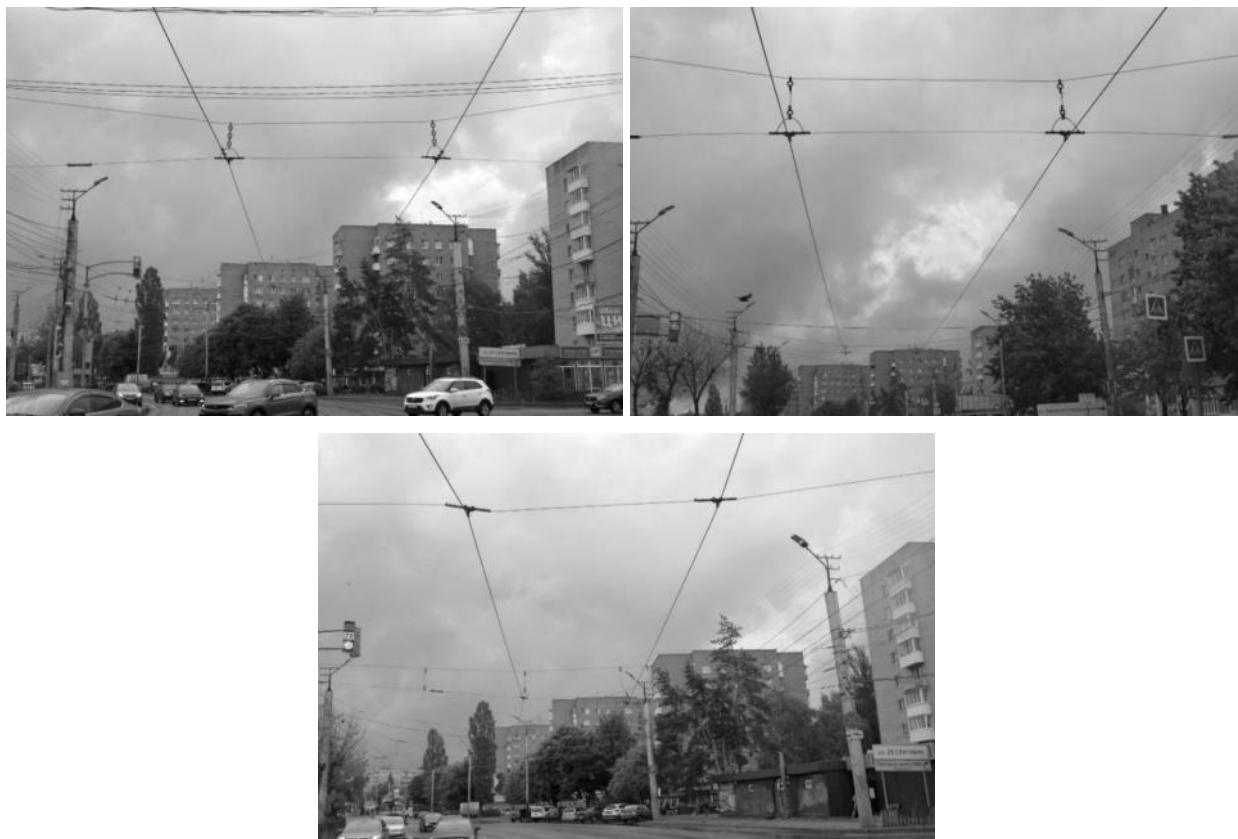
Рисунок 2.418 – Контактный провод трамвая
