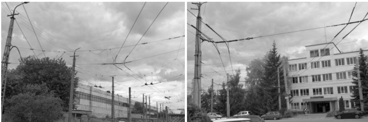
Рисунок 2.608 – Системы подвески из стальных канатов
