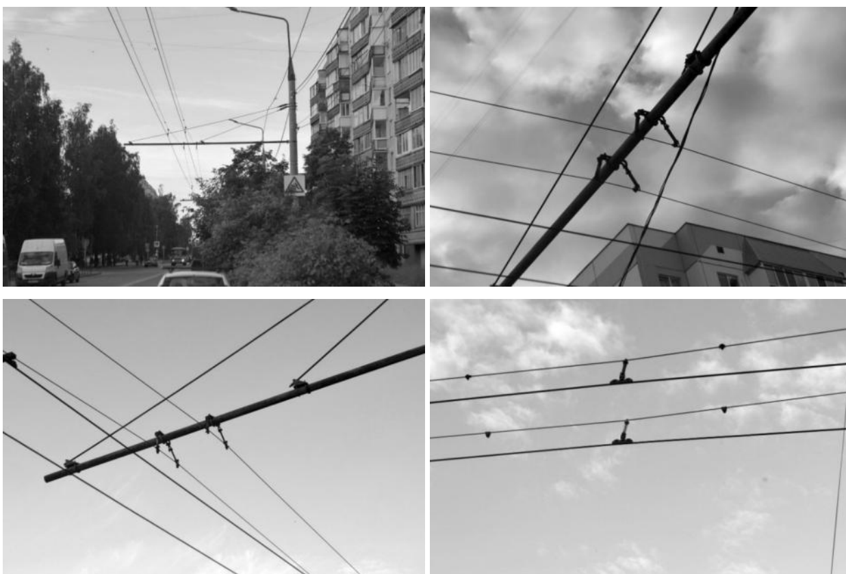
Рисунок 2.590 – Системы подвески из стальных канатов
