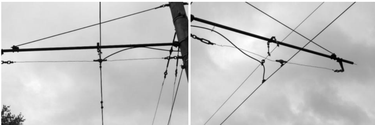
Рисунок 2.264 – Элементы подвески контактной сети
