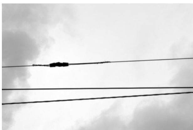
Рисунок 2.450 – Продольный стальной канат
