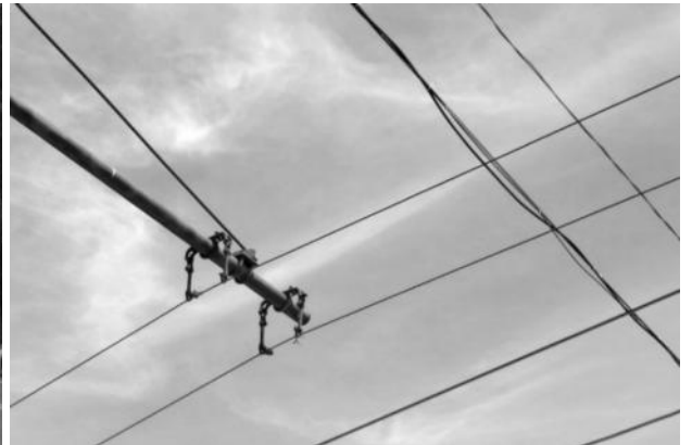
Рисунок 2.511 – Системы подвески из стальных канатов
