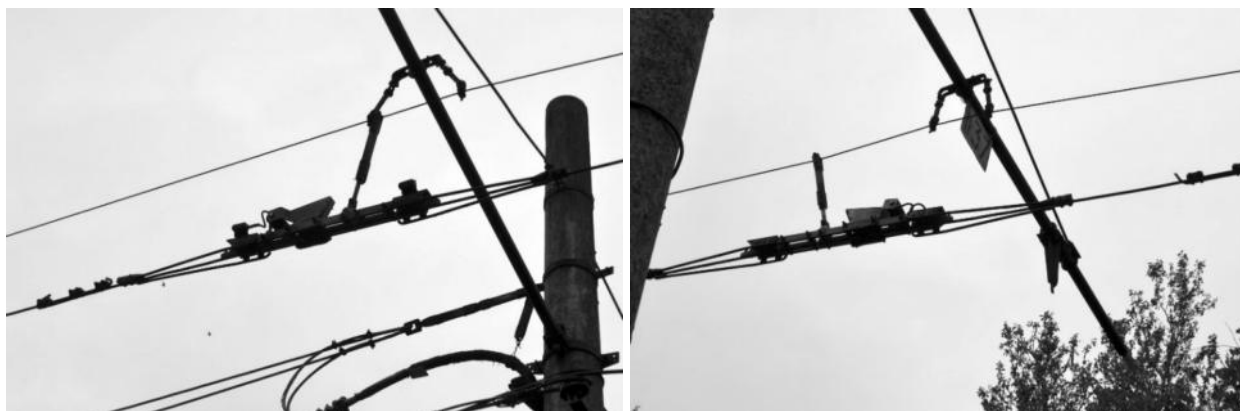
Рисунок 2.427 – Секционные изоляторы
