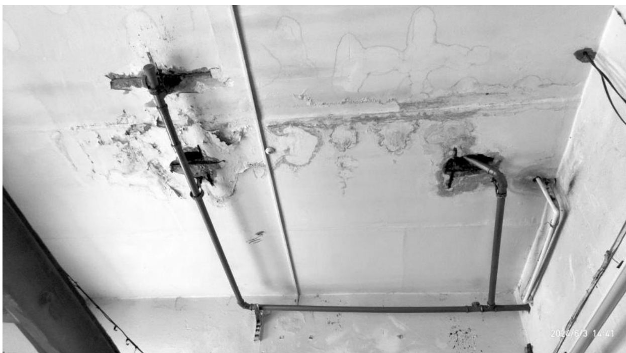
Рисунок 2.211 – Внутренний вид ТП-15
