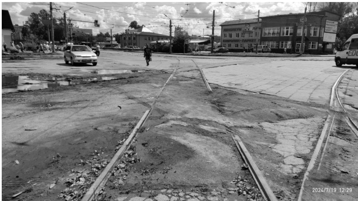
Рисунок 2.833 – Общий вид участка трамвайных путей – узел «Кашена» и «кольцо Кашена»
