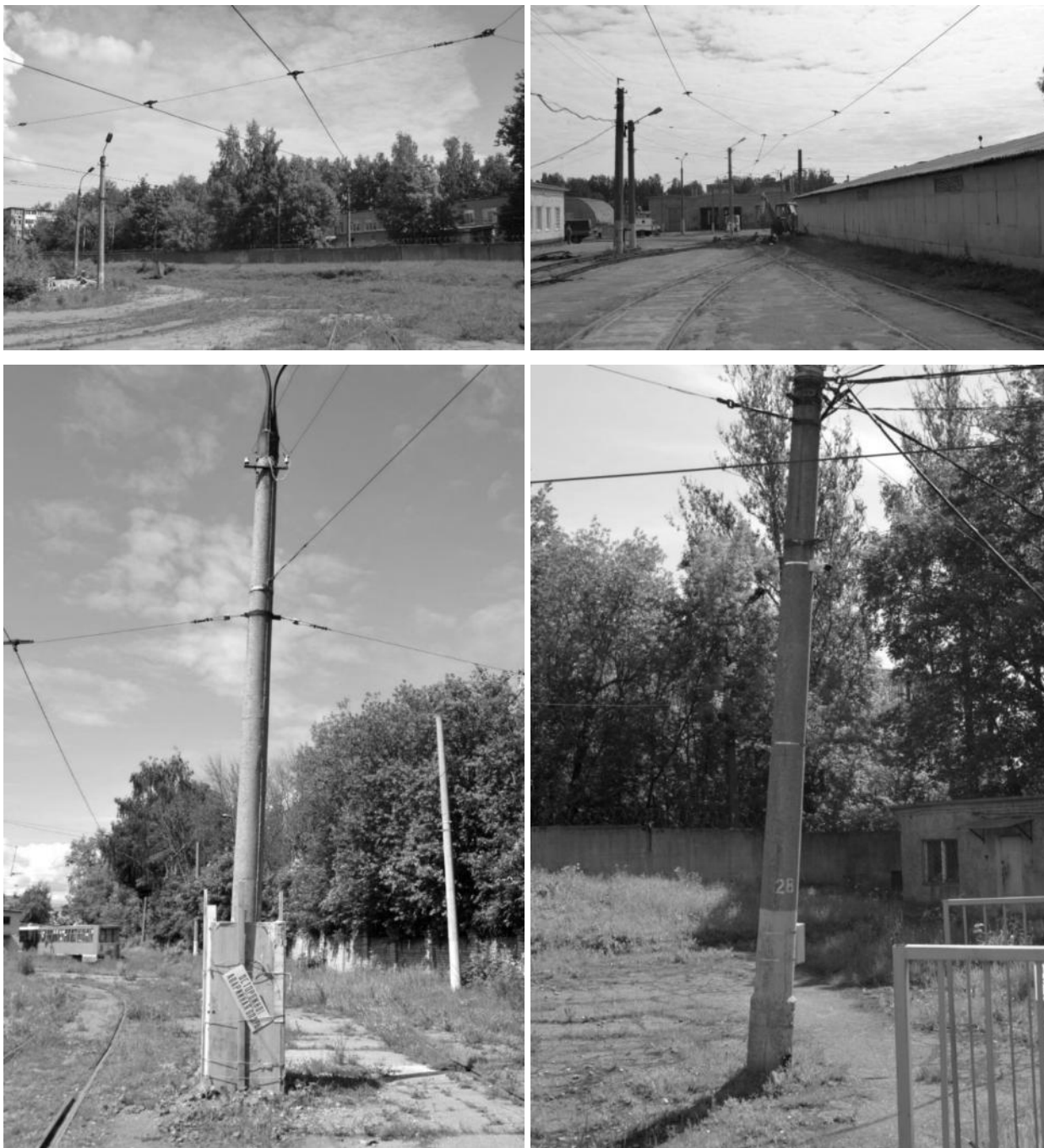
Рисунок 2.478 – Существующие опоры контактной сети
