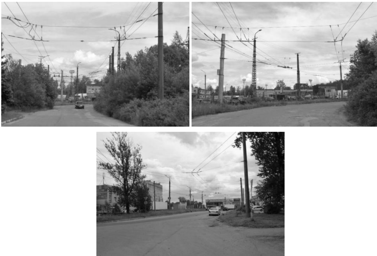
Рисунок 2.594 – Существующие опоры контактной сети
