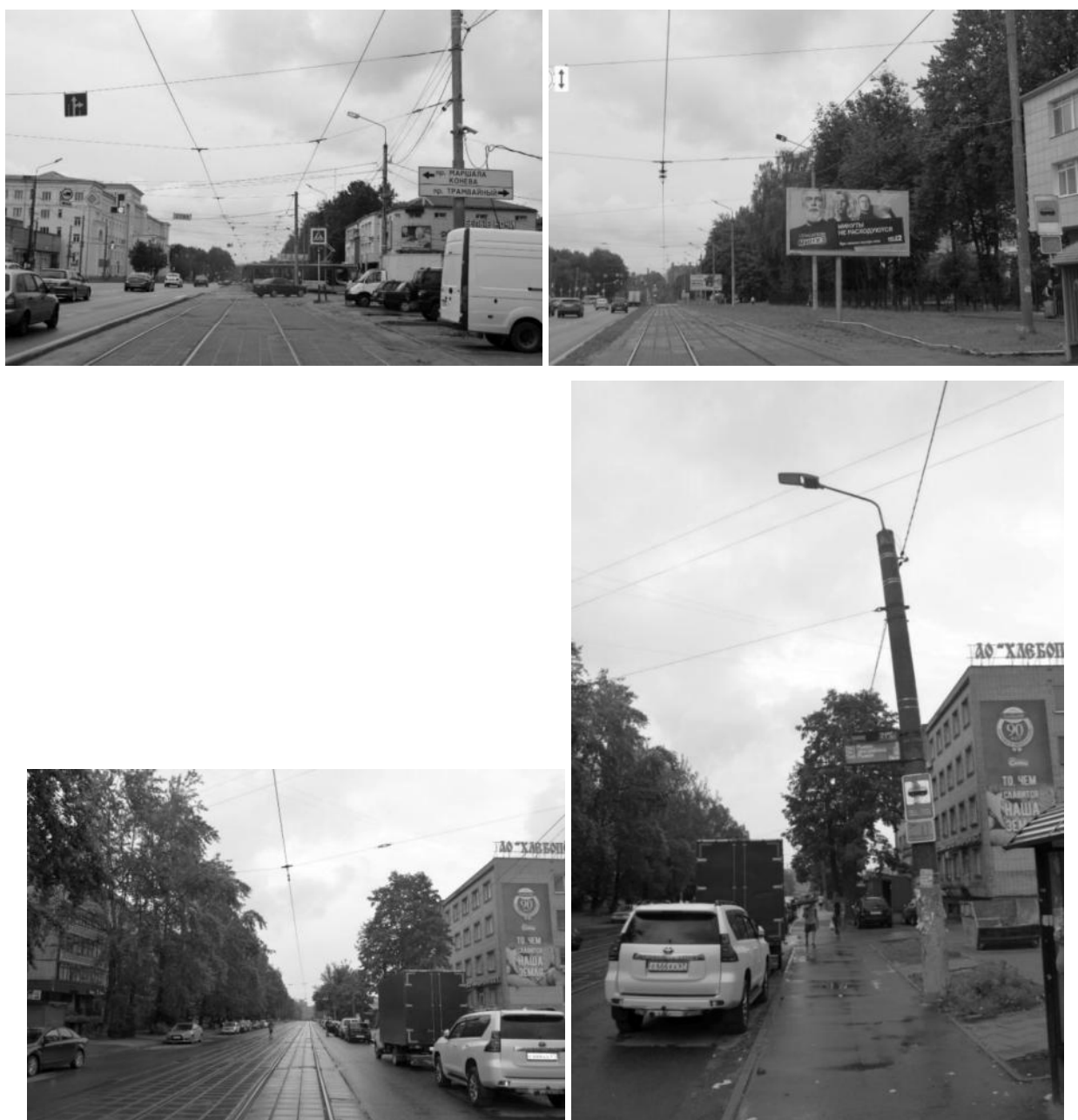
Рисунок 2.382 – Существующие опоры контактной сети
