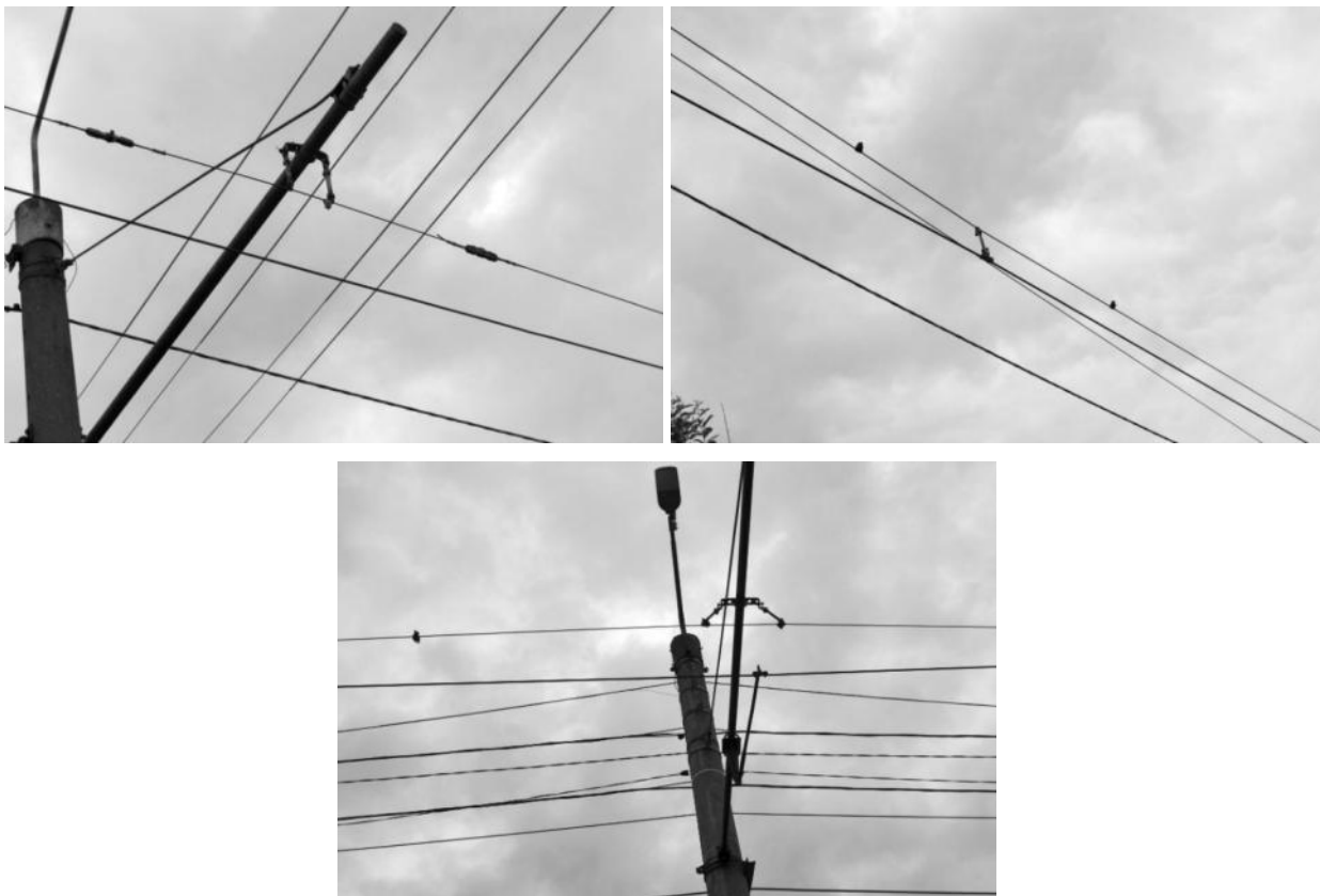
Рисунок 2.451 – Продольный стальной канат
