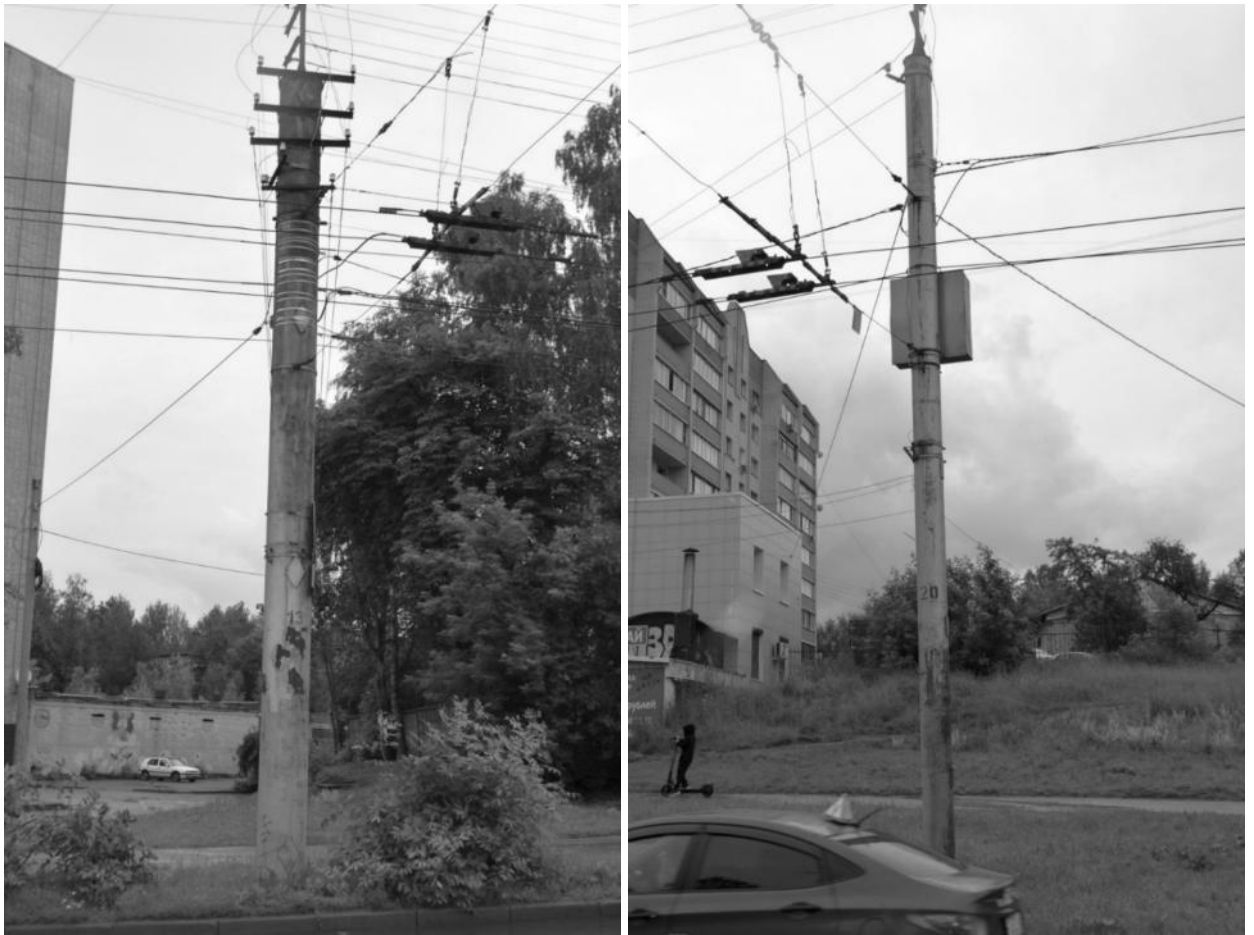
Рисунок 2.406 – Трубы имеющие как вертикальные сварные швы
