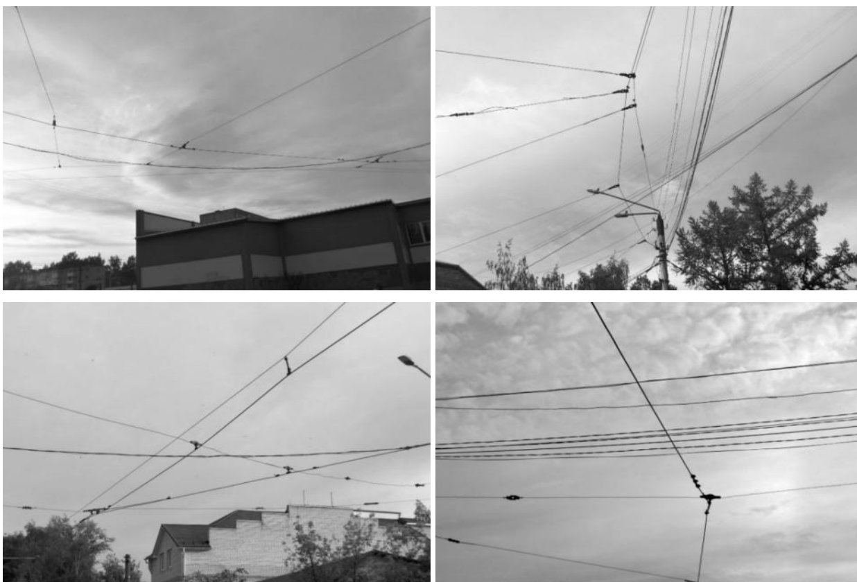
Рисунок 2.337 – Системы подвески из стальных канатов
