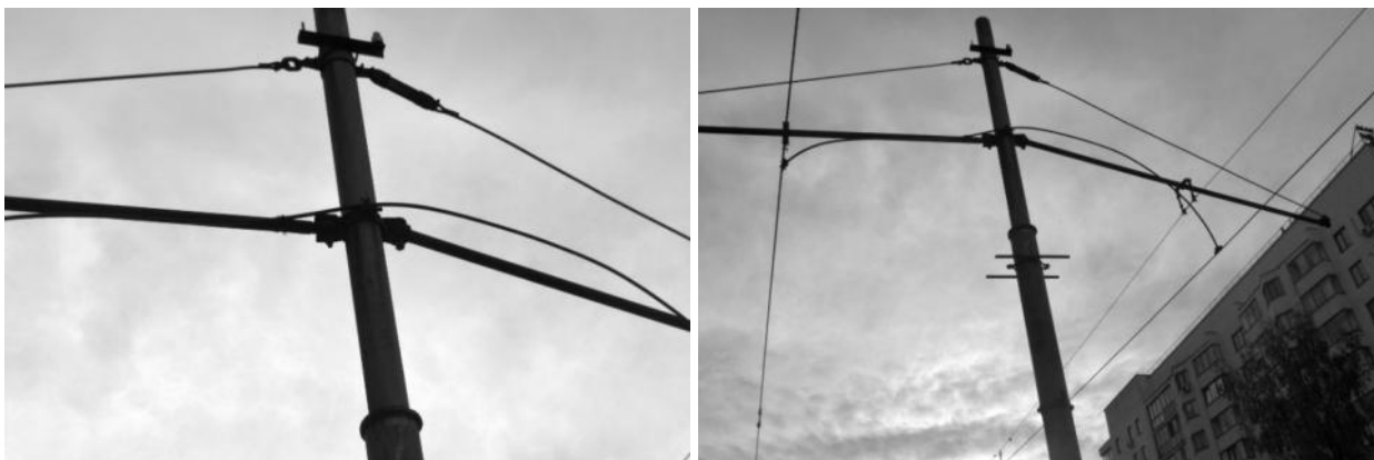
Рисунок 2.330 – Опоры контактной сети
