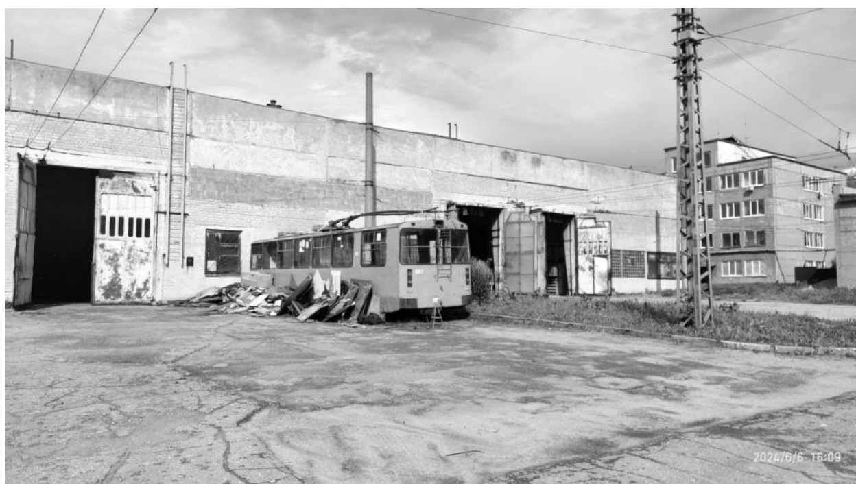
Рисунок 2.23 – Общий вид производственного корпуса на дату проведения обследования
