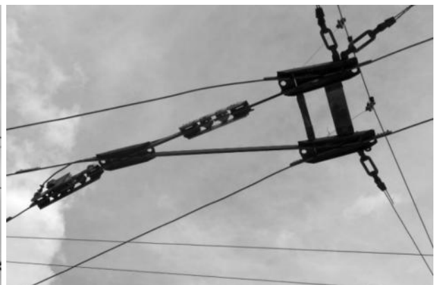
Рисунок 2.639 – Троллейбусные стрелки, находящиеся в полностью работоспособном состоянии
