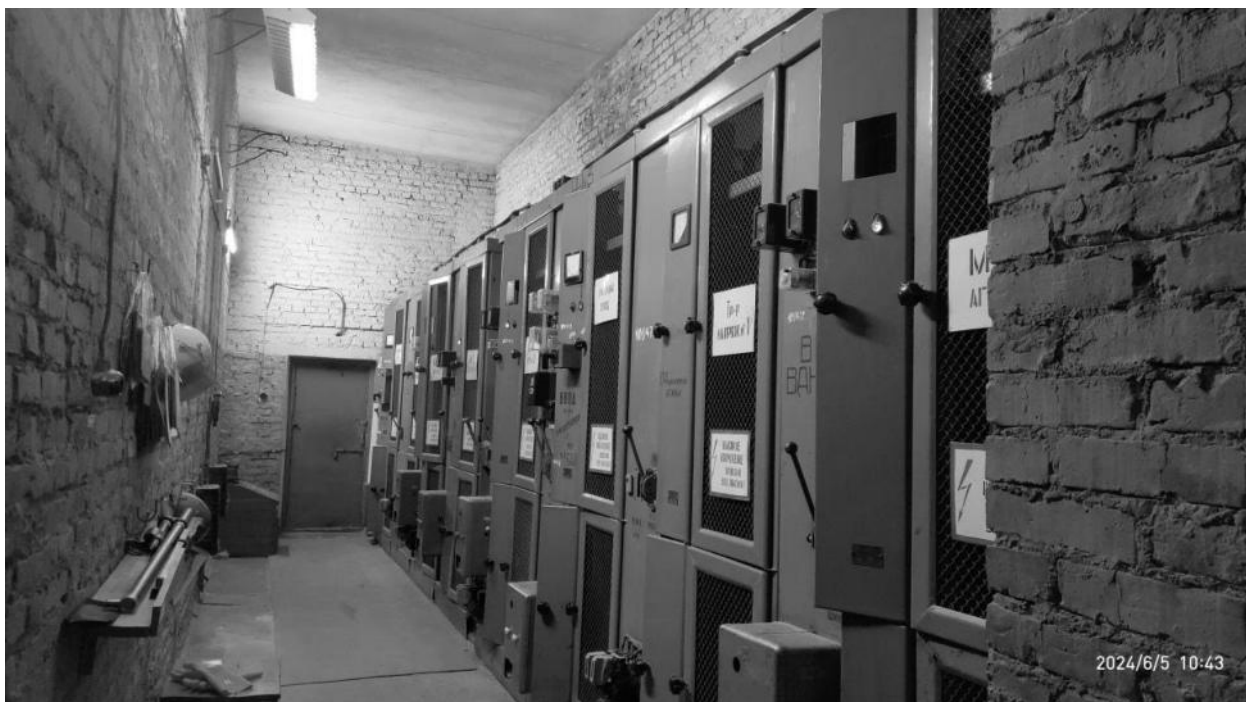
Рисунок 2.228 – Камеры РУ-6 кВ типа ЛП-318 на ТП-3
