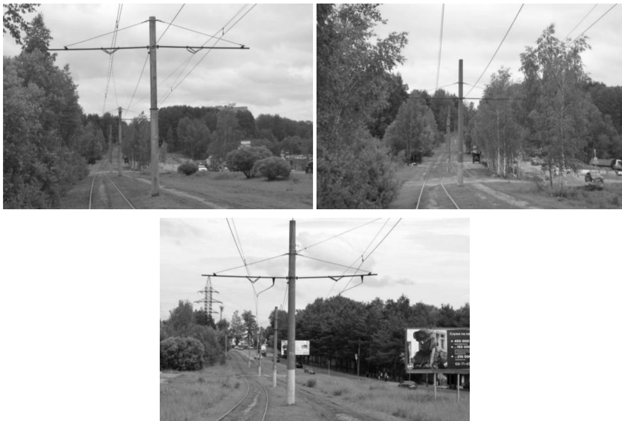
Рисунок 2.265 – Существующие опоры контактной сети
