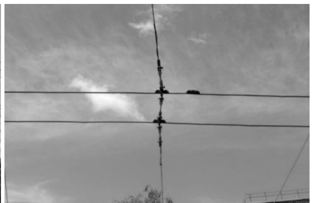
Рисунок 2.502 – Системы подвески из стальных канатов
