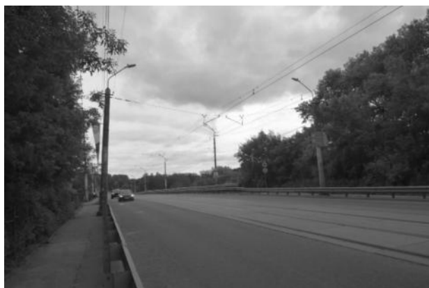
Рисунок 2.311 – Контактный провод трамвая
