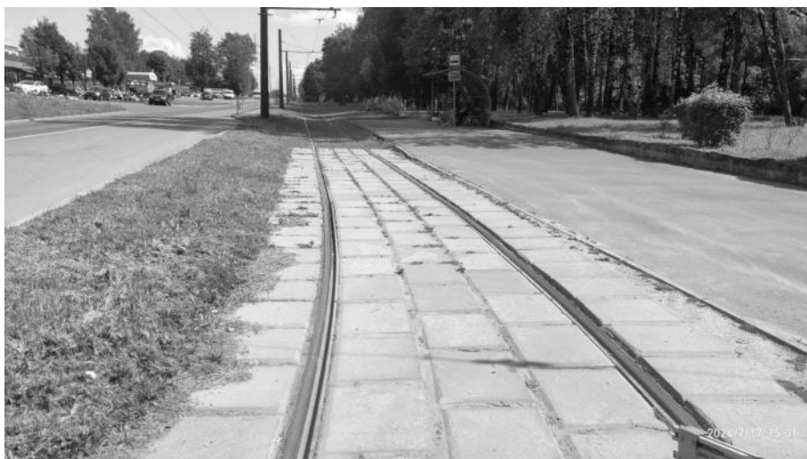
Рисунок 2.815 – Общий вид участка трамвайных путей – ул. Смольянинова, ул. Шевченко, ул. Попова
