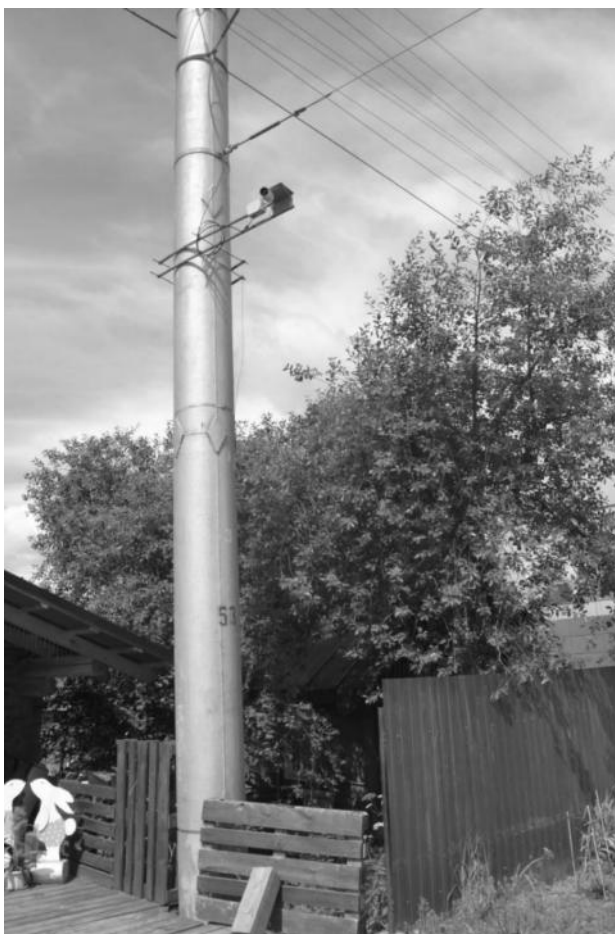
Рисунок 2.530 – Трубы, имеющие как вертикальные сварные швы
