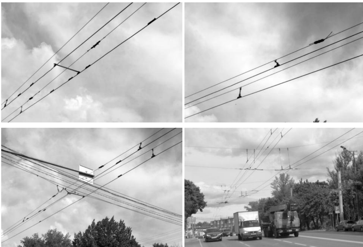
Рисунок 2.539 – Системы подвески из стальных канатов
