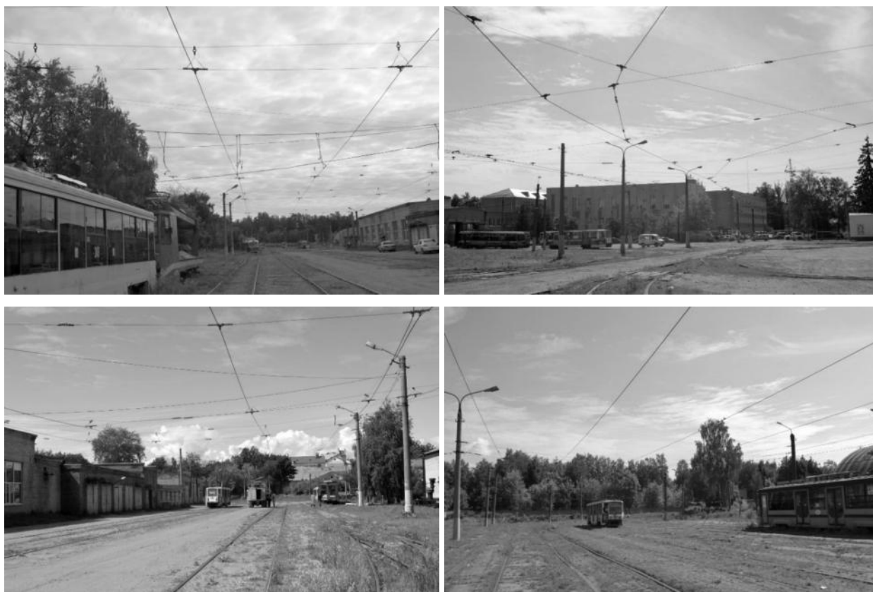
Рисунок 2.477 – Существующие опоры контактной сети
