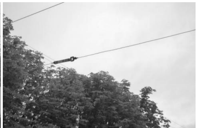
Рисунок 2.458 – Системы подвески из стальных канатов
