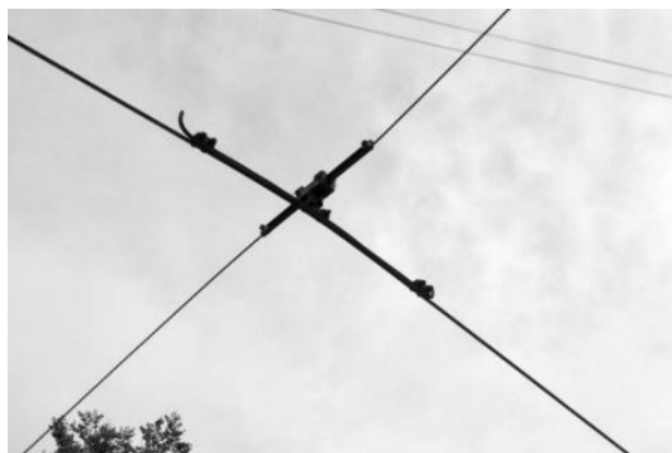
Рисунок 2.285 – Контактный провод трамвая
