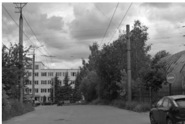
Рисунок 2.605 – Контактный провод троллейбуса
