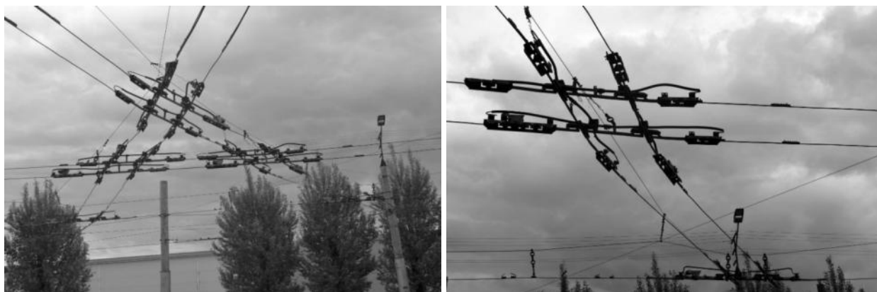
Рисунок 2.619 – Пересечения контактных проводов троллейбуса, находящихся в ограниченно пригодном состоянии и имеющее изгиб ходовых металлических шин
