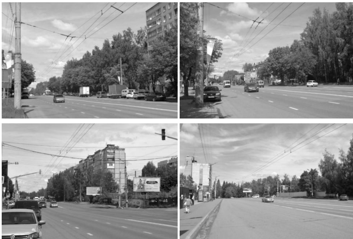
Рисунок 2.506 – Существующие опоры контактной сети
