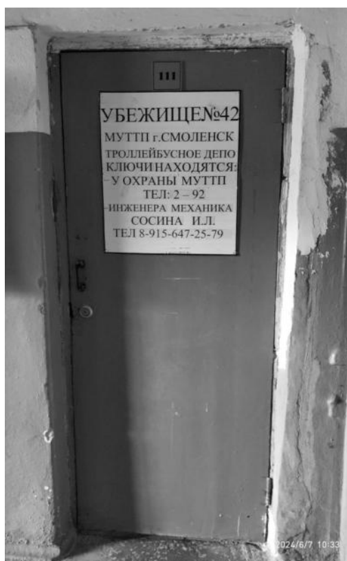
Рисунок 2.36 – Общий вид входа в бомбоубежище с 1-го этажа административно-бытового корпуса
