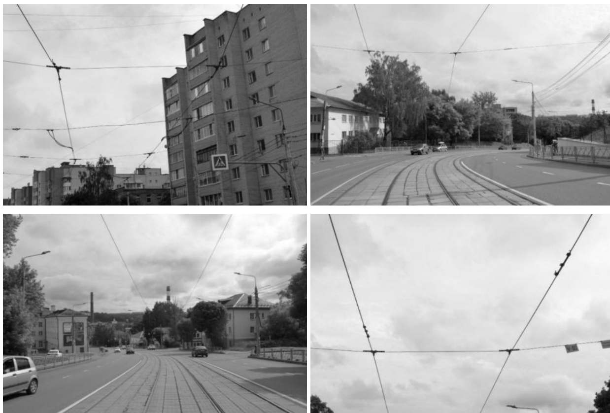
Рисунок 2.288 – Системы подвески из стальных канатов
