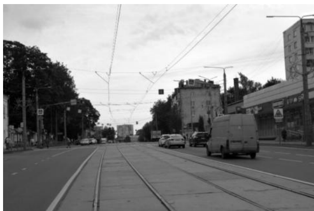
Рисунок 2.347 – Существующие опоры контактной сети
