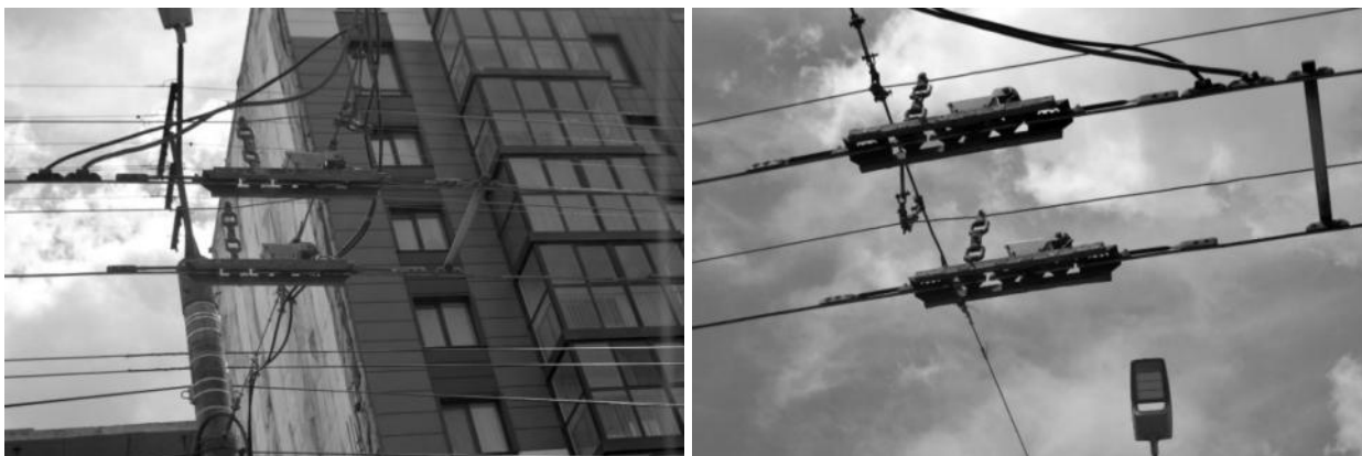
Рисунок 2.524 – Секционные изоляторы
