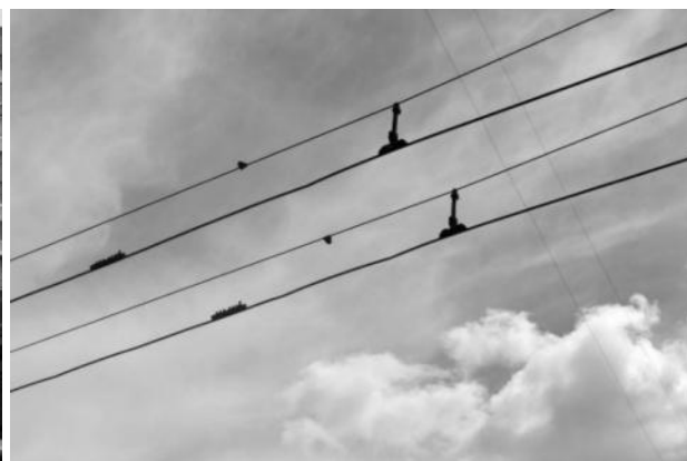
Рисунок 2.522 – Контактный провод троллейбуса
