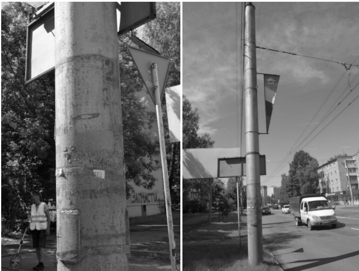
Рисунок 2.487 – Опоры контактной сети
