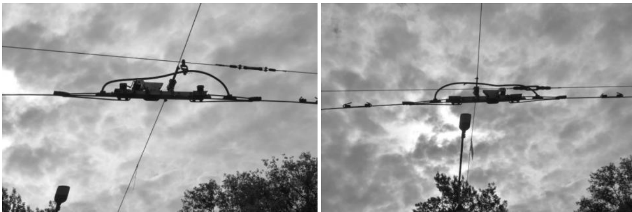
Рисунок 2.305 – Секционные изоляторы
