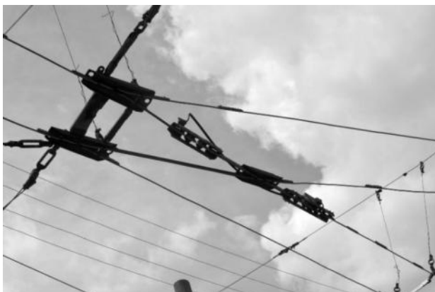
Рисунок 2.639 – Троллейбусные стрелки, находящиеся в полностью работоспособном состоянии
