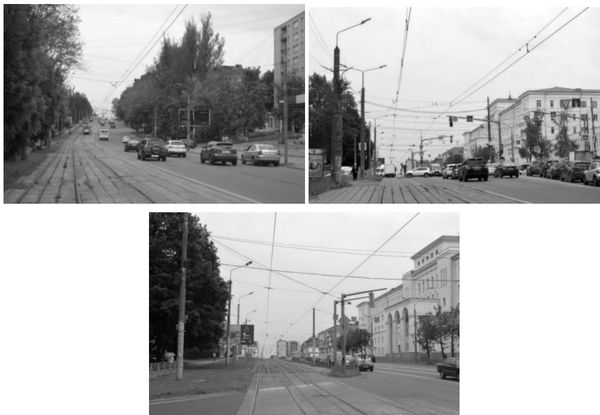
Рисунок 2.372 – Существующие опоры контактной сети
