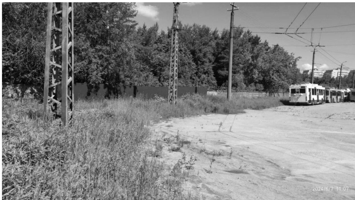
Рисунок 2.40 – Общий вид ограждений из металлопрофиля на дату проведения обследования
