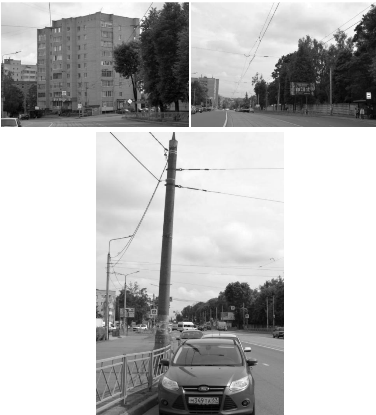
Рисунок 2.279 – Существующие опоры контактной сети
