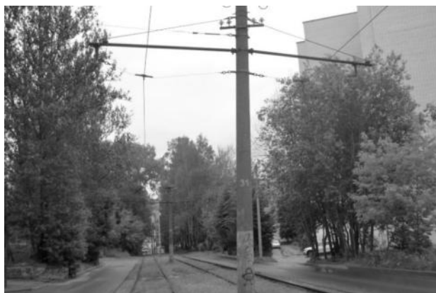
Рисунок 2.396 – Существующие опоры контактной сети
