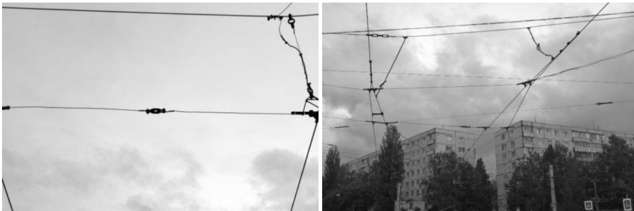
Рисунок 2.429 – Системы подвески из стальных канатов
