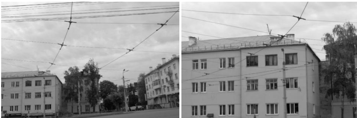
Рисунок 2.362 – Системы подвески из стальных канатов
