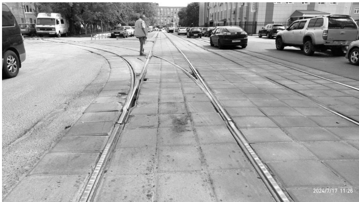
Рисунок 2.801 – Общий вид участка трамвайных путей – узел «Трамвайный проезд (заезд и выезд из депо)»
