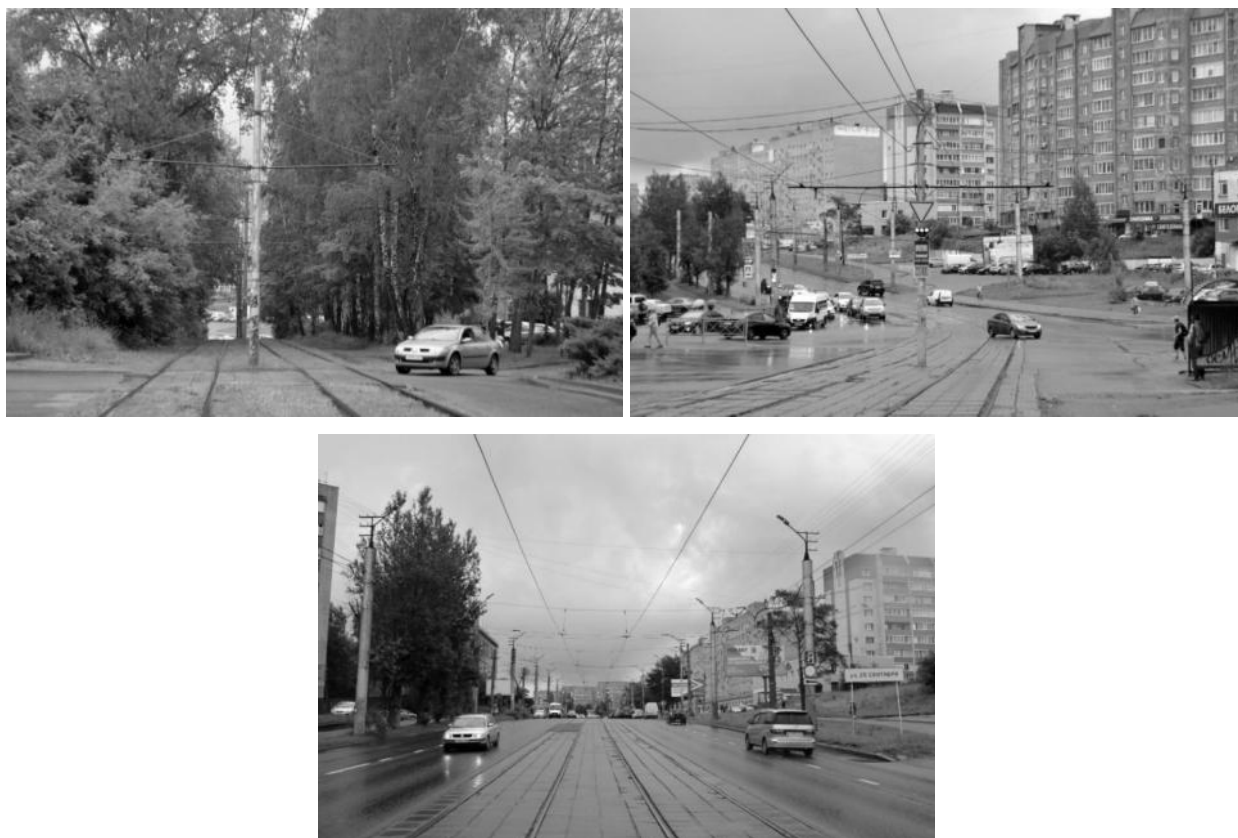
Рисунок 2.403 – Существующие опоры контактной сети
