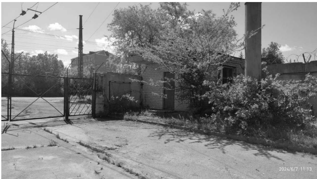
Рисунок 2.31 – Общий вид проходной №2 на дату проведения обследования
