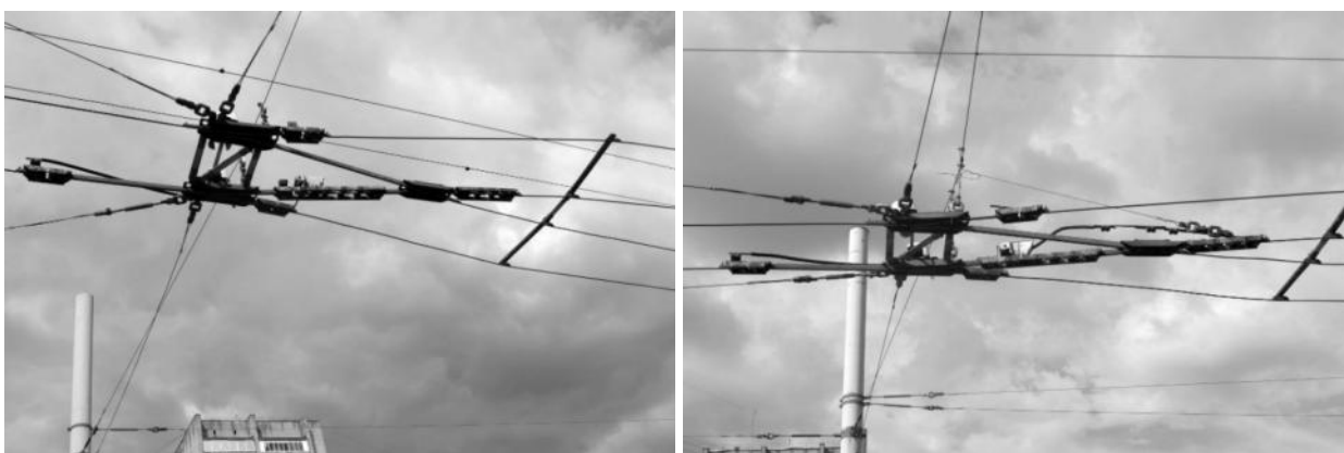
Рисунок 2.559 – Спецчасти на участке контактной сети
