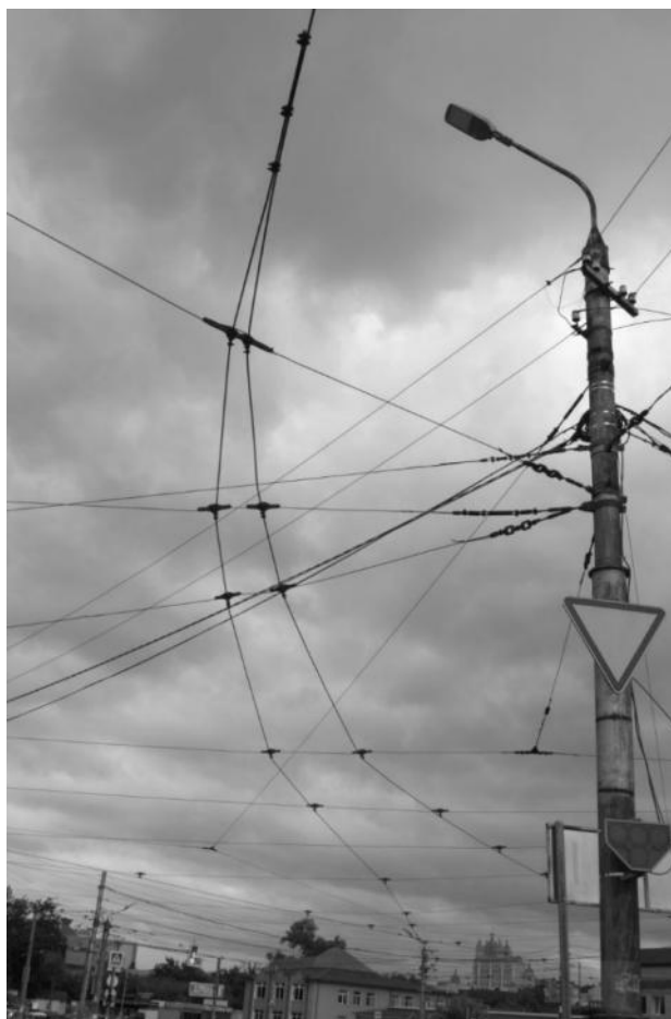
Рисунок 2.307 – Системы подвески из стальных канатов
