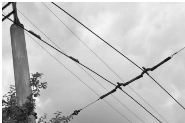
Рисунок 2.607 – Системы подвески из стальных канатов
