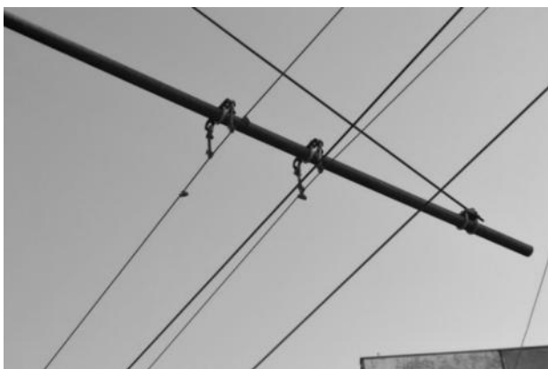
Рисунок 2.575 – Системы подвески из стальных канатов
