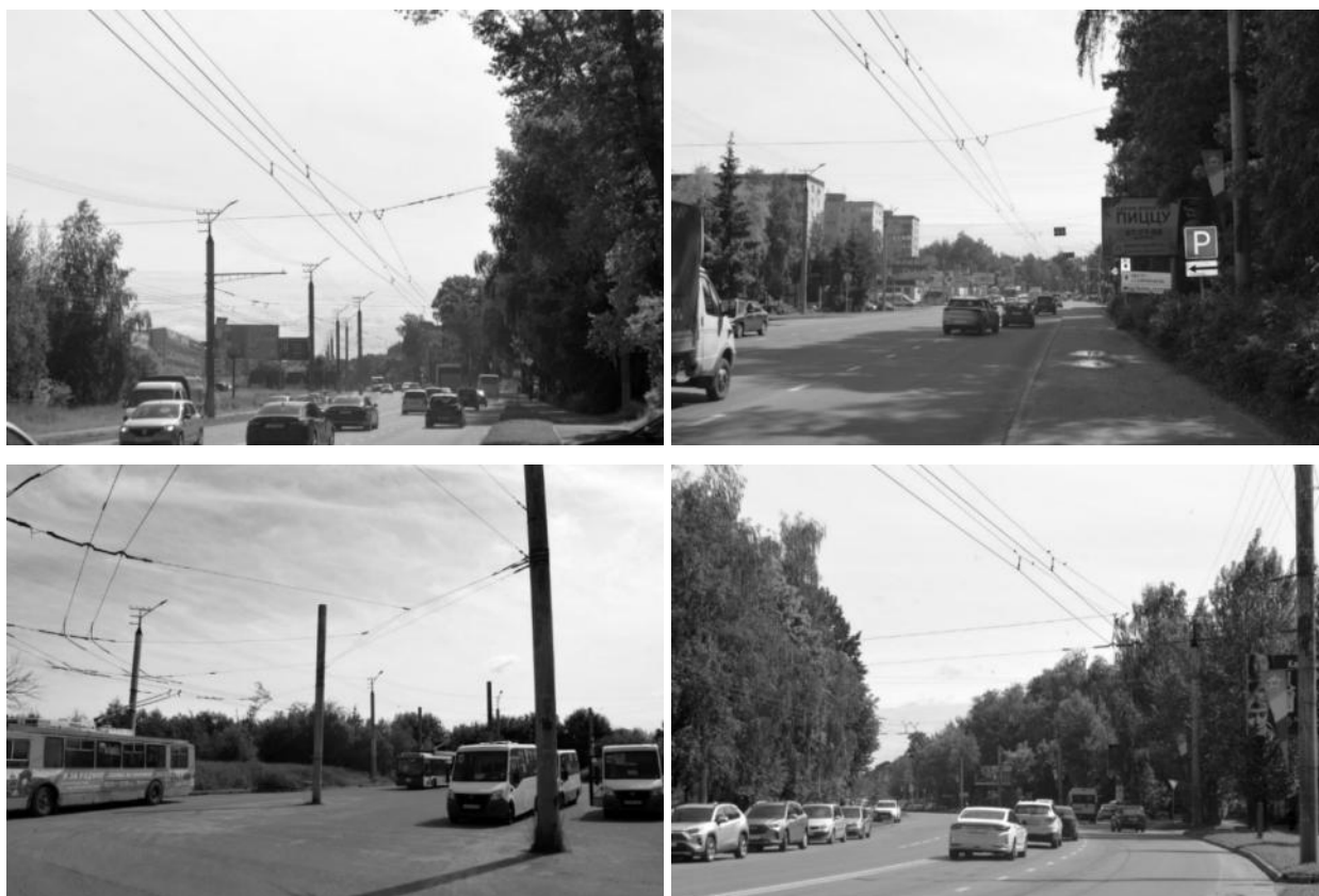
Рисунок 2.486 – Существующие опоры контактной сети
