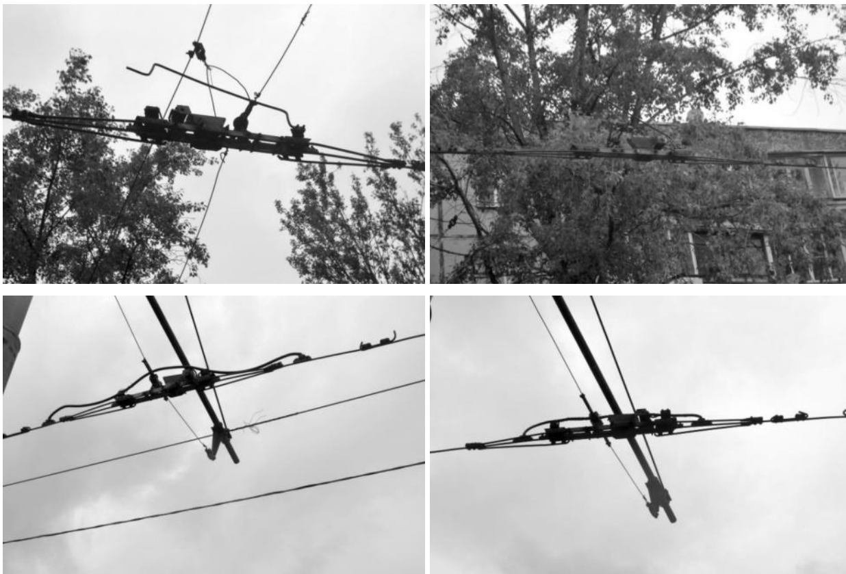
Рисунок 2.384 – Секционные изоляторы
