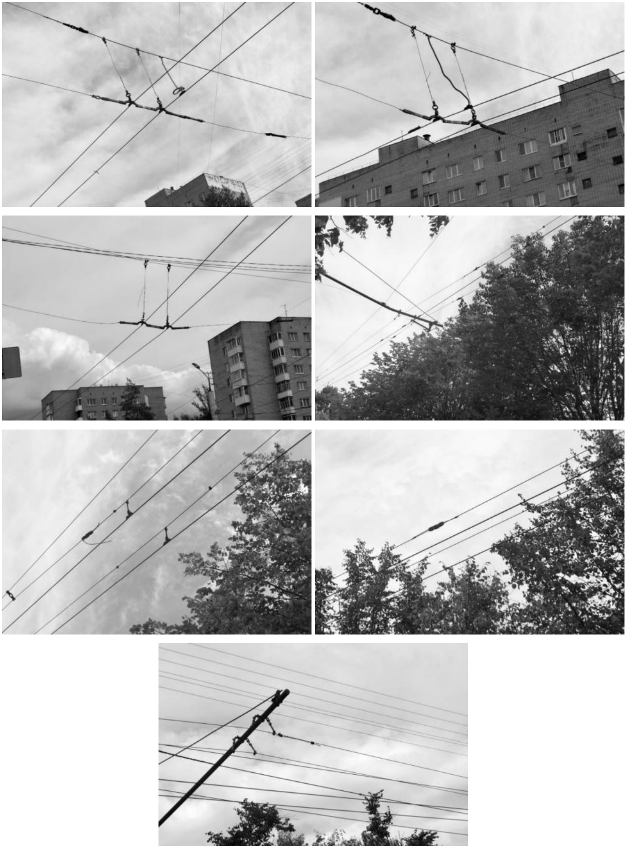
Рисунок 2.557 – Системы подвески из стальных канатов
