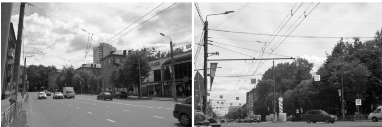
Рисунок 2.513 – Существующие опоры контактной сети
