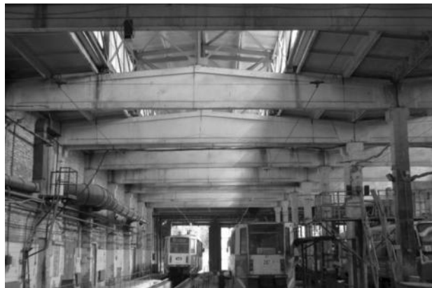
Рисунок 2.481 – Подвески из стальных канатов
