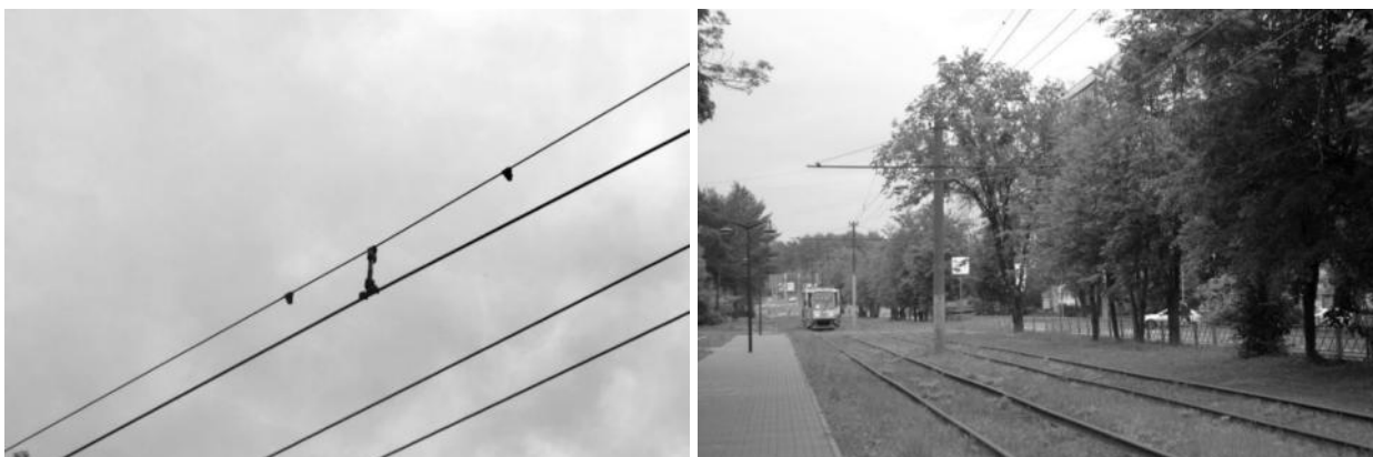
Рисунок 2.465 – Продольный стальной канат
