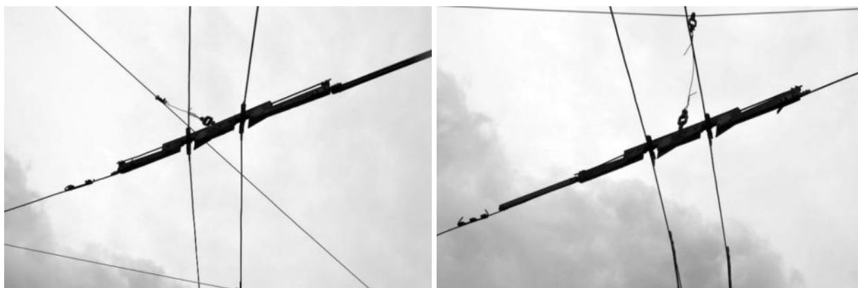
Рисунок 2.412 – Пересечения контактных проводов трамвая и троллейбуса
