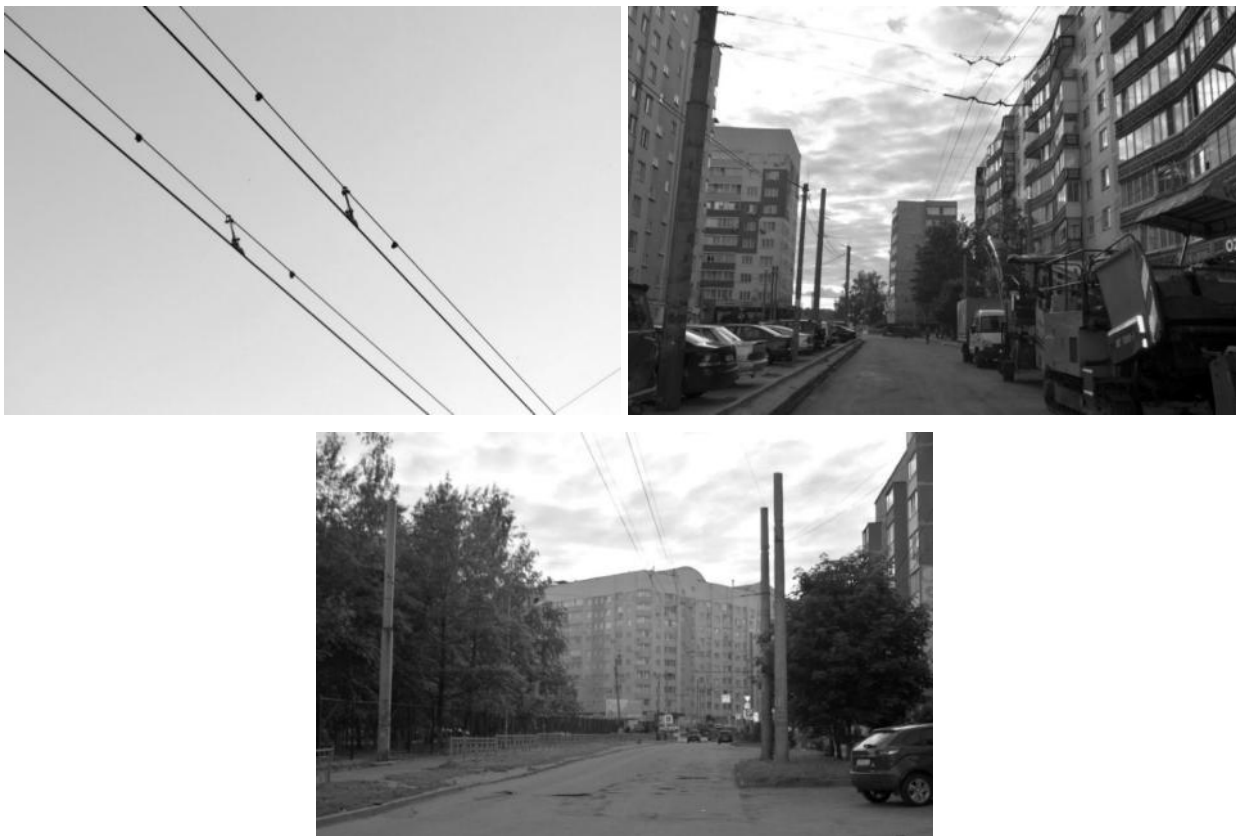
Рисунок 2.581 – Контактный провод троллейбуса
