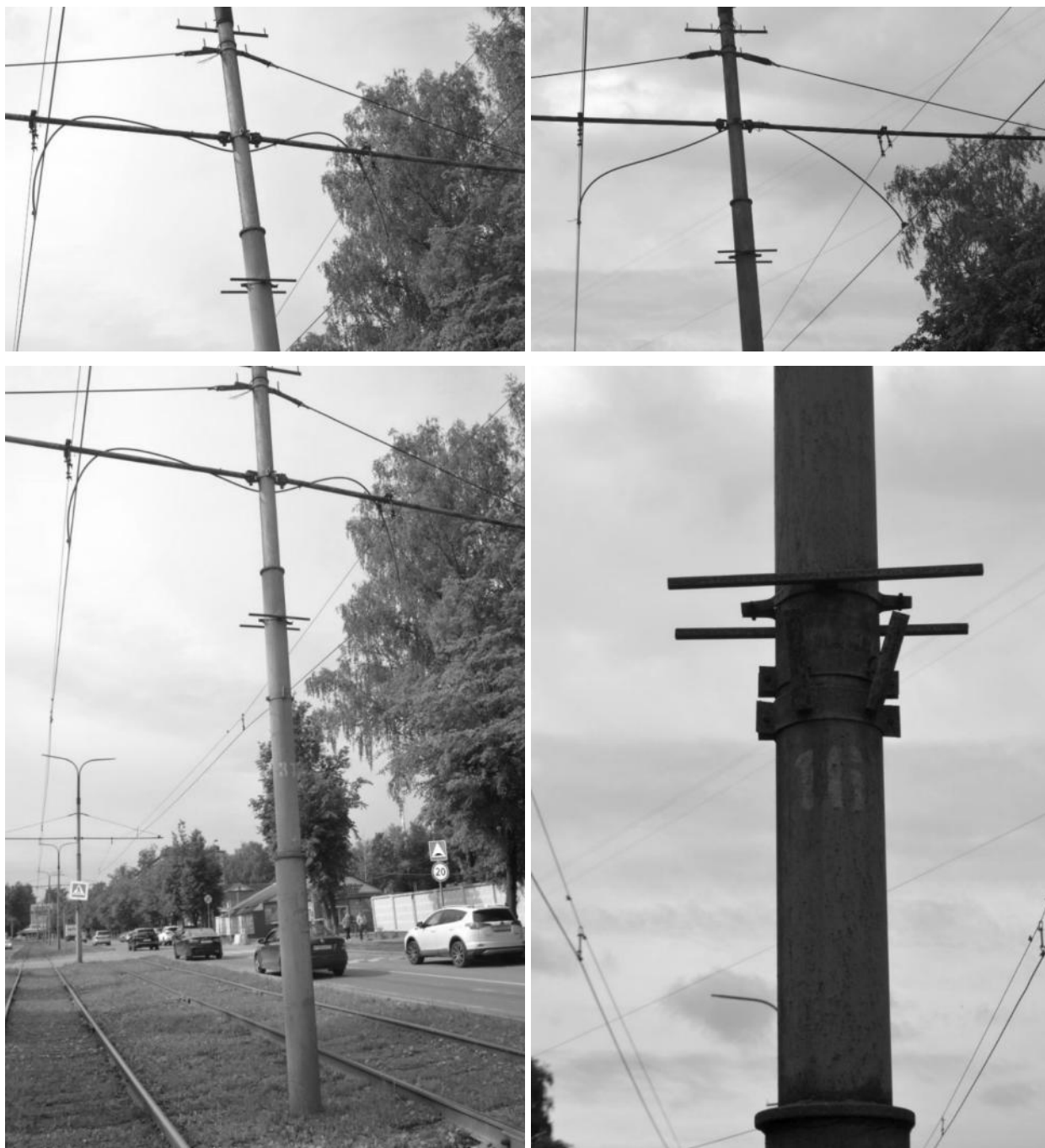
Рисунок 2.345 – Межпутная перемычка
