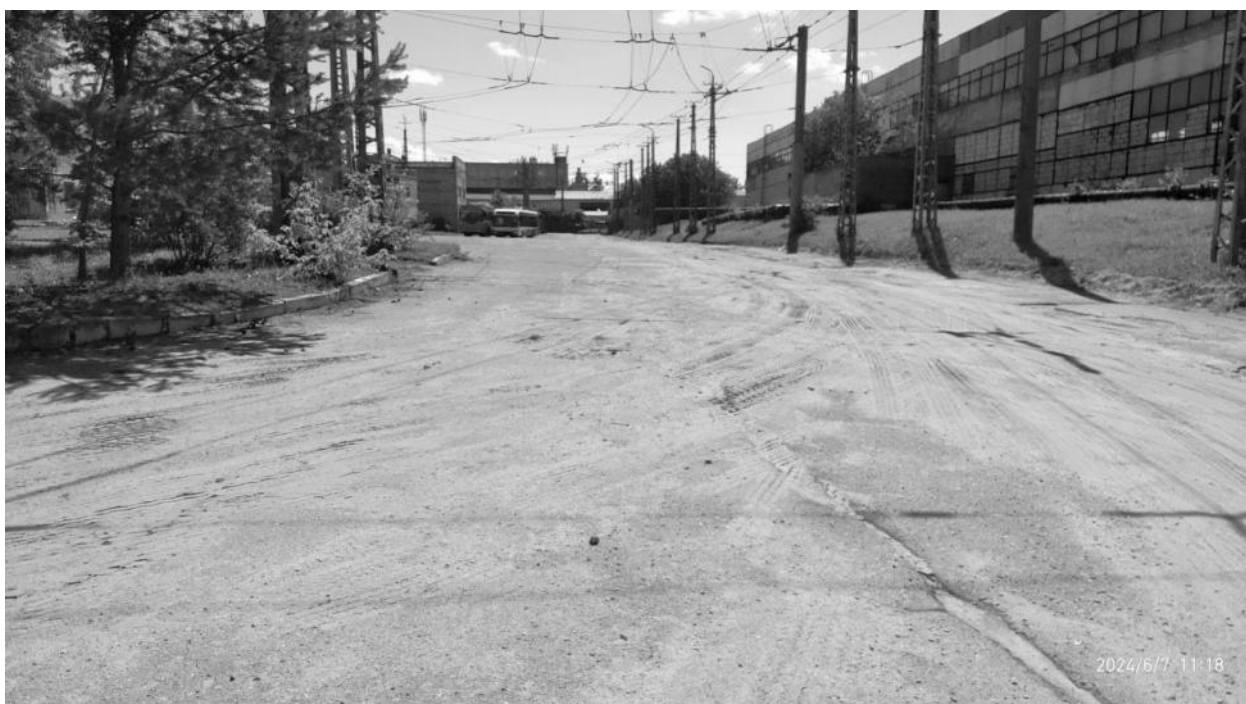
Рисунок 2.38 – Общий вид асфальтобетонного покрытия территории депо на дату проведения обследования
