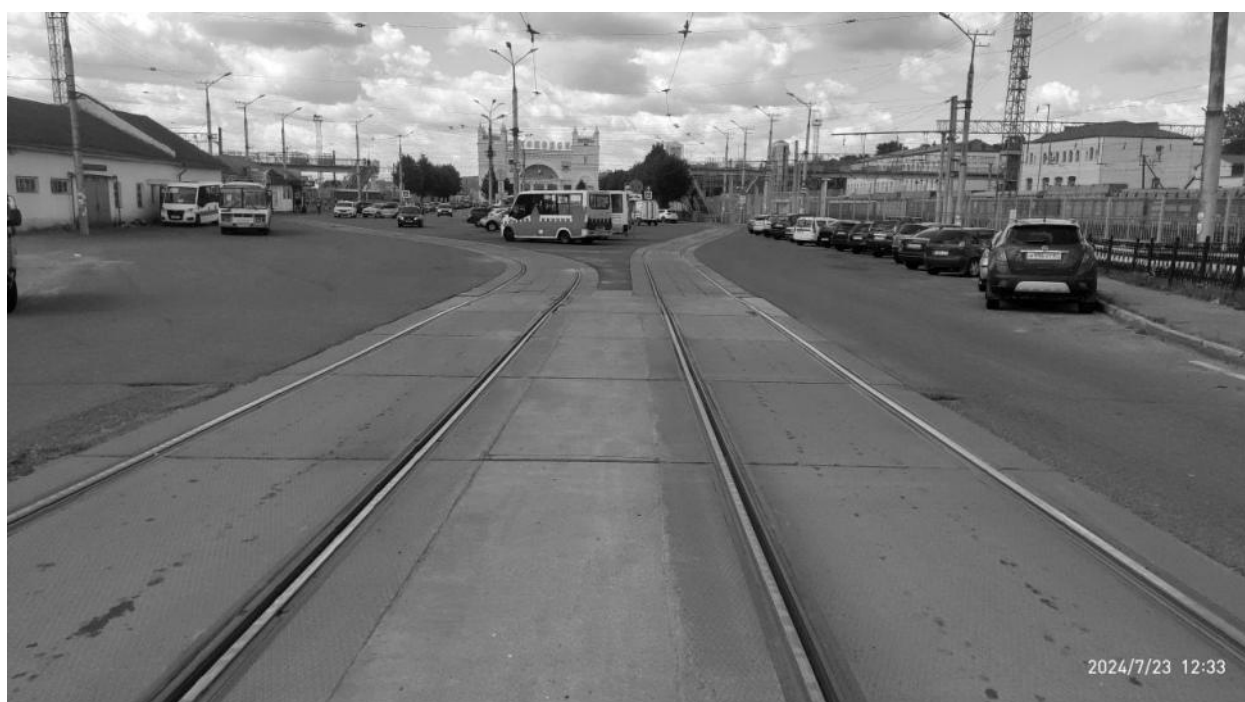
Рисунок 2.843 – Общий вид участка трамвайных путей – Привокзальная пл.
