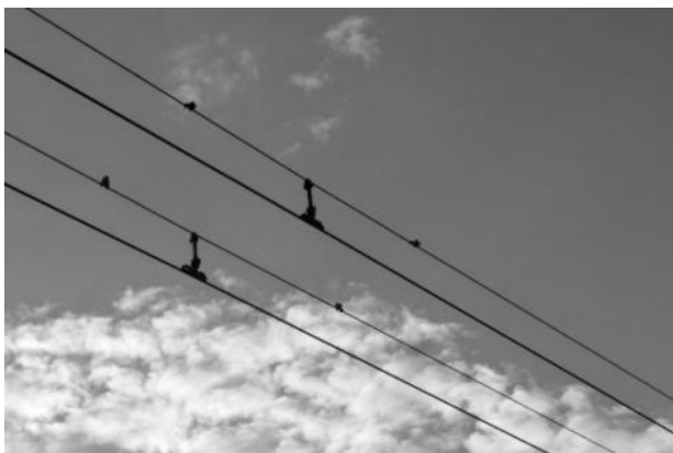
Рисунок 2.580 – Контактный провод троллейбуса
