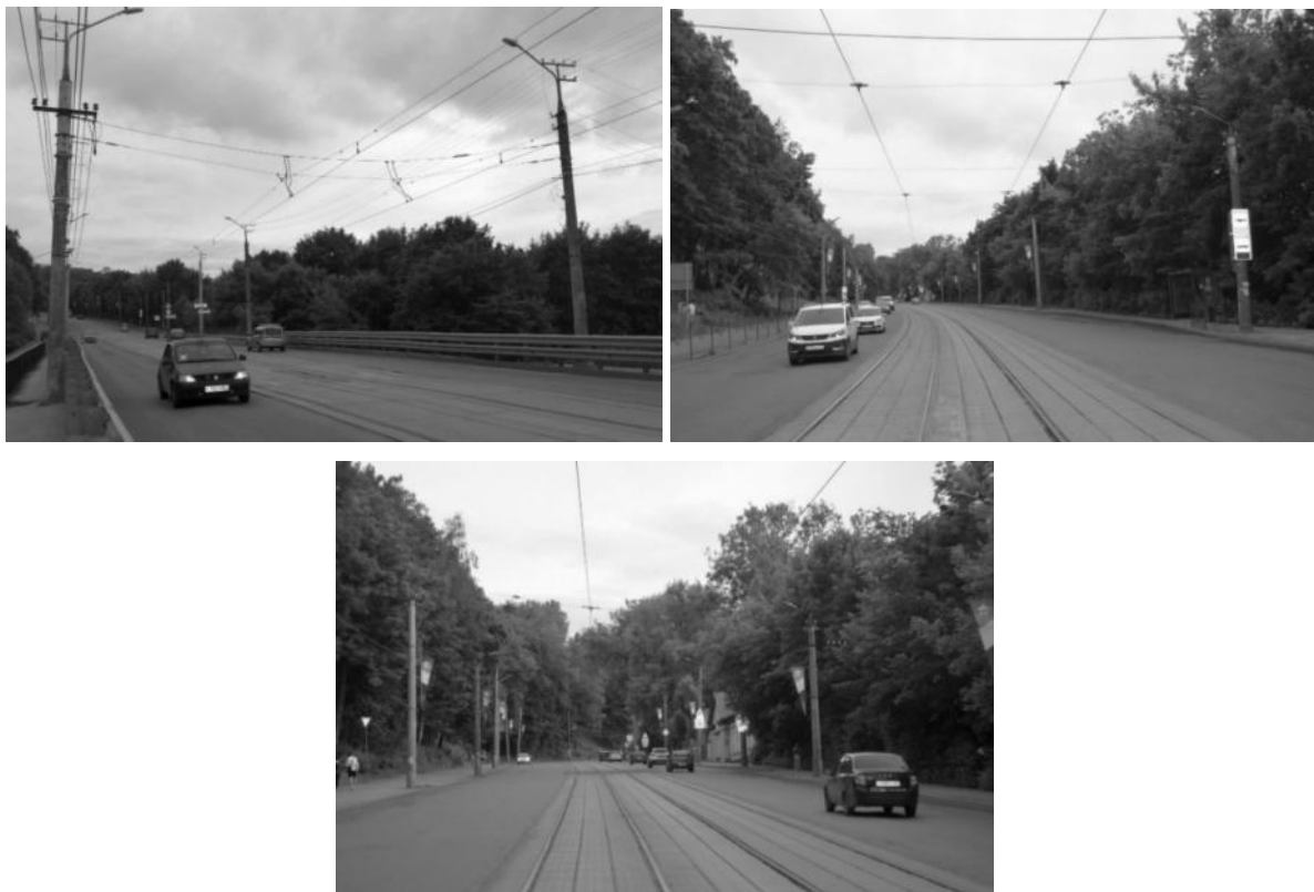
Рисунок 2.314 – Существующие опоры контактной сети
