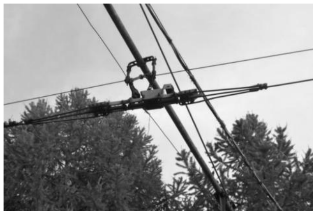
Рисунок 2.327 – Секционные изоляторы
