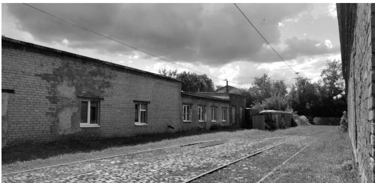
Рисунок 2.69 – Общий вид здания склада ГСМ, НС и гаража
