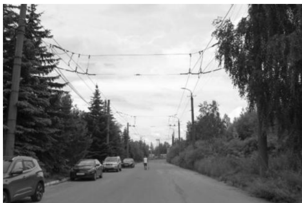
Рисунок 2.601 – Существующие опоры контактной сети
