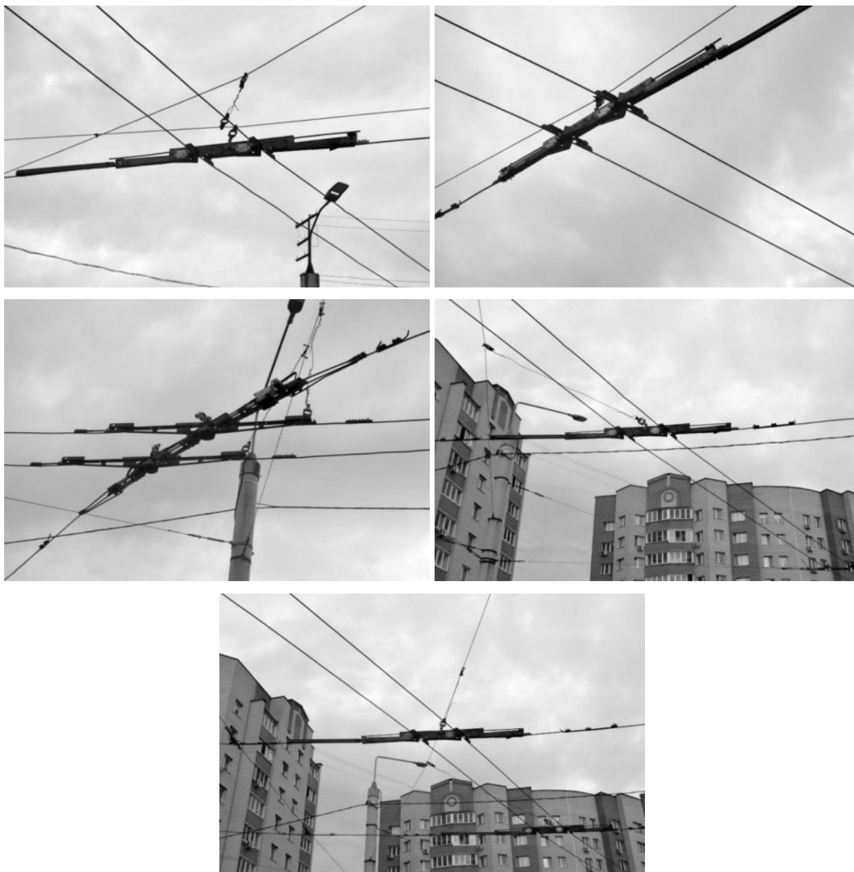
Рисунок 2.476 – Пересечения контактных проводов трамвая и троллейбуса
