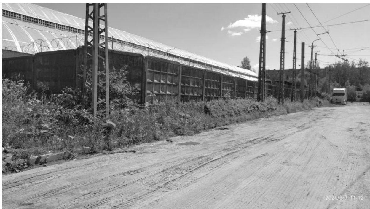
Рисунок 2.41 – Общий вид бетонных ограждений на дату проведения обследования
