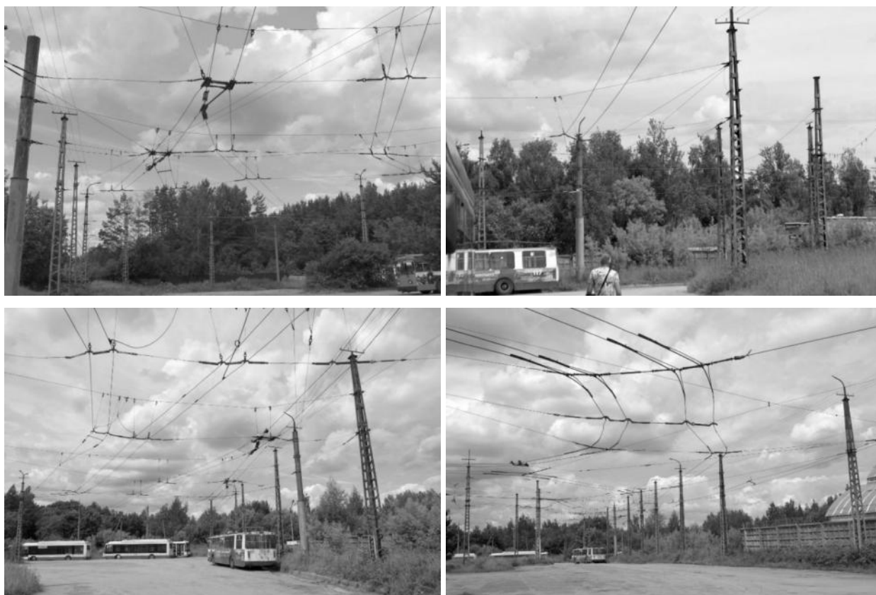
Рисунок 2.88 – Опоры КС
