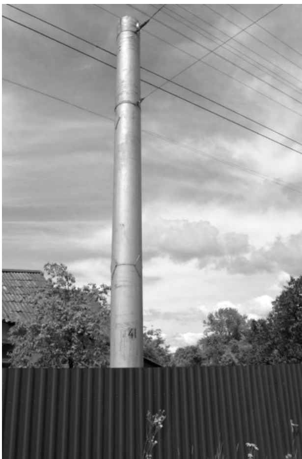
Рисунок 2.529 – Трубы, имеющие как вертикальные сварные швы
