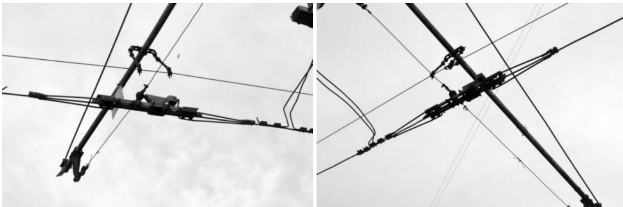
Рисунок 2.336 – Секционные изоляторы
