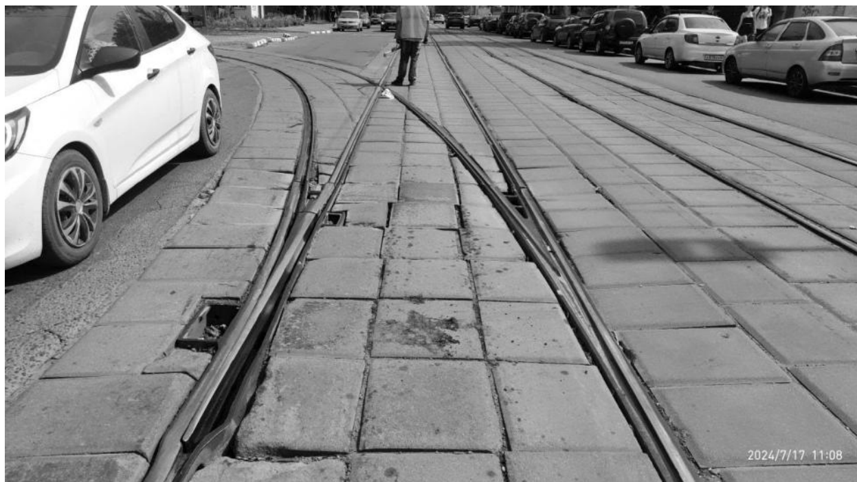
Рисунок 2.799 – Общий вид участка трамвайных путей – узел «Трамвайный проезд (выезд из депо)»
