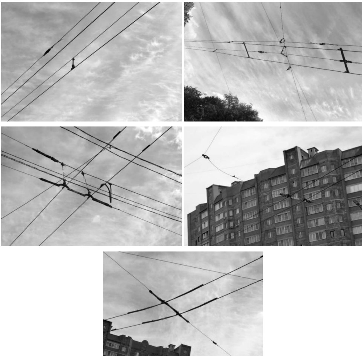
Рисунок 2.548 – Системы подвески из стальных канатов
