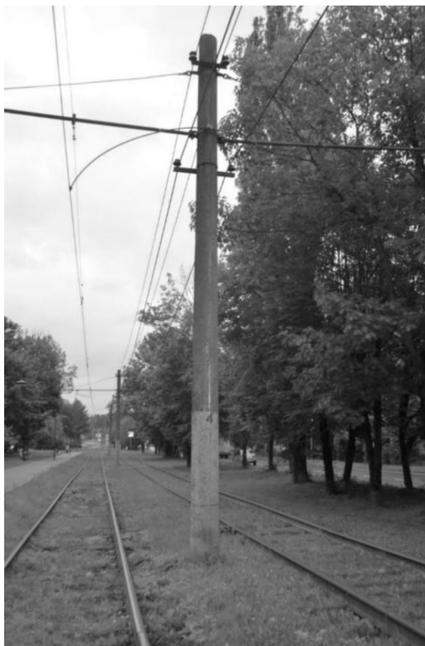
Рисунок 2.468 – Опоры контактной сети
