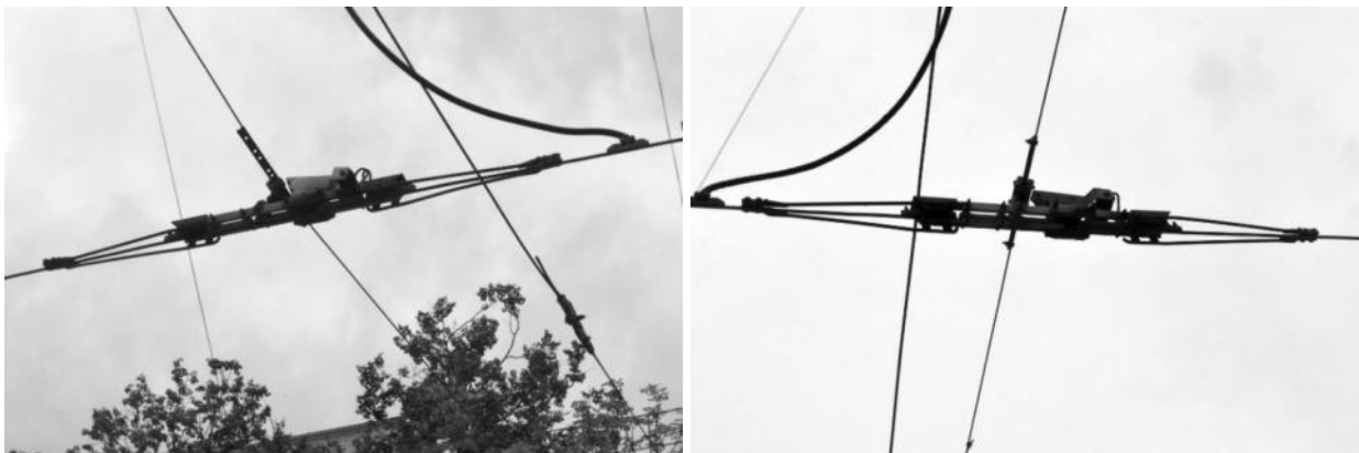
Рисунок 2.355 – Секционные изоляторы
