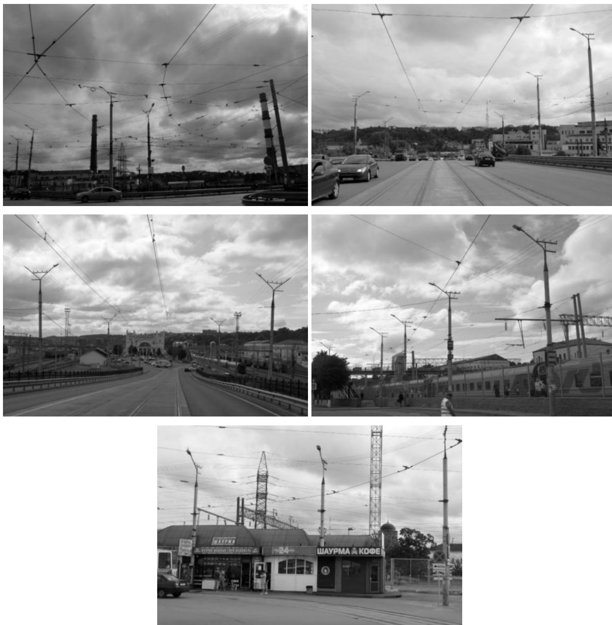
Рисунок 2.293 – Системы подвески из стальных канатов
