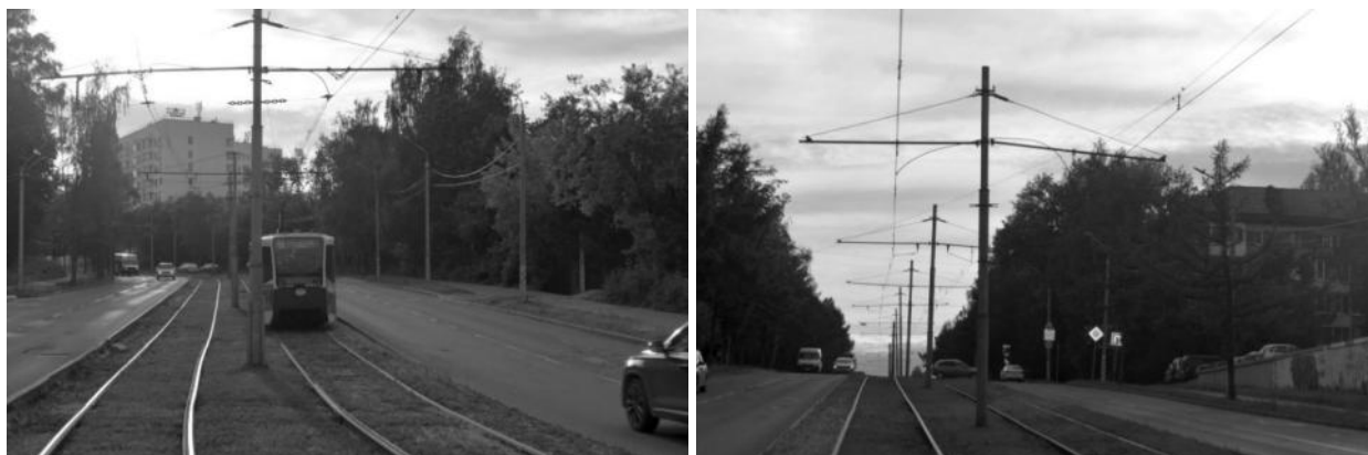
Рисунок 2.323 – Существующие опоры контактной сети
