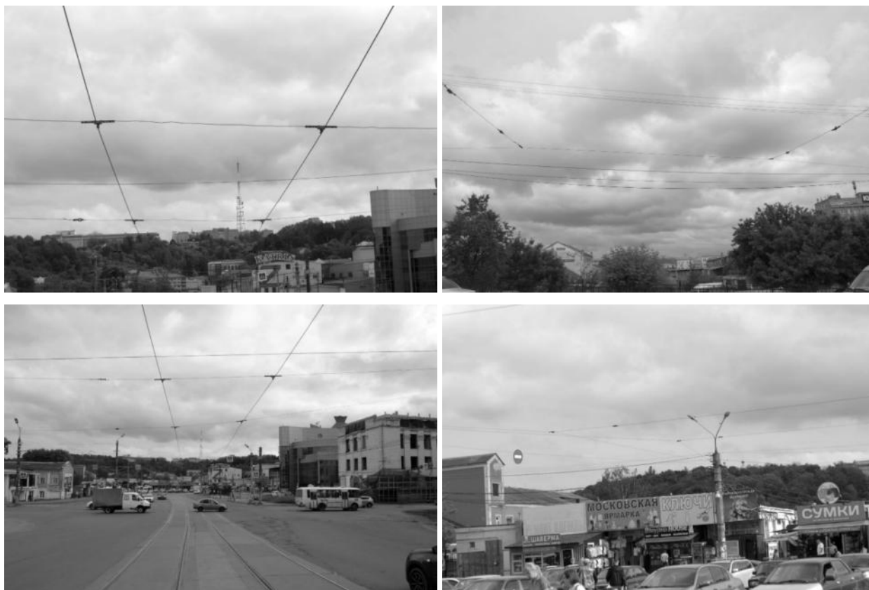
Рисунок 2.297 – Системы подвески из стальных канатов
