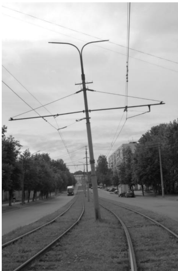
Рисунок 2.340– Существующие опоры контактной сети
