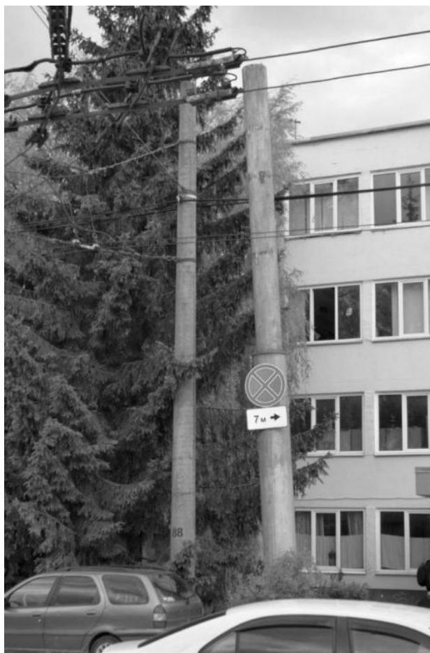
Рисунок 2.603 – Металлическая опора, выведенная из эксплуатации и подлежащая демонтажу
