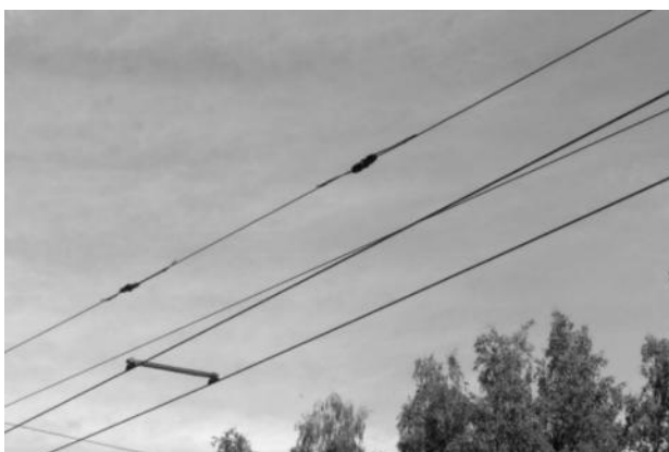
Рисунок 2.510 – Системы подвески из стальных канатов
