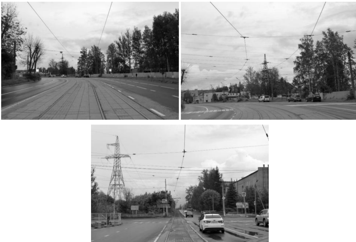
Рисунок 2.432 – Существующие опоры контактной сети
