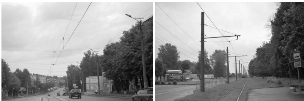
Рисунок 2.455 – Существующие опоры контактной сети
