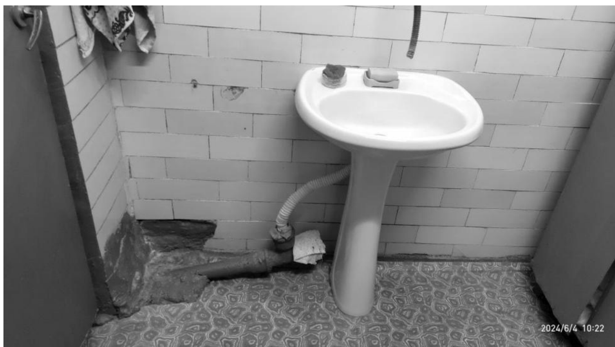
Рисунок 2.191 – Внутренний вид ТП-5
