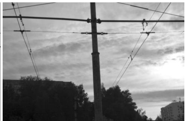
Рисунок 2.325 – Контактный провод трамвая
