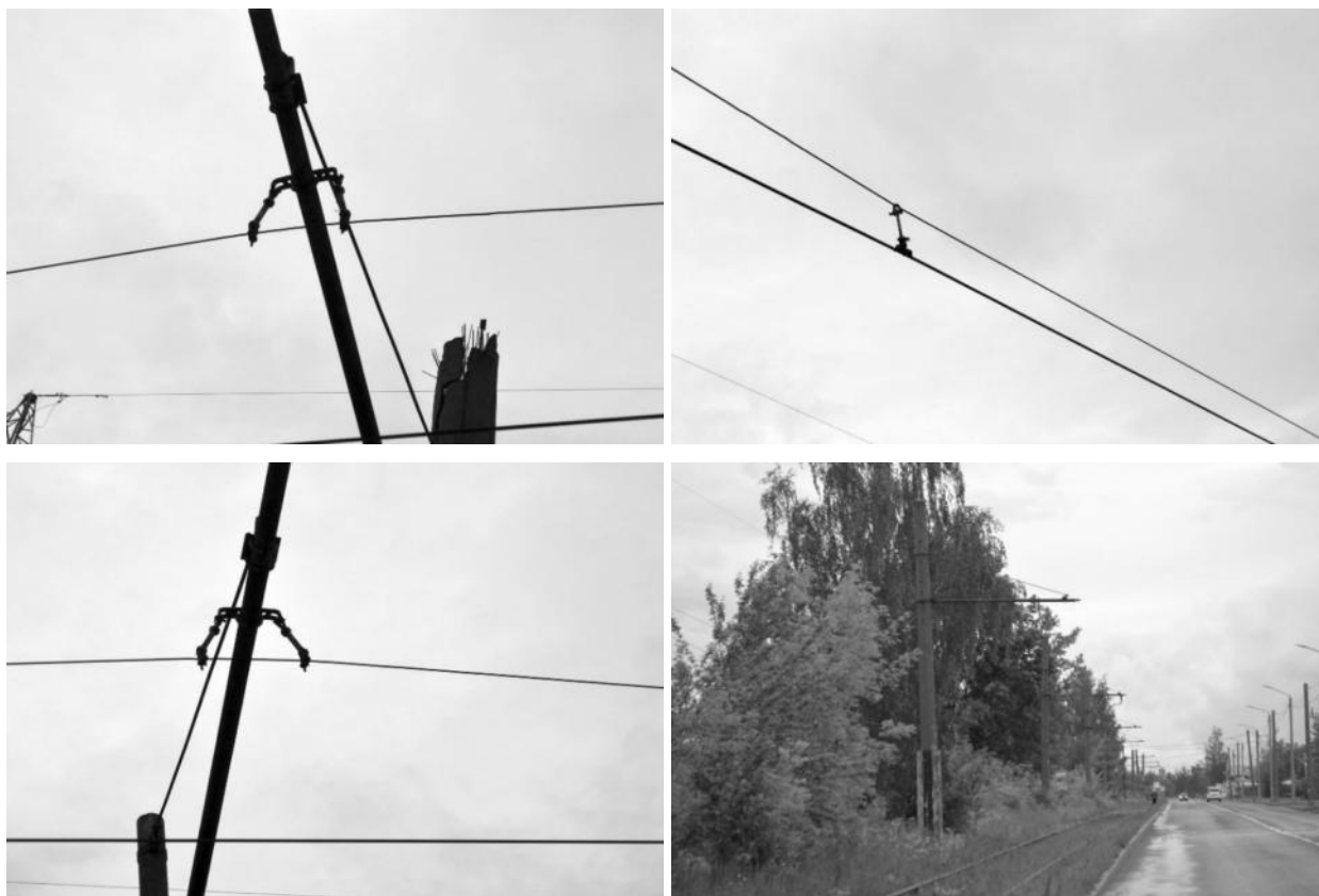
Рисунок 2.443 – Системы подвески из стальных канатов
