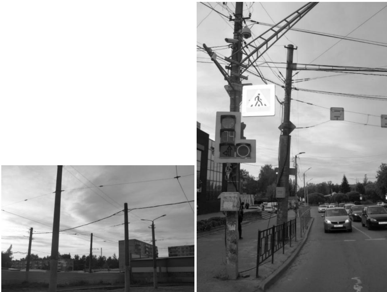
Рисунок 2.332 – Существующие опоры контактной сети
