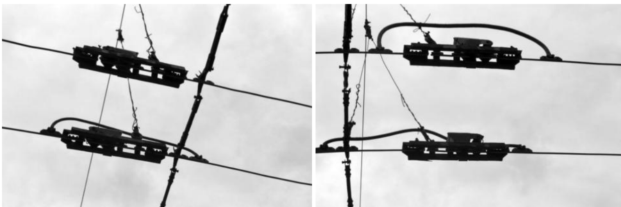
Рисунок 2.625 – Секционные изоляторы
