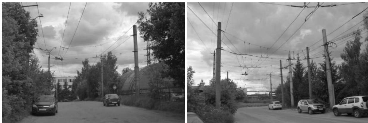
Рисунок 2.600 – Существующие опоры контактной сети
