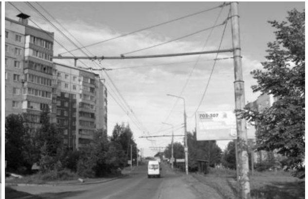
Рисунок 2.566 – Контактный провод троллейбуса
