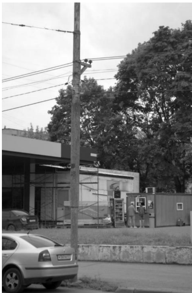
Рисунок 2.373 – Металлическая опора контактной сети
