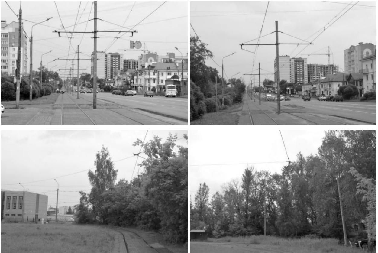
Рисунок 2.386 – Существующие опоры контактной сети
