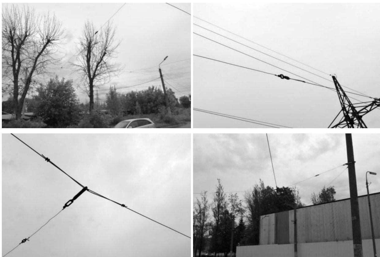
Рисунок 2.436 – Системы подвески из стальных канатов
