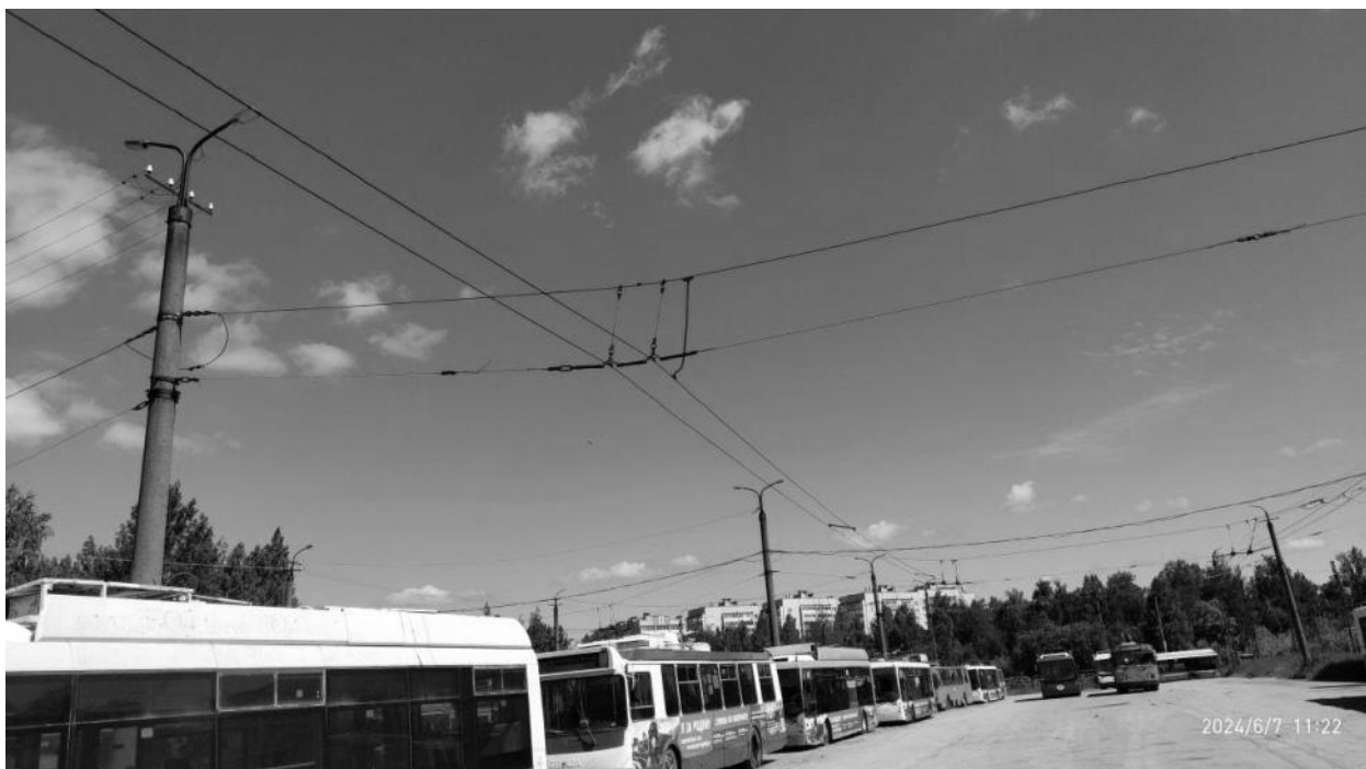
Рисунок 2.42 – Общий вид уличного освещения на дату проведения обследования
