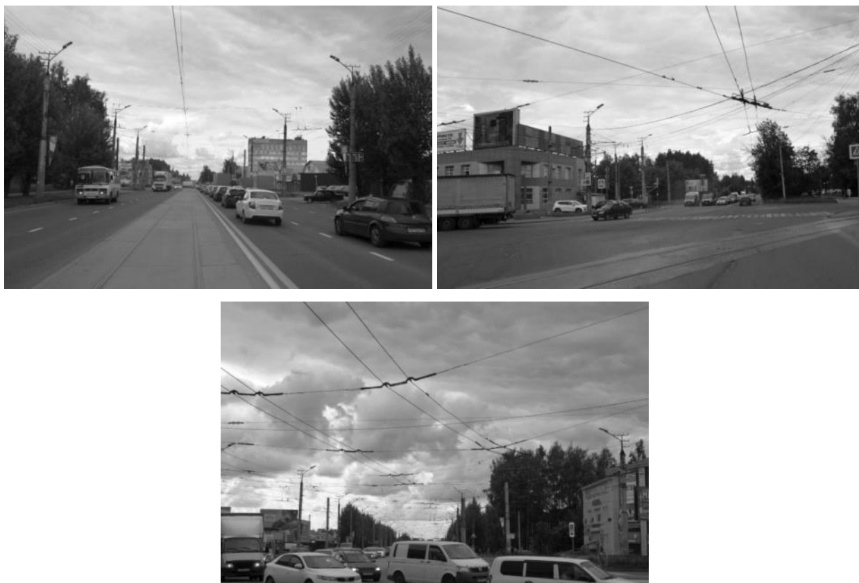
Рисунок 2.621 – Существующие опоры контактной сети
