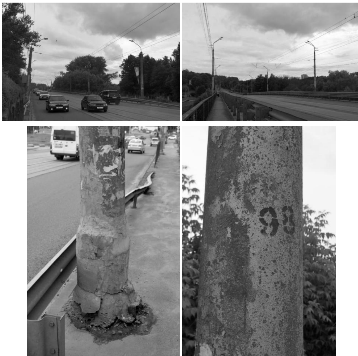
Рисунок 2.308 – Существующие опоры контактной сети
