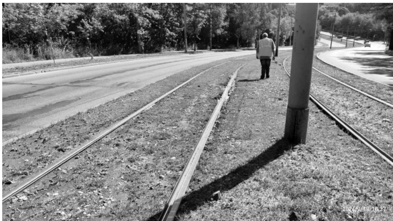
Рисунок 2.829 – Общий вид участка трамвайных путей – ул. Нахимова
