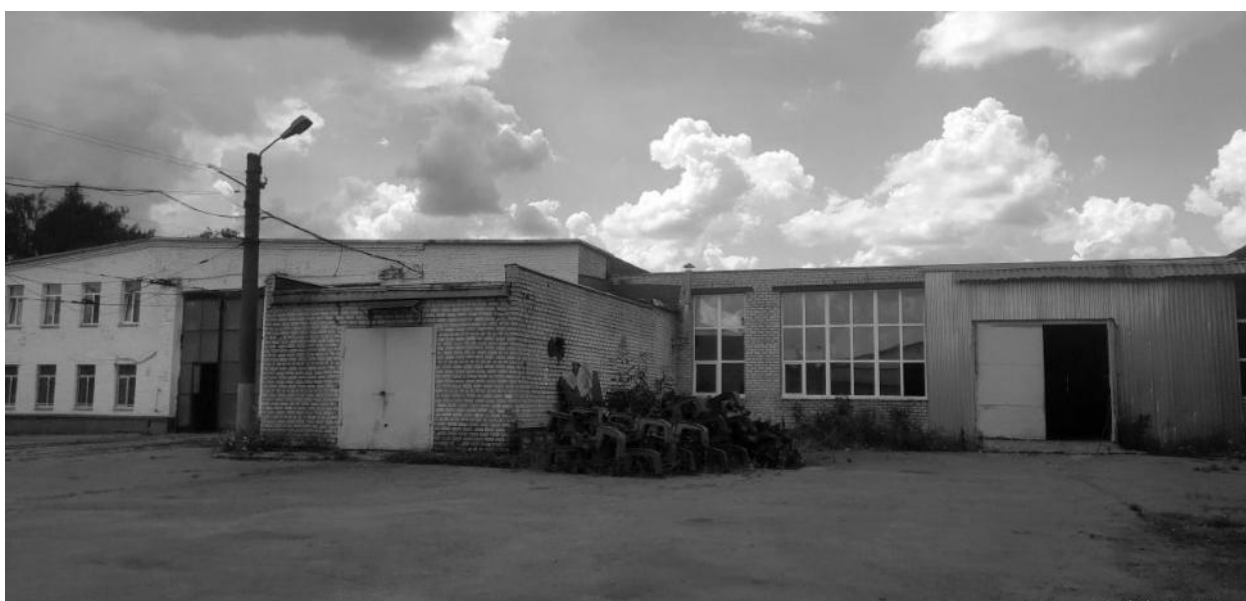
Рисунок 2.61 – Общий вид ПК депо №1 на дату проведения обследования
