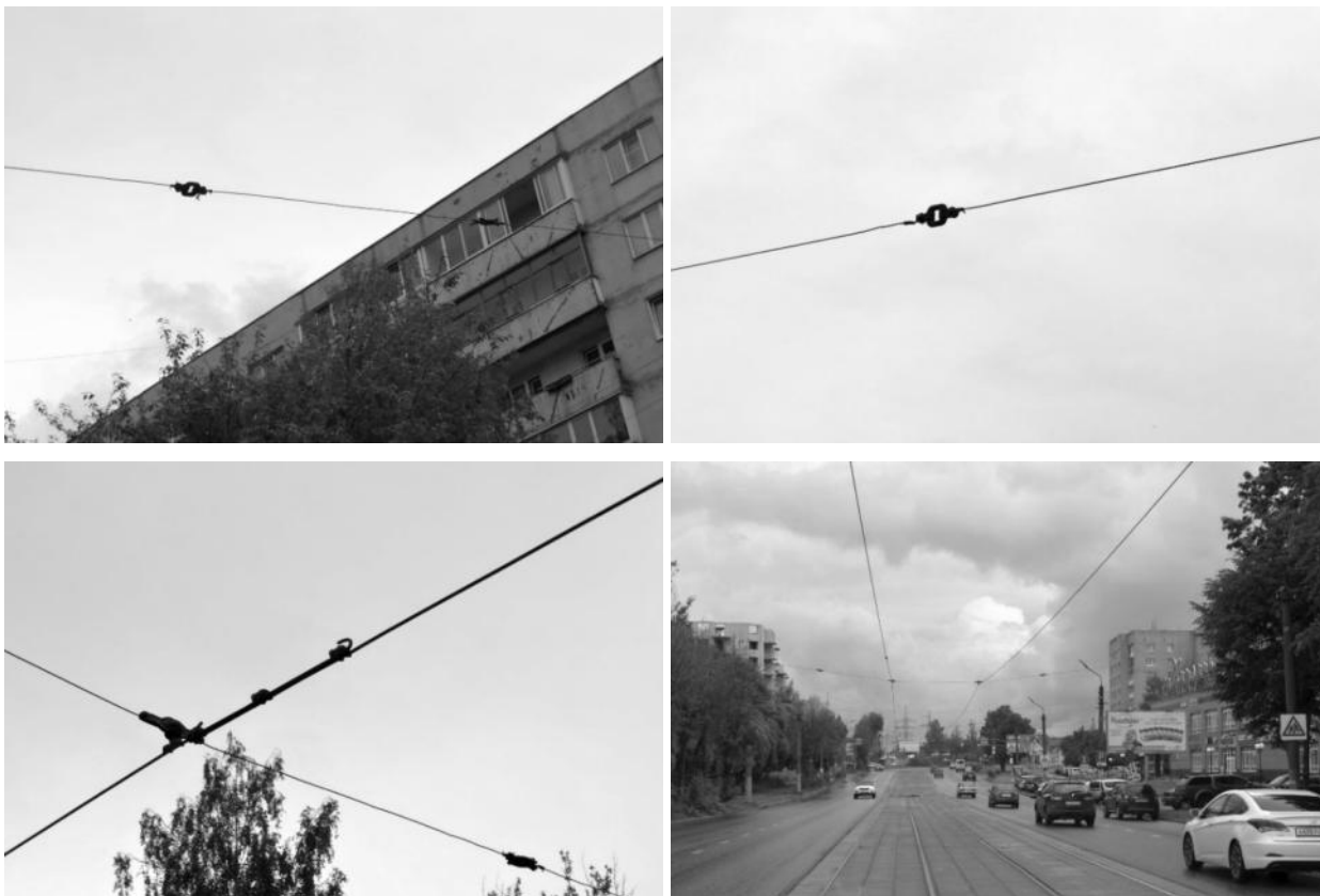
Рисунок 2.430 – Системы подвески из стальных канатов
