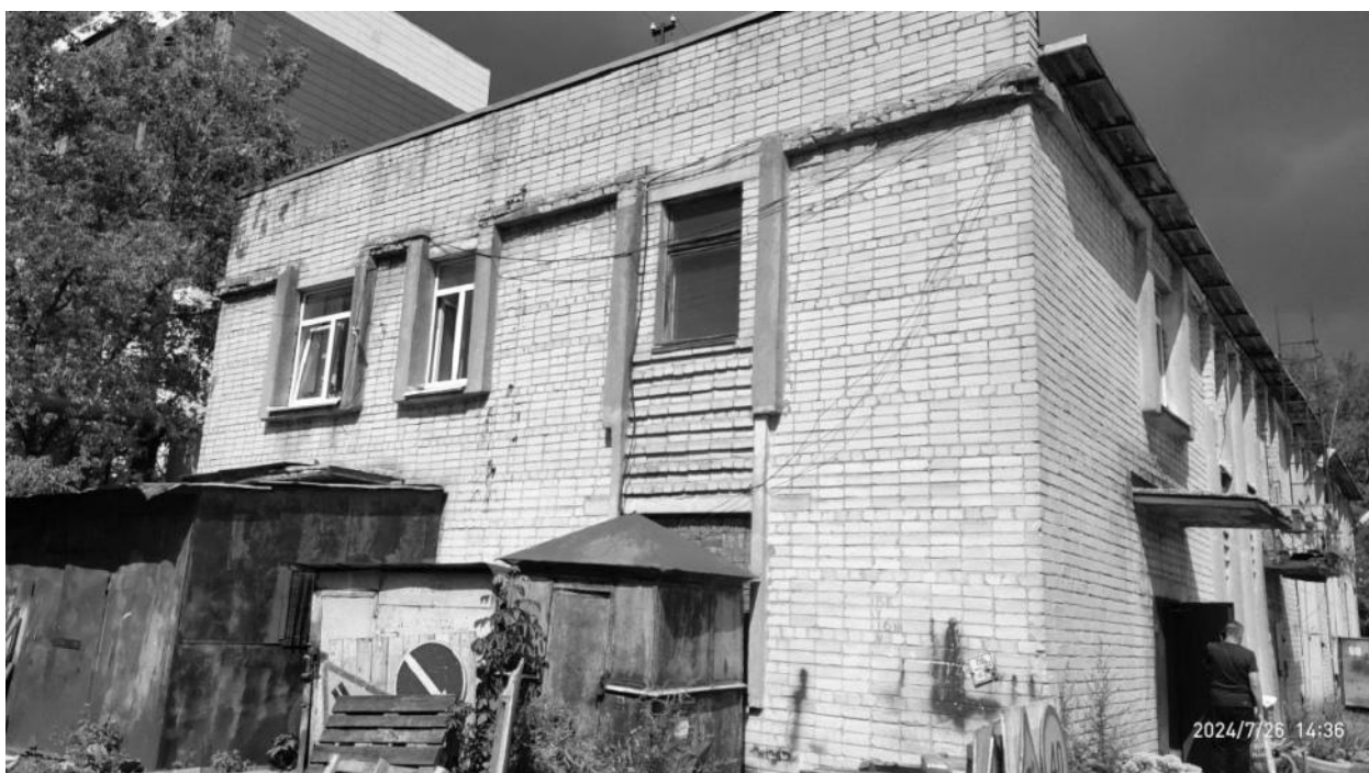
Рисунок 2.64 – Общий вид здания службы пути на дату проведения обследования
