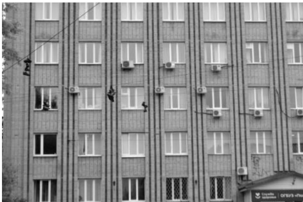
Рисунок 2.402 – Вышедшая из употребления обувь на стальных канатах подвески контактной сети
