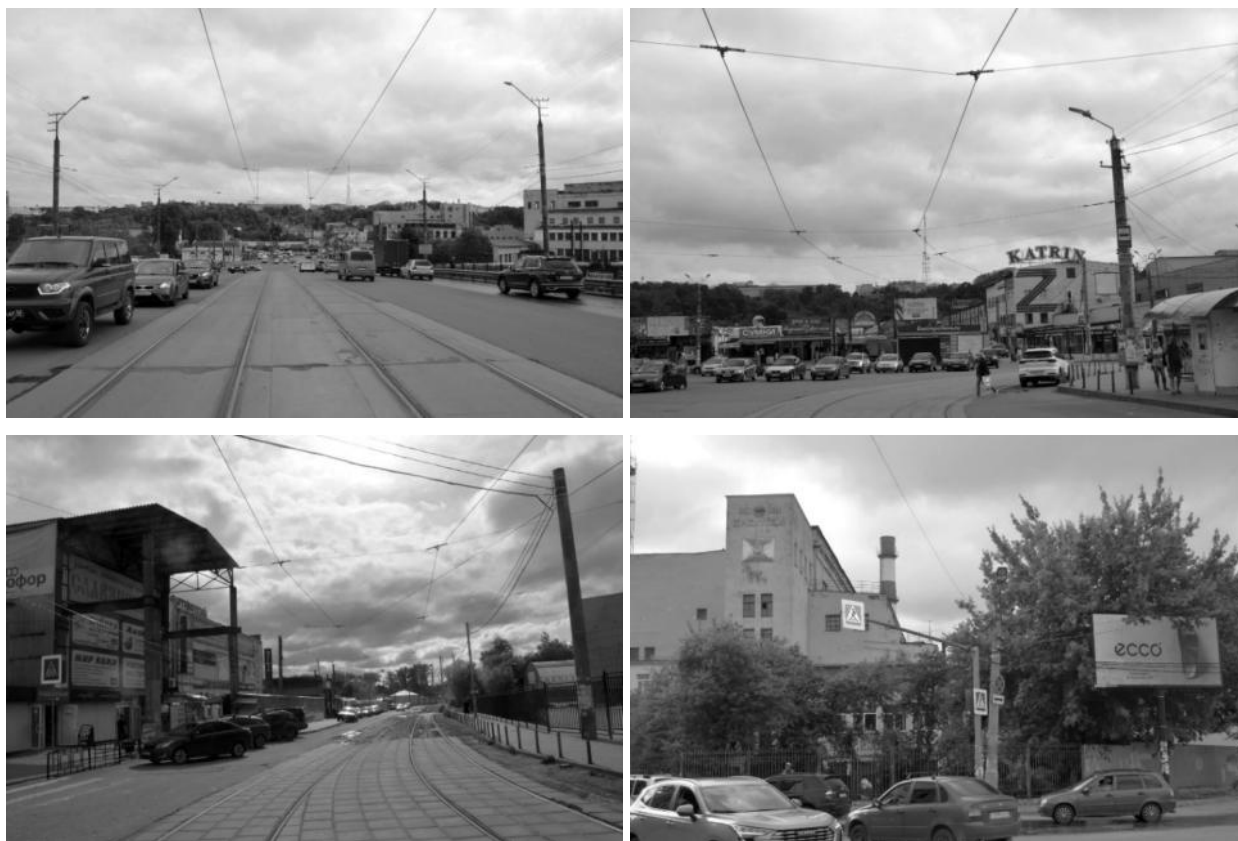
Рисунок 2.294 – Существующие опоры контактной сети
