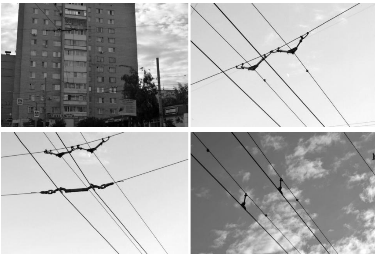
Рисунок 2.582 – Системы подвески из стальных канатов
