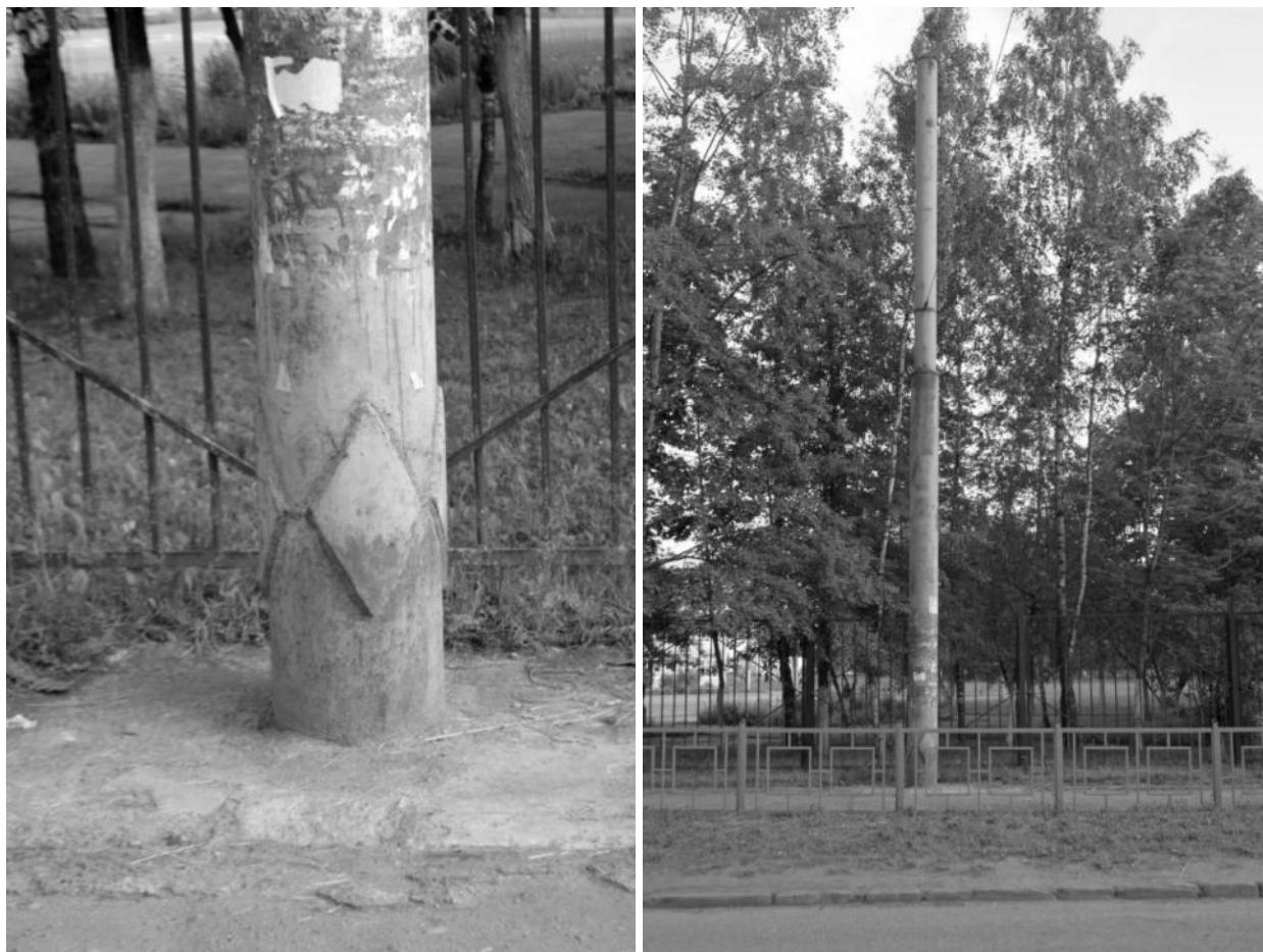
Рисунок 2.578 – Опоры контактной сети
