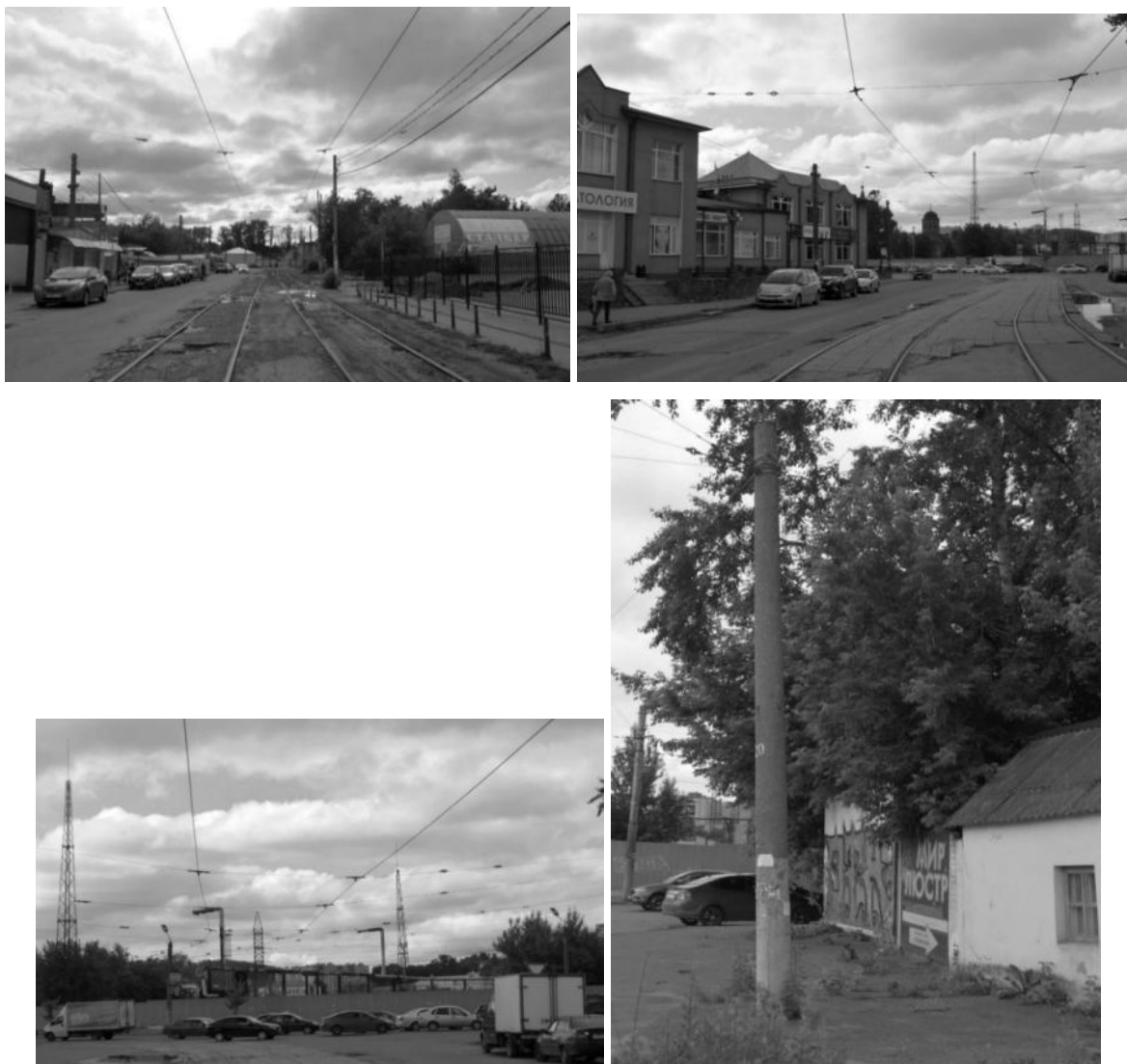
Рисунок 2.298 – Существующие опоры контактной сети
