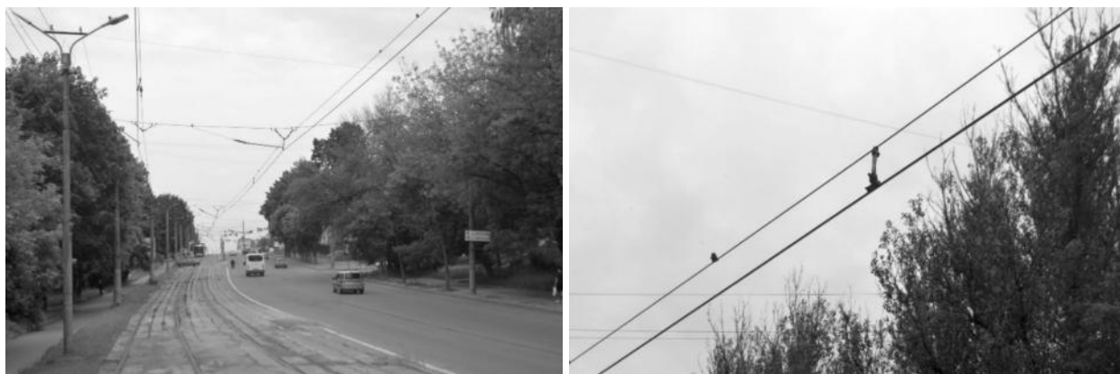
Рисунок 2.375 – Контактный провод трамвая
