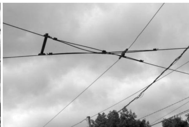
Рисунок 2.303 – Контактный провод трамвая
