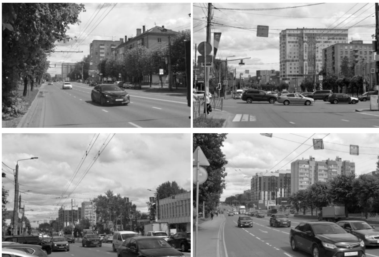
Рисунок 2.520 – Существующие опоры контактной сети
