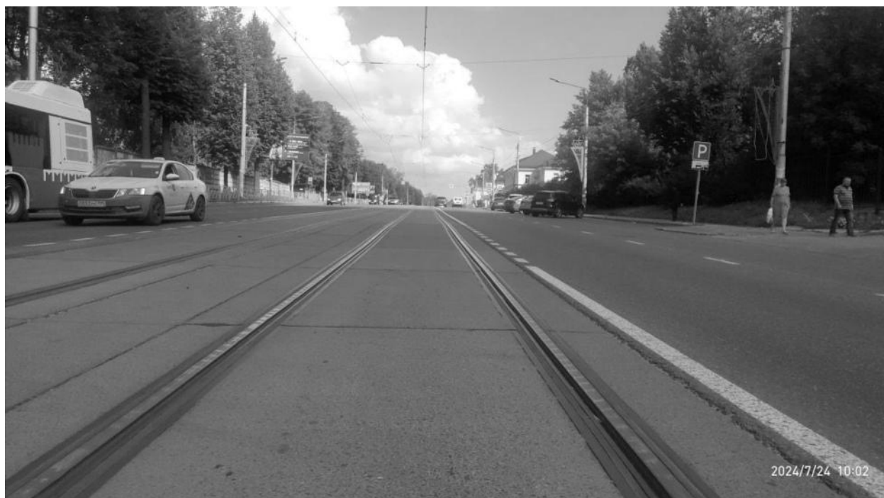
Рисунок 2.845 – Общий вид участка трамвайных путей – ул. Фрунзе
