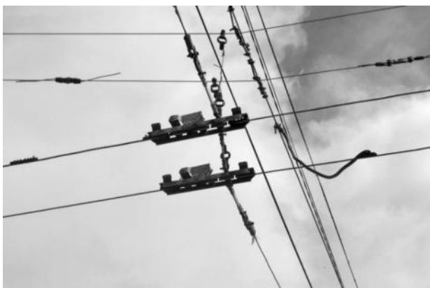
Рисунок 2.537 – Секционные изоляторы на участке контактной сети
