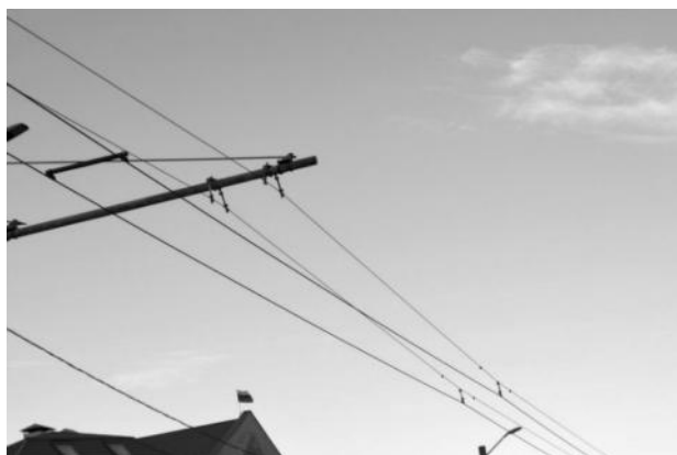
Рисунок 2.591 – Системы подвески из стальных канатов
