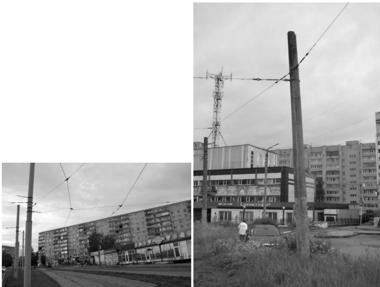
Рисунок 2.470 – Существующие опоры контактной сети
