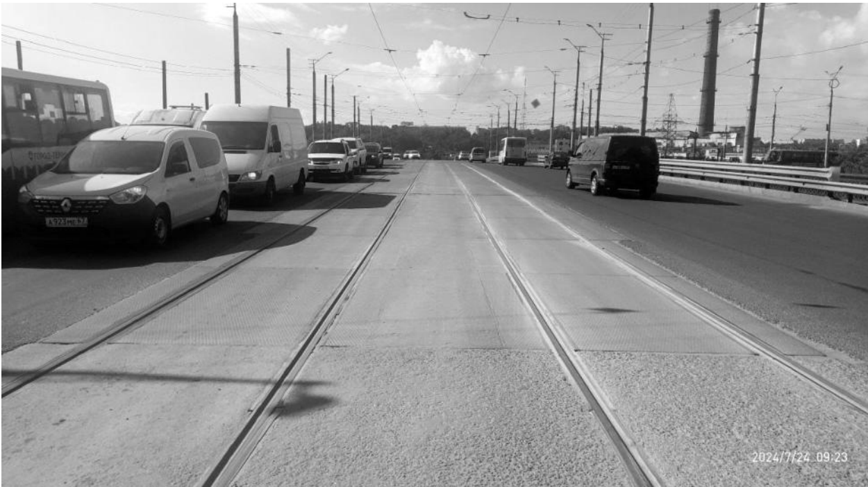
Рисунок 2.839 – Общий вид участка трамвайных путей – ул. 12 лет Октября до ул. Фрунзе
