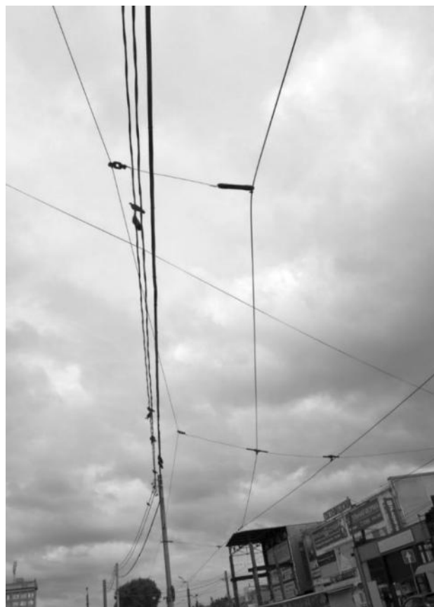
Рисунок 2.301 – Системы подвески из стальных канатов
