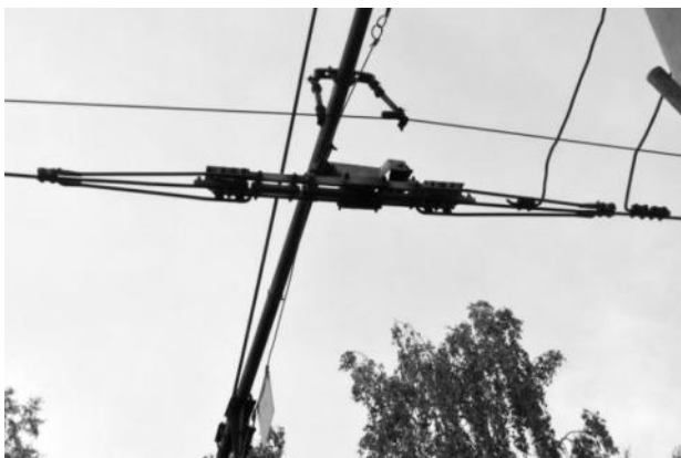
Рисунок 2.327 – Секционные изоляторы
