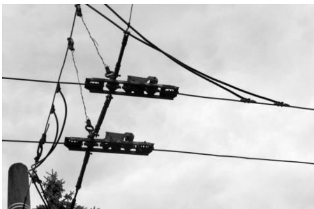
Рисунок 2.606 – Секционные изоляторы
