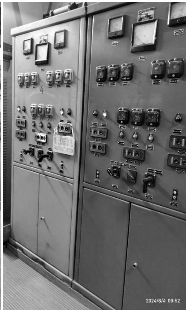
Рисунок 2.224 – Блоки выпрямителя БВКЛ-1000 и шкафы управления ШУЛ-1000 (ТП-2)
