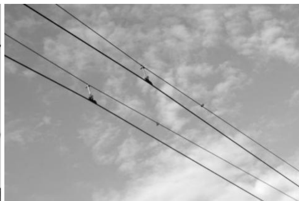
Рисунок 2.575 – Системы подвески из стальных канатов
