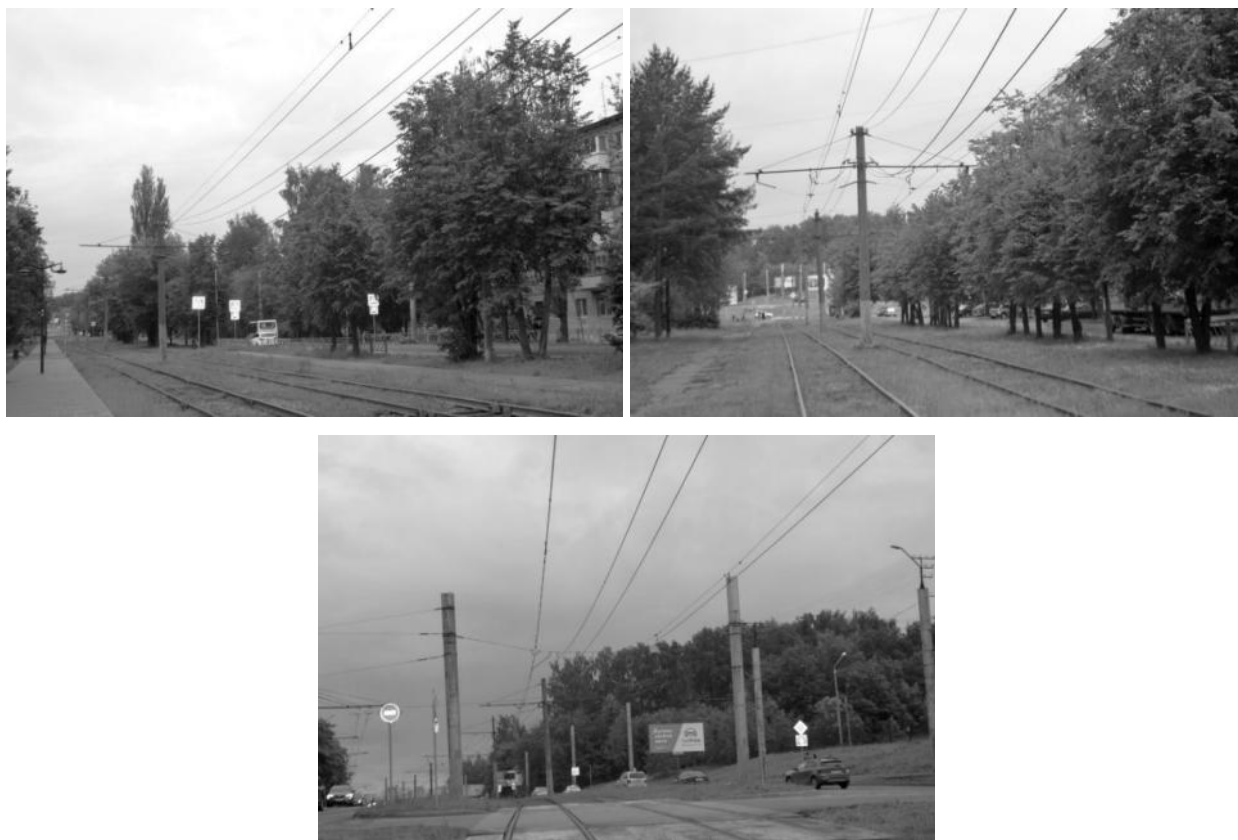
Рисунок 2.460 – Существующие опоры контактной сети
