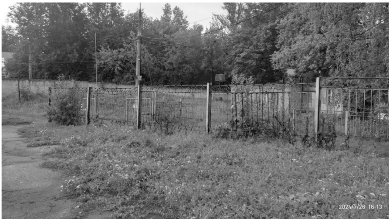
Рисунок 2.76 – Общий вид сварных металлических ограждений
