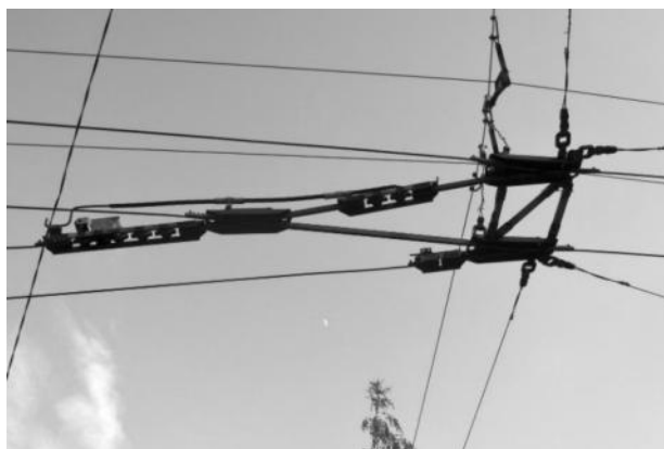
Рисунок 2.585 – Спецчасти на участке контактной сети
