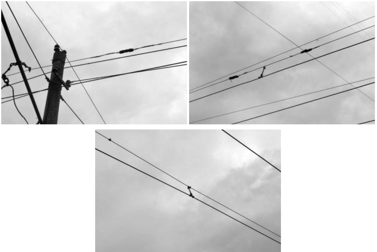
Рисунок 2.466 – Продольный стальной канат
