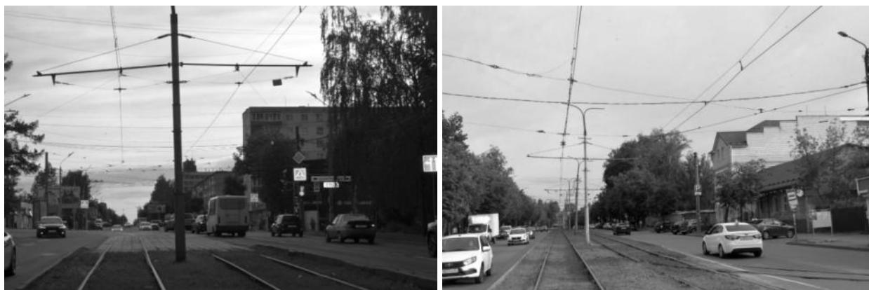
Рисунок 2.331 – Существующие опоры контактной сети
