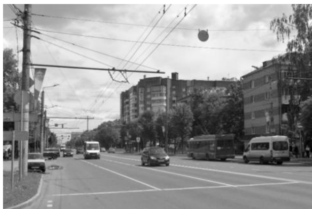
Рисунок 2.514 – Существующие опоры контактной сети
