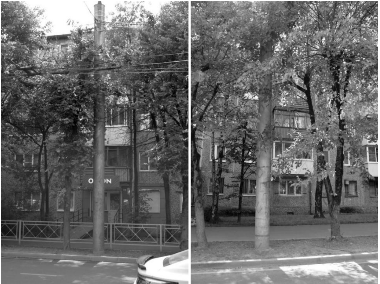
Рисунок 2.533 – Трубы, имеющие как вертикальные сварные швы
