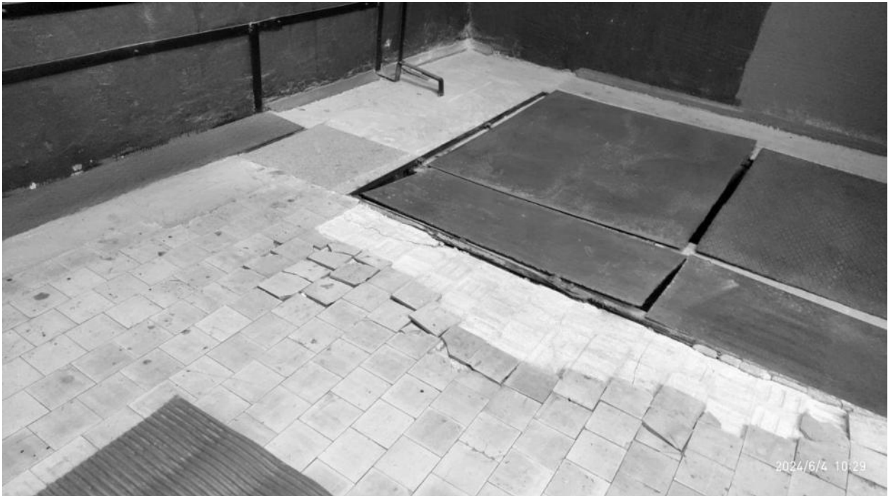
Рисунок 2.192 – Внутренний вид ТП-5
