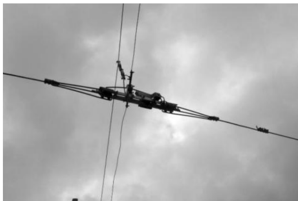
Рисунок 2.292 – Секционные изоляторы
