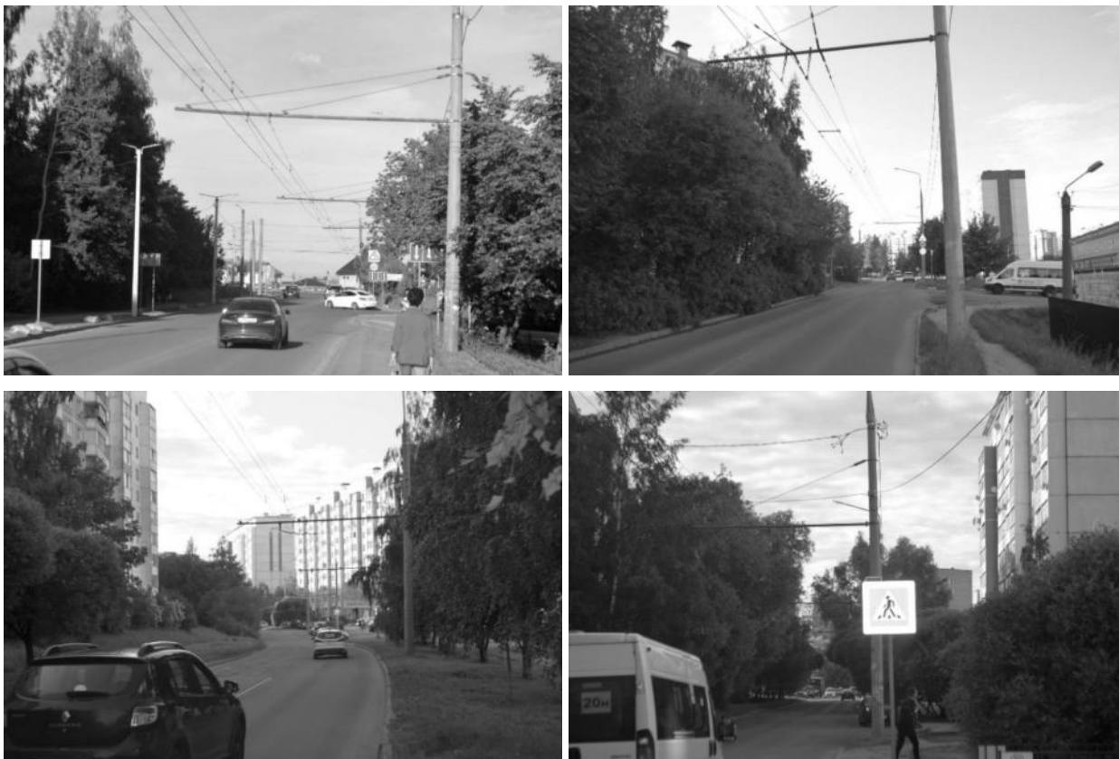
Рисунок 2.571 – Существующие опоры контактной сети
