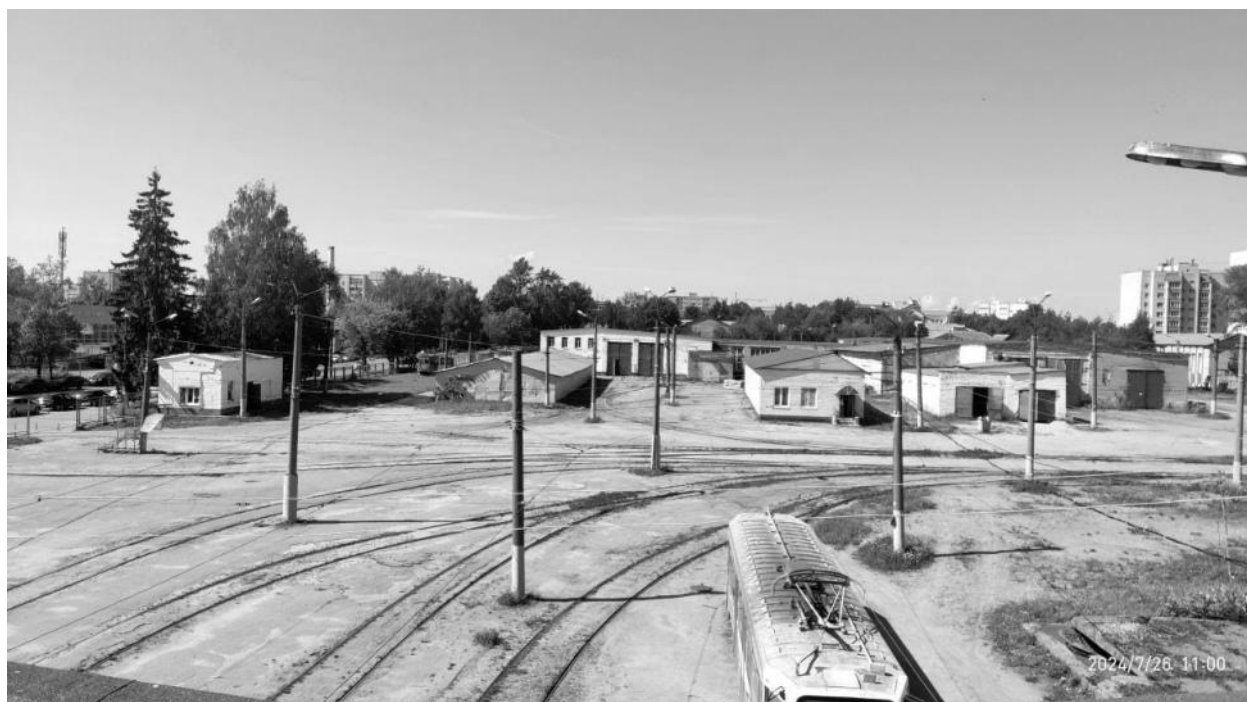
Рисунок 2.853 – Общий вид трамвайного депо
