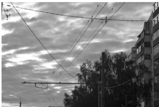
Рисунок 2.583 – Системы подвески из стальных канатов
