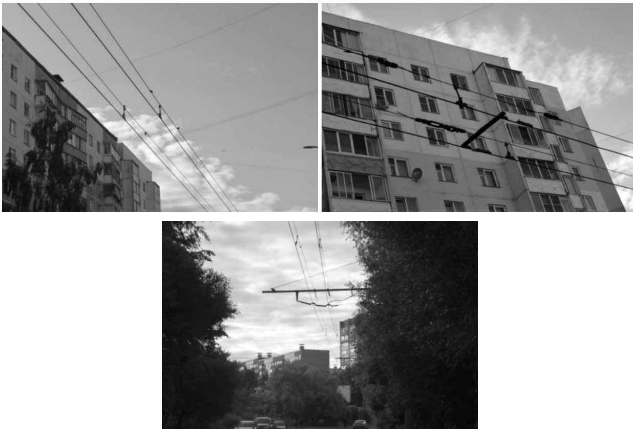
Рисунок 2.573 – Контактный провод троллейбуса
