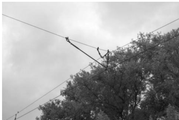
Рисунок 2.310 – Контактный провод трамвая
