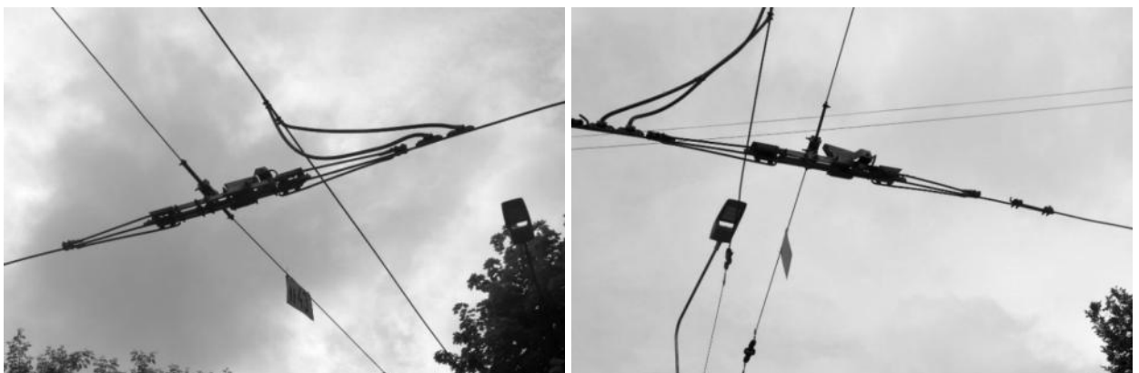
Рисунок 2.281 – Секционные изоляторы
