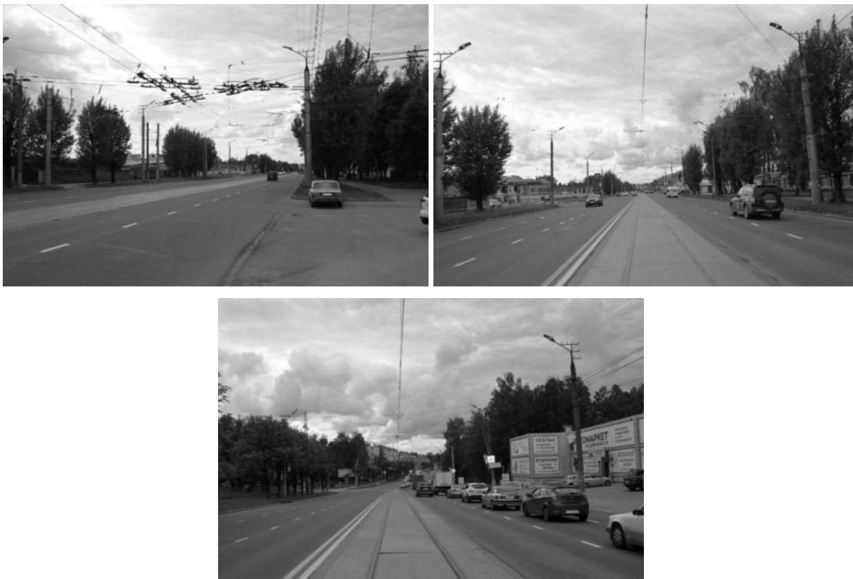
Рисунок 2.612 – Существующие опоры контактной сети
