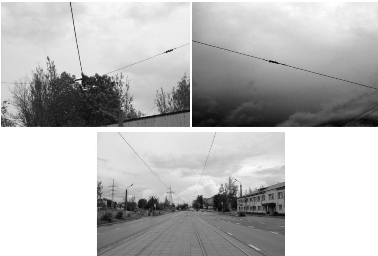
Рисунок 2.437 – Системы подвески из стальных канатов
