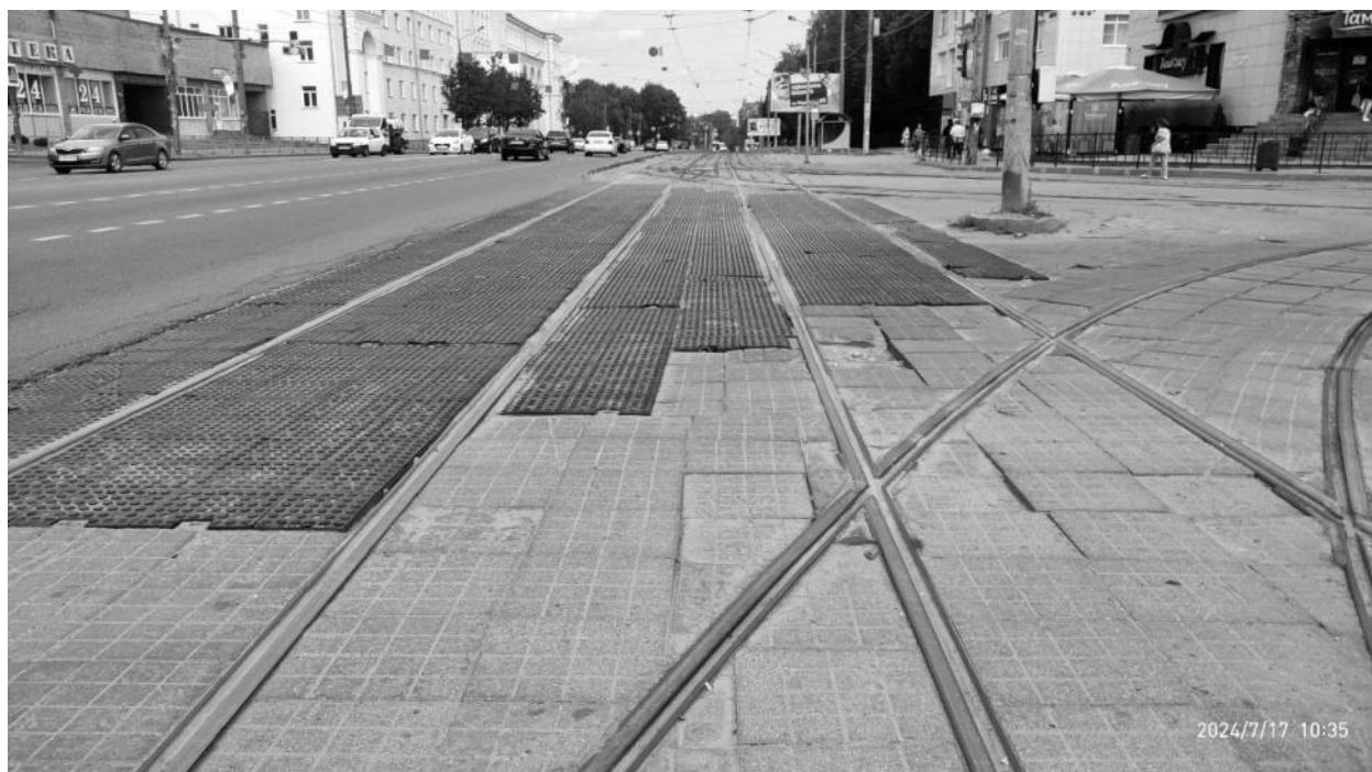
Рисунок 2.797 – Общий вид участка трамвайных путей – узел «Медгородок»
