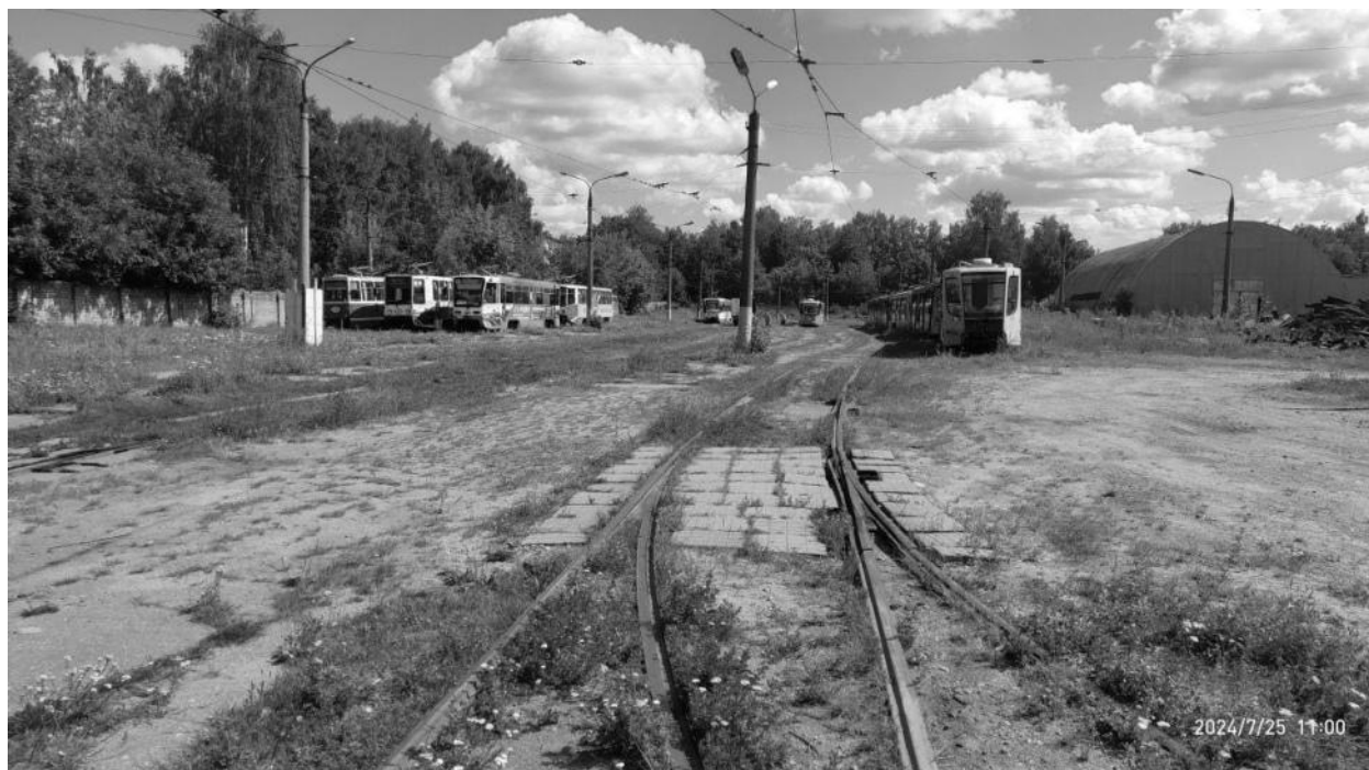
Рисунок 2.80 – Общий вид контактной и рельсовой сети трамвайного депо
