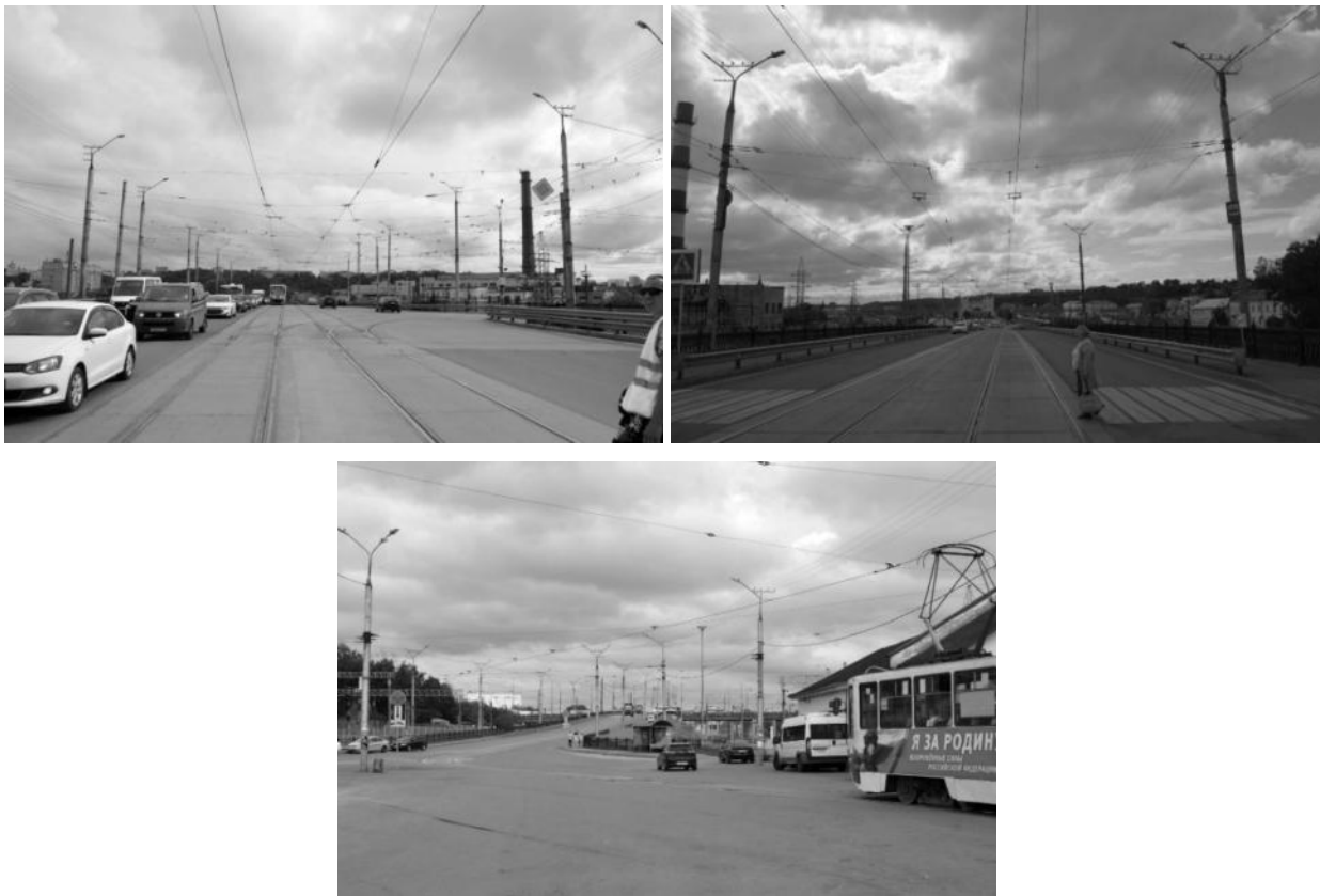
Рисунок 2.289 – Существующие опоры контактной сети
