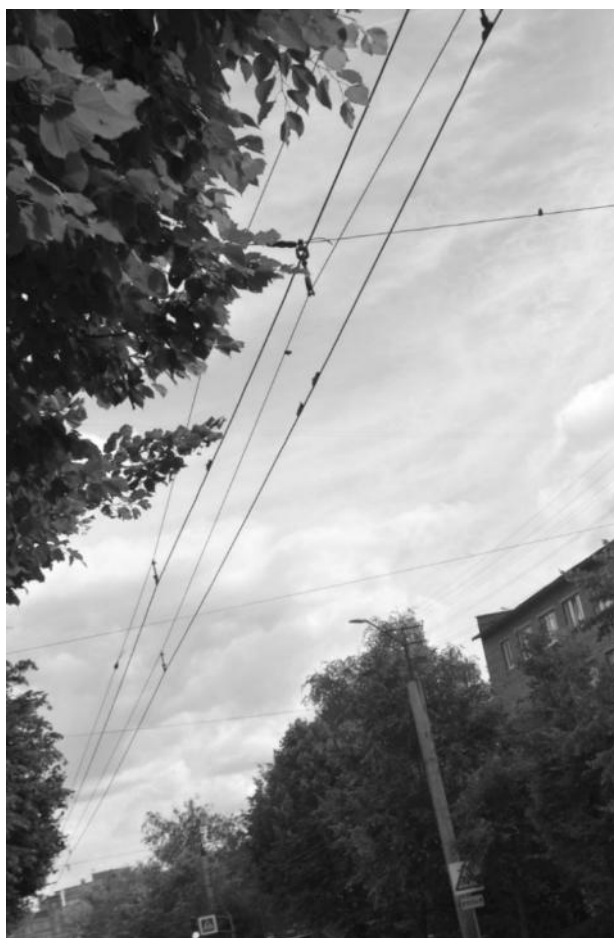
Рисунок 2.547 – Системы подвески из стальных канатов
