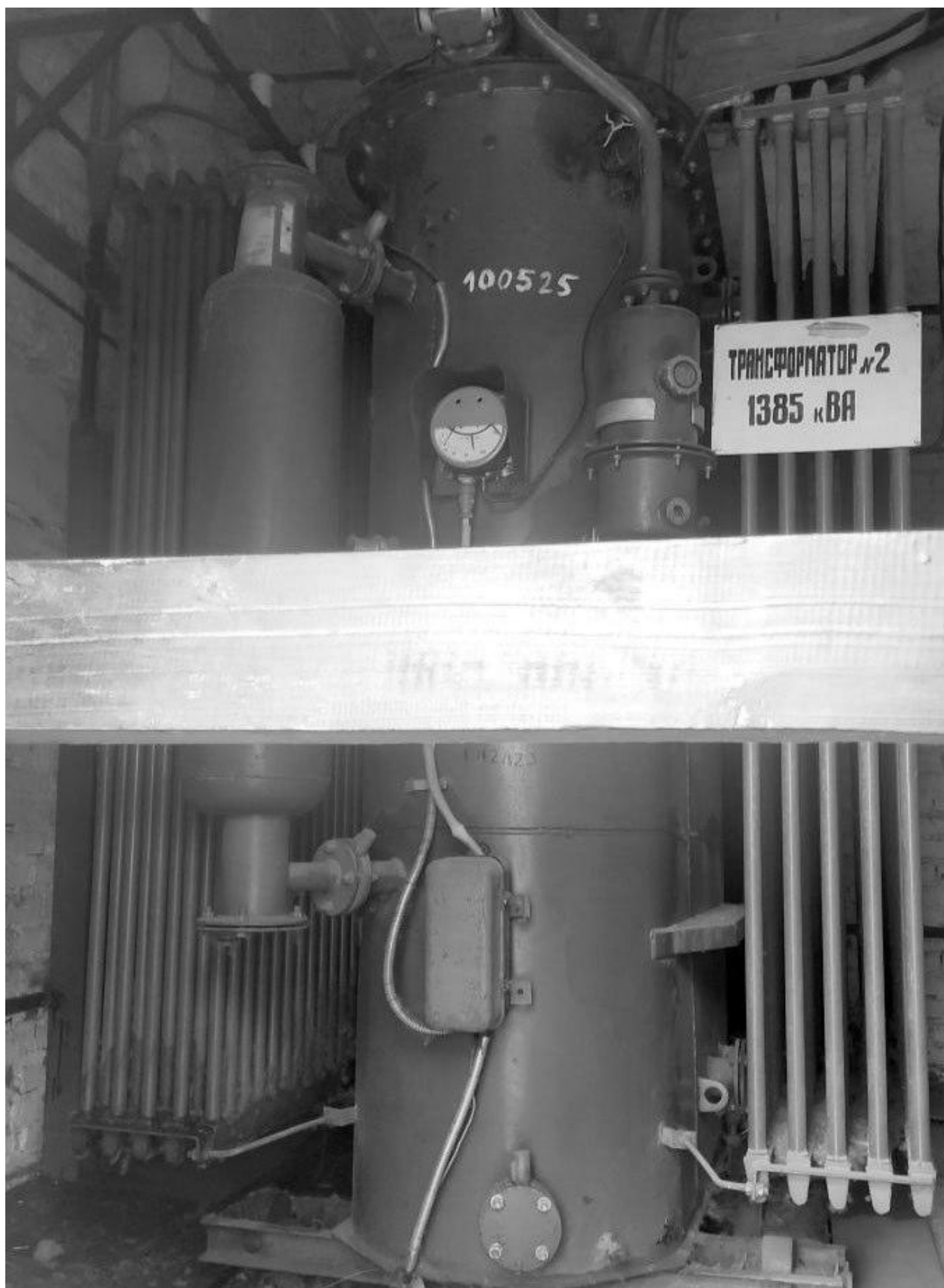
Рисунок 2.222 – Камера трансформатора ТМПУ-2000/10У2 на ТП-5
