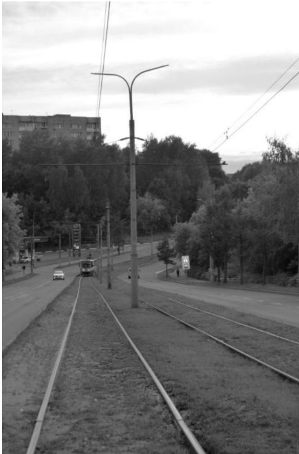
Рисунок 2.324 – Существующие опоры контактной сети
