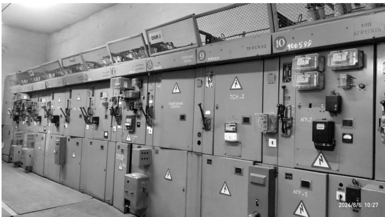
Рисунок 2.229 – Камеры РУ-6 кВ типа КСО-272 на ТП-16
