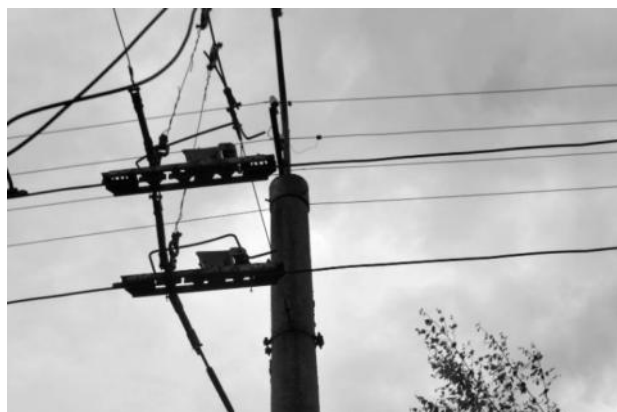
Рисунок 2.606 – Секционные изоляторы
