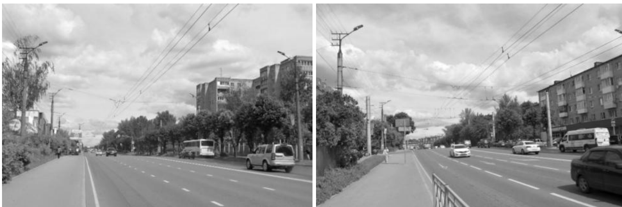
Рисунок 2.527 – Существующие опоры контактной сети
