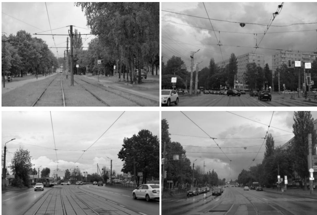
Рисунок 2.421– Существующие опоры контактной сети
