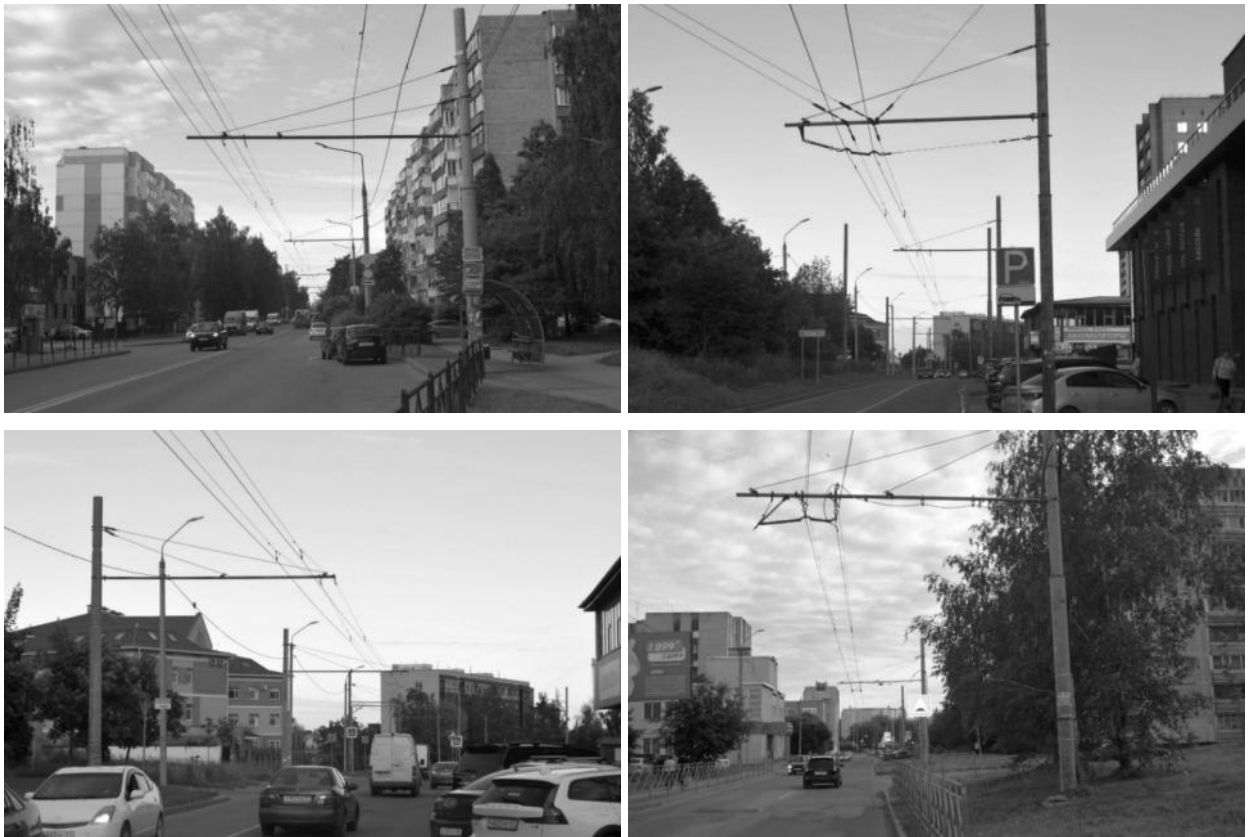
Рисунок 2.586 – Существующие опоры контактной сети
