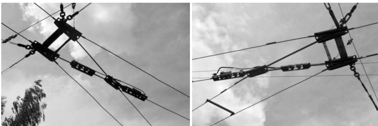
Рисунок 2.95 – Сходные троллейбусные стрелки
