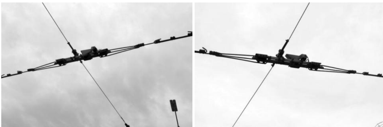
Рисунок 2.361 – Секционные изоляторы
