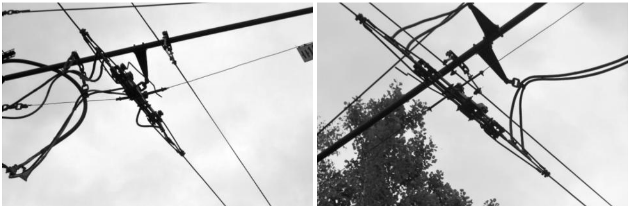
Рисунок 2.262 – Секционные изоляторы
