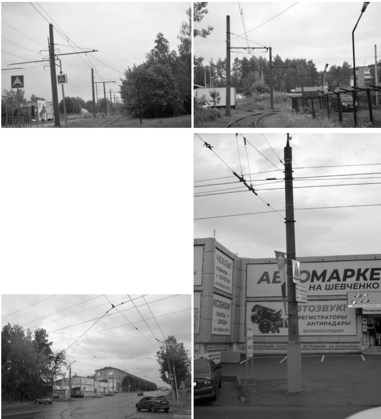
Рисунок 2.456 – Существующие опоры контактной сети
