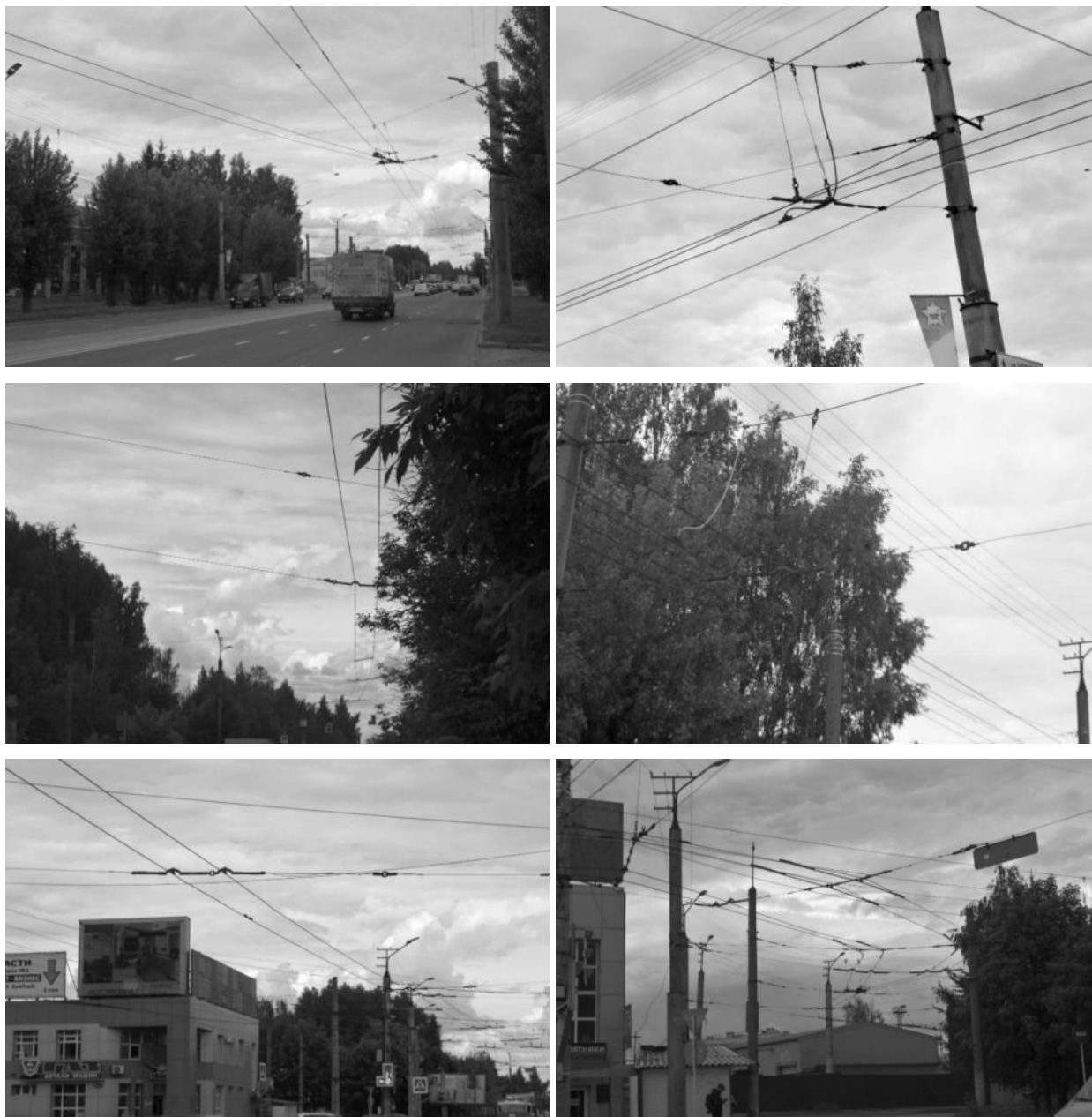
Рисунок 2.626 – Системы подвески из стальных канатов
