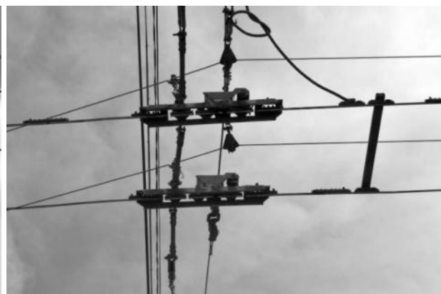
Рисунок 2.537 – Секционные изоляторы на участке контактной сети
