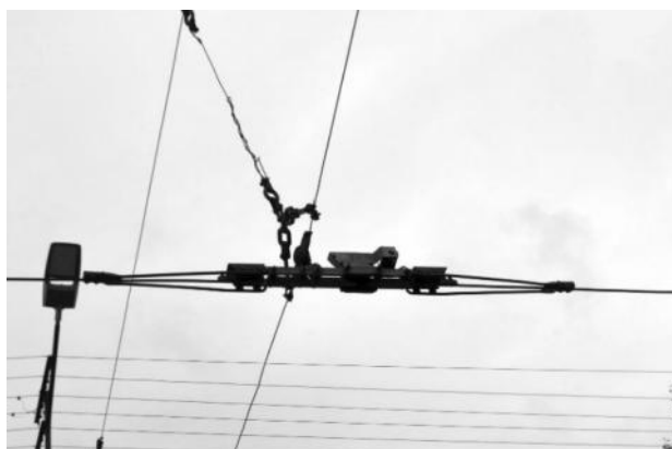
Рисунок 2.419 – Секционные изоляторы
