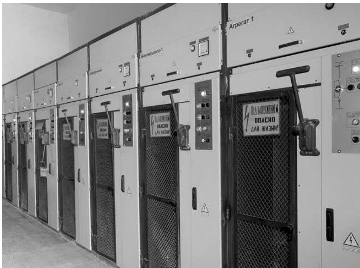
Рисунок 2.243 – Пример реализации ретрофита ячеек «+» 600В
