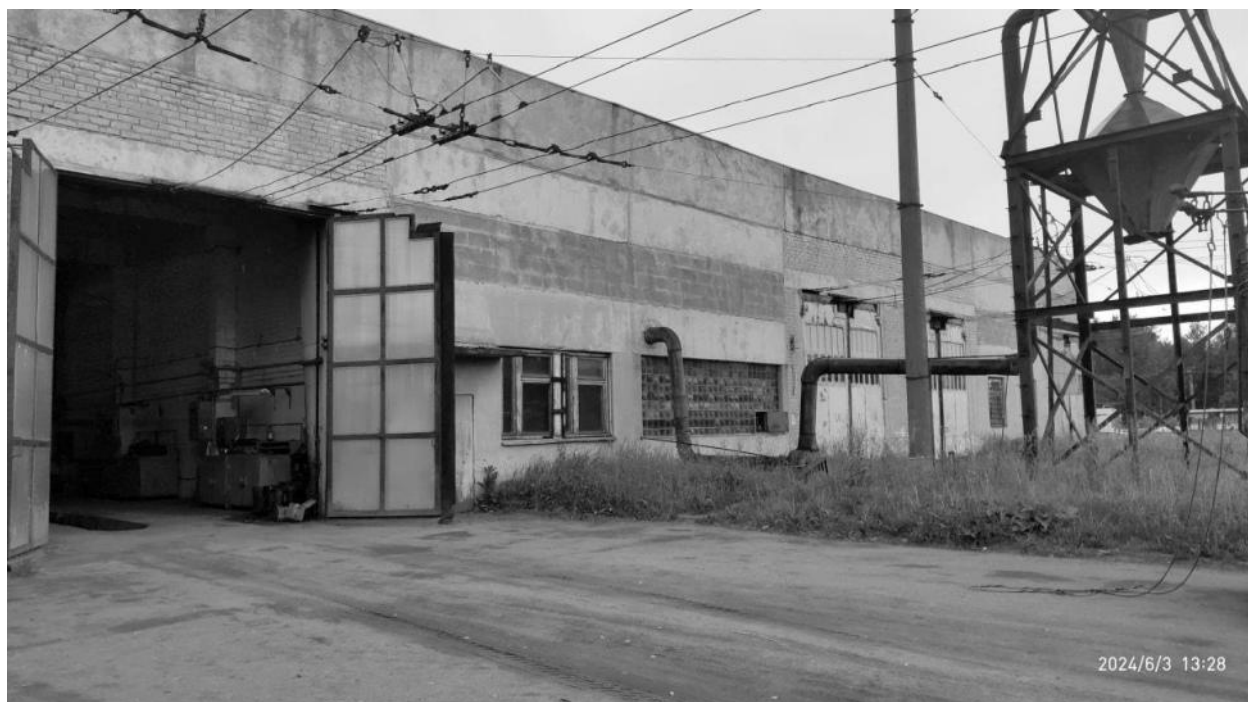
Рисунок 2.22 – Общий вид производственного корпуса на дату проведения обследования
