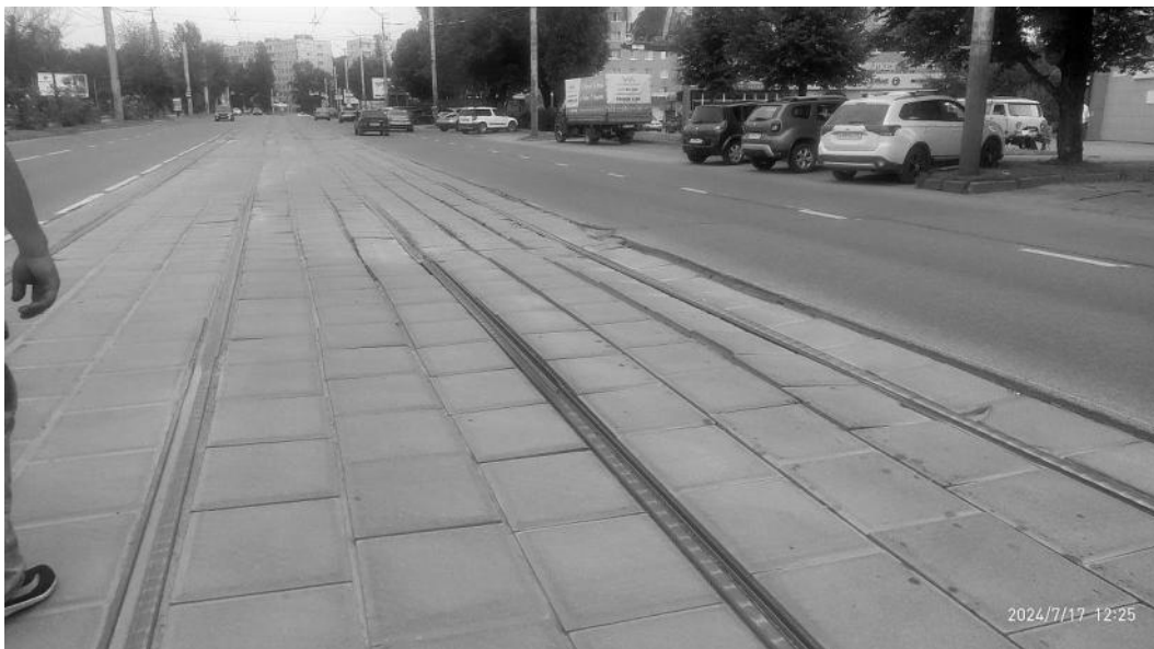
Рисунок 2.807 – Общий вид участка трамвайных путей – ул. 25 Сентября до ул. Смольянинова
