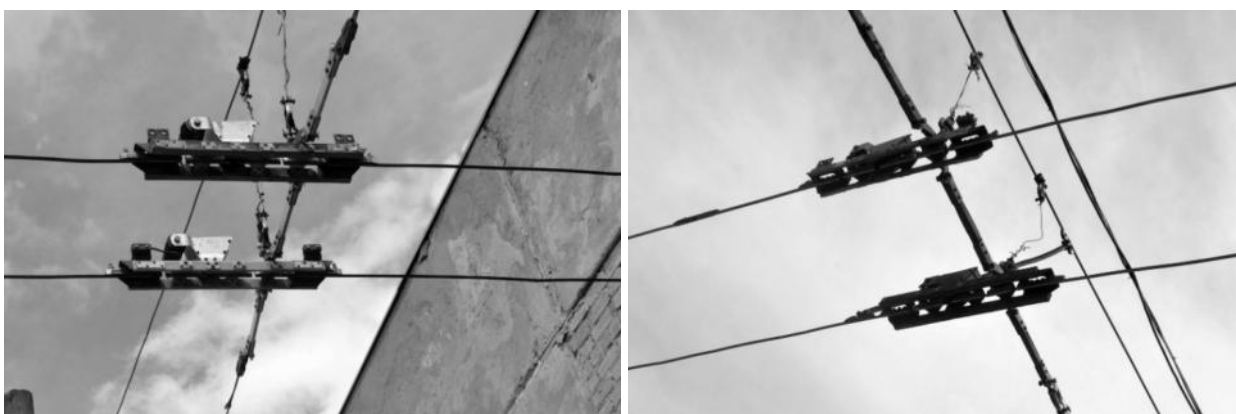
Рисунок 2.91 – Секционные изоляторы
