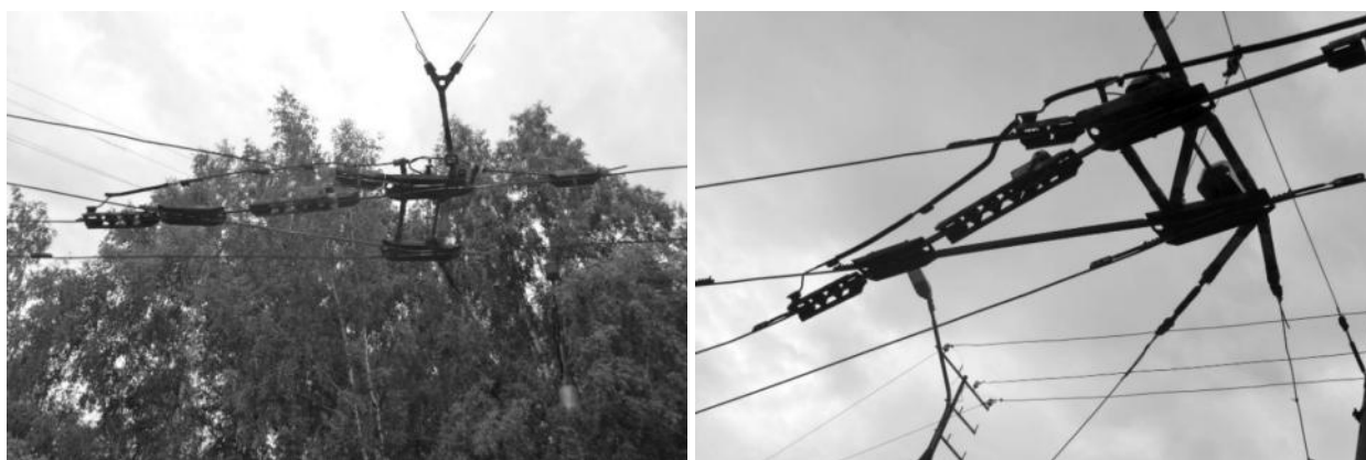
Рисунок 2.628 – Спецчасти на участке контактной сети
