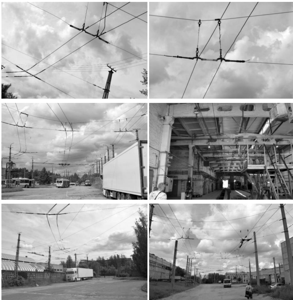
Рисунок 2.89 – Контактный провод
