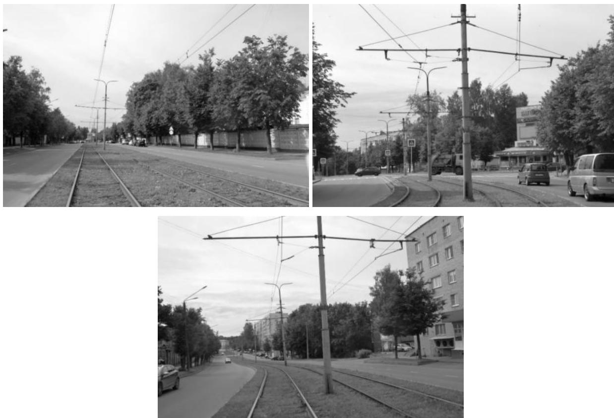
Рисунок 2.339 – Существующие опоры контактной сети
