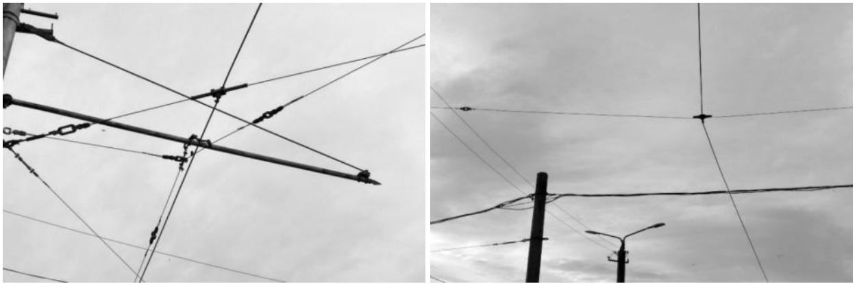
Рисунок 2.338 – Системы подвески из стальных канатов
