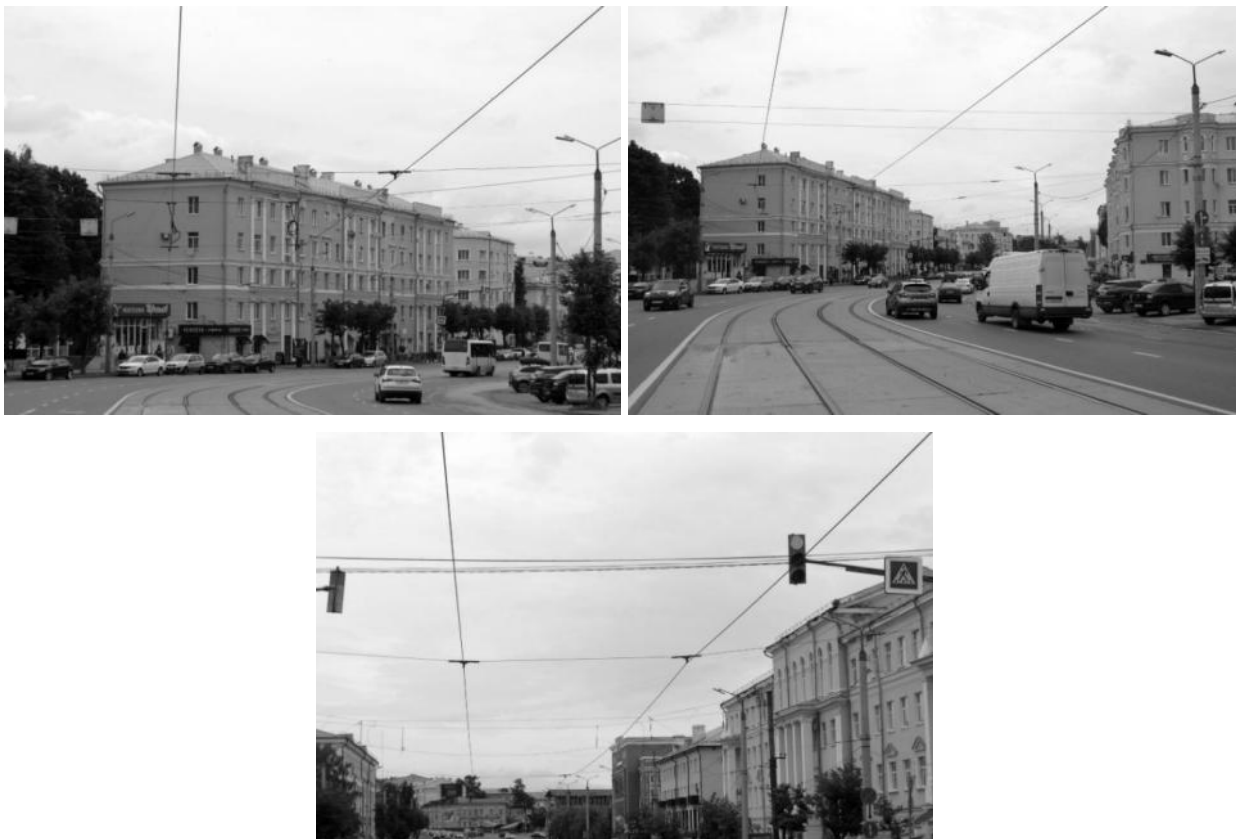
Рисунок 2.363 – Системы подвески из стальных канатов
