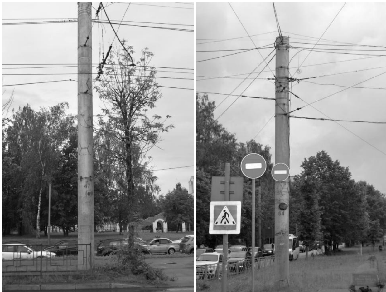
Рисунок 2.422 – Трубы, имеющие как вертикальные сварные швы
