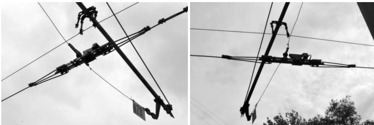
Рисунок 2.343 – Секционные изоляторы
