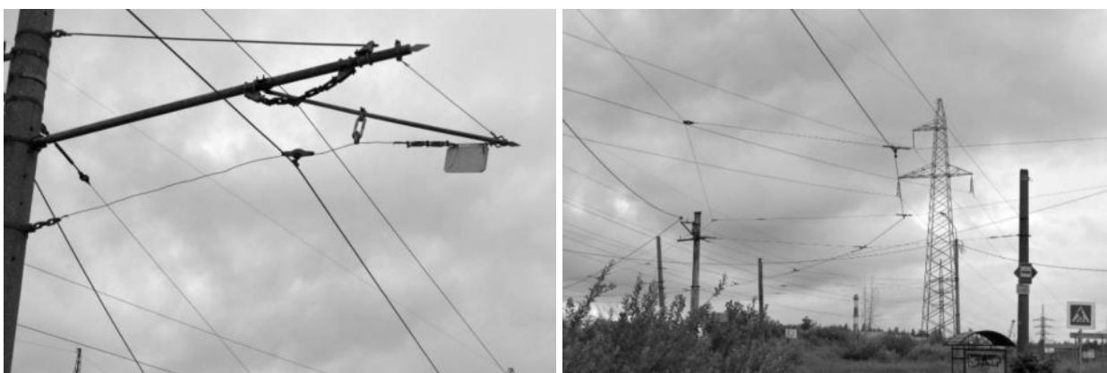
Рисунок 2.452 – Системы подвески из стальных канатов
