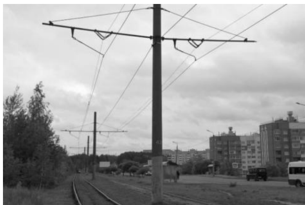
Рисунок 2.259 – Существующие опоры контактной сети
