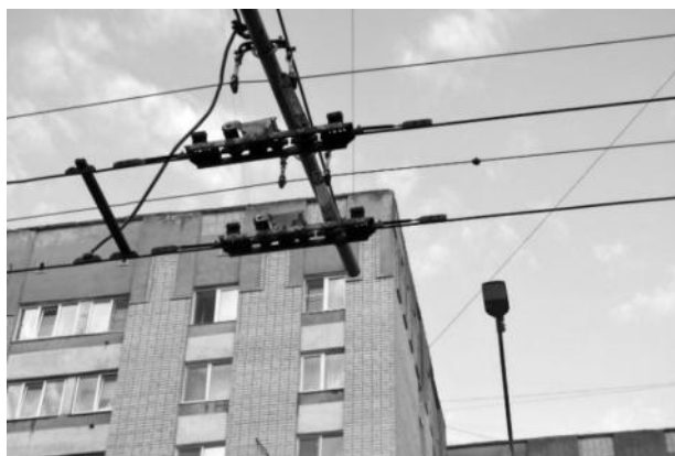
Рисунок 2.593 – Секционные изоляторы
