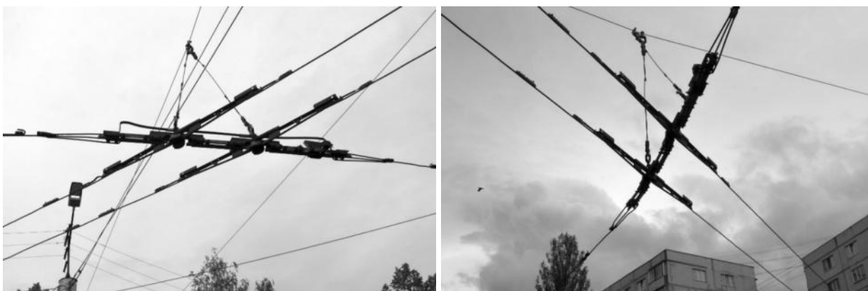
Рисунок 2.431 – Пересечения контактных проводов трамвая и троллейбуса
