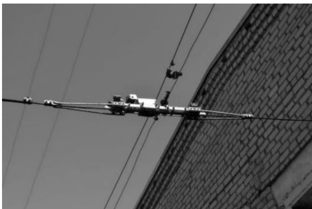
Рисунок 2.484 – Секционные изоляторы на участке контактной сети
