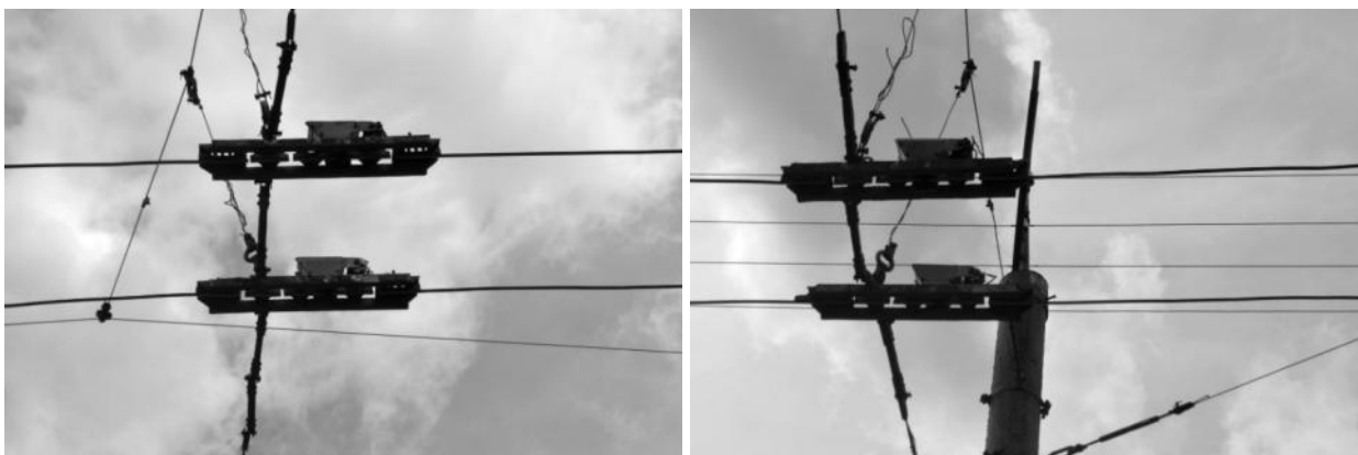
Рисунок 2.90 – Секционные изоляторы
