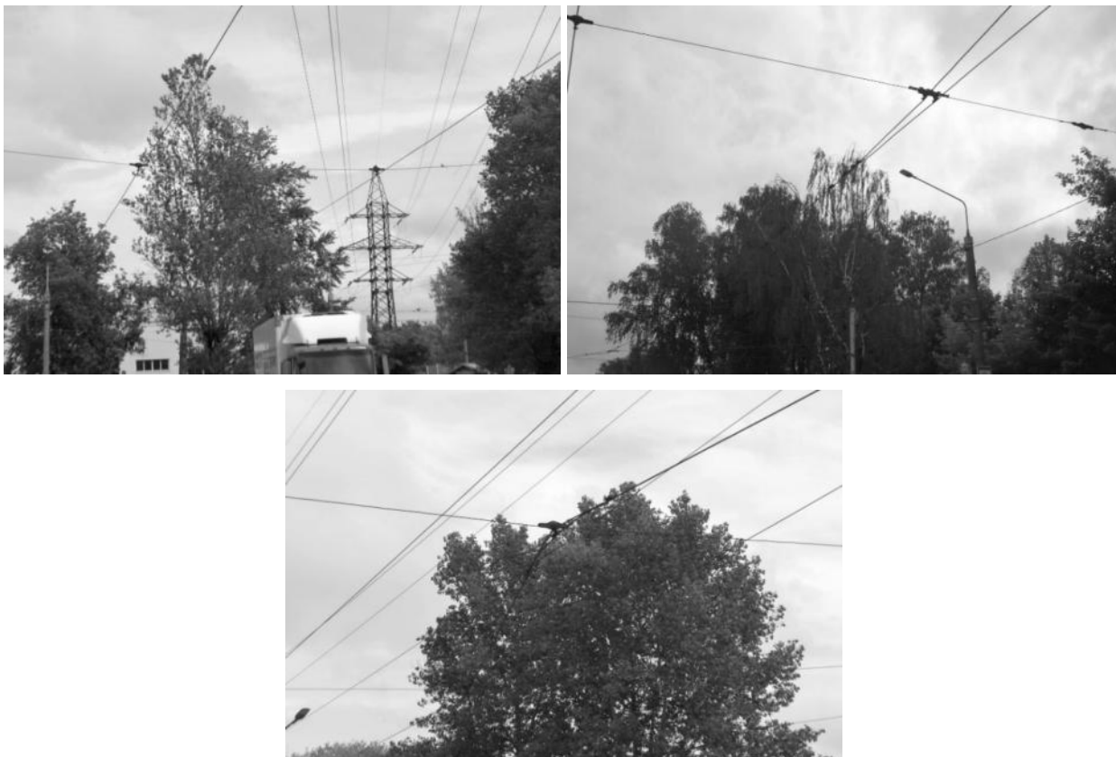
Рисунок 2.277 – Подвески из стальных канатов
