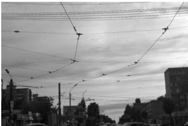
Рисунок 2.334 – Контактный провод трамвая
