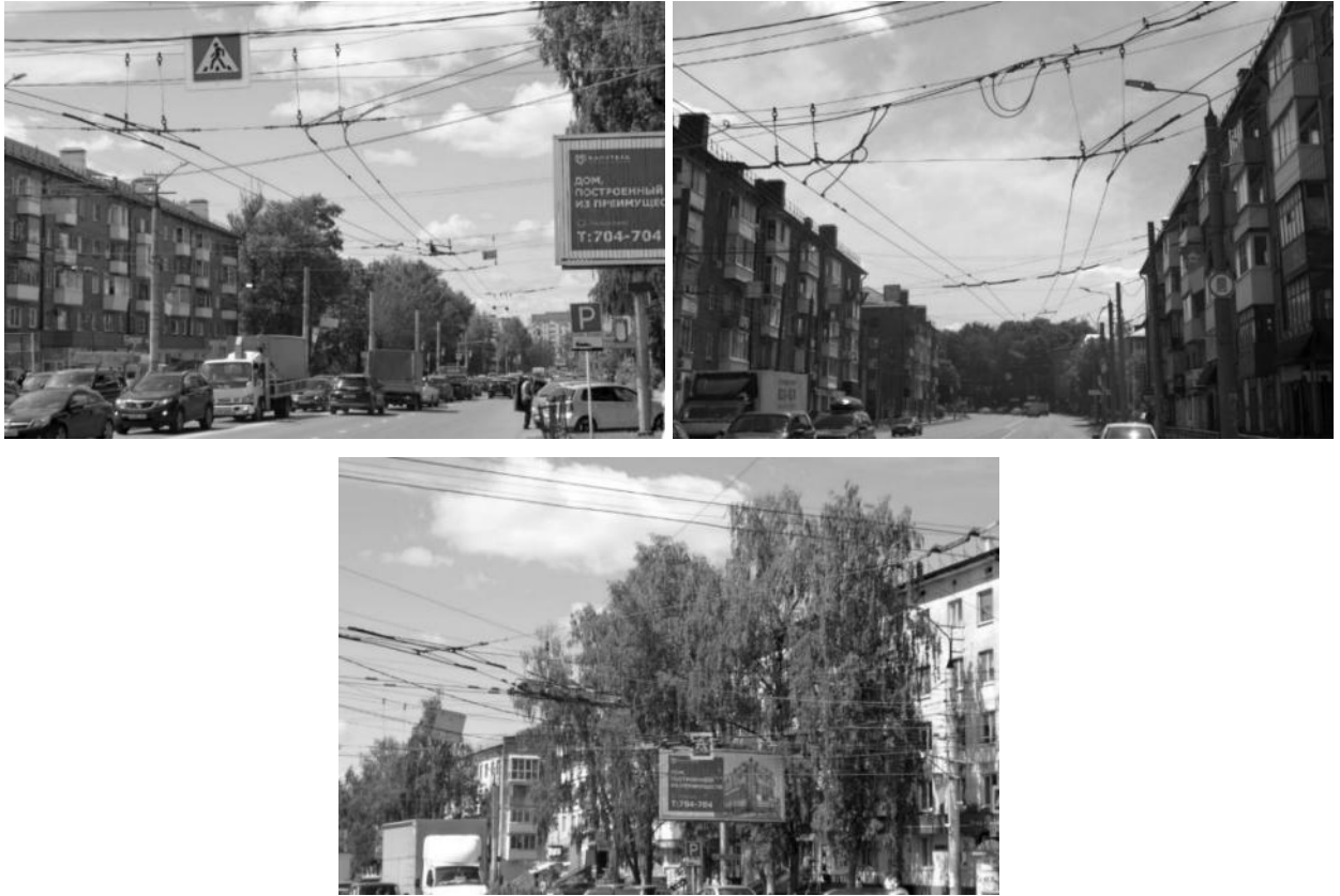
Рисунок 2.497 – Существующие опоры контактной сети
