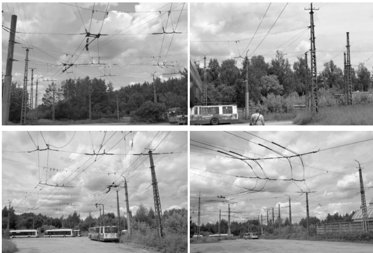
Рисунок 2.630 – Существующие опоры контактной сети
