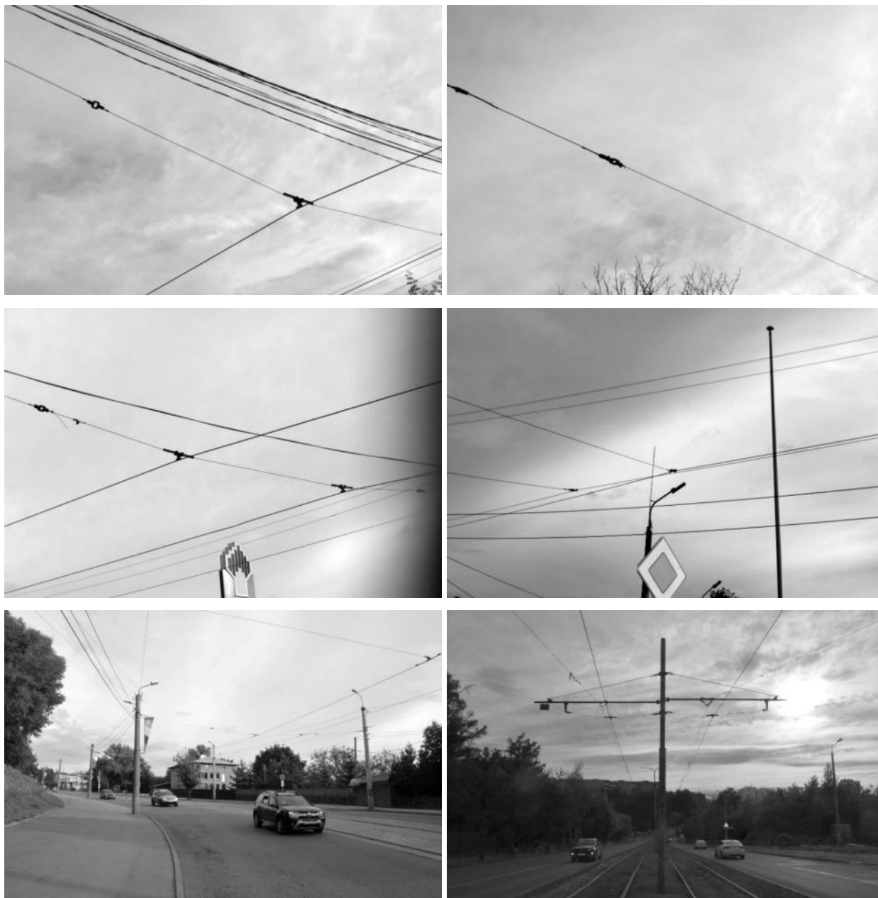
Рисунок 2.322 – Системы подвески из стальных канатов
