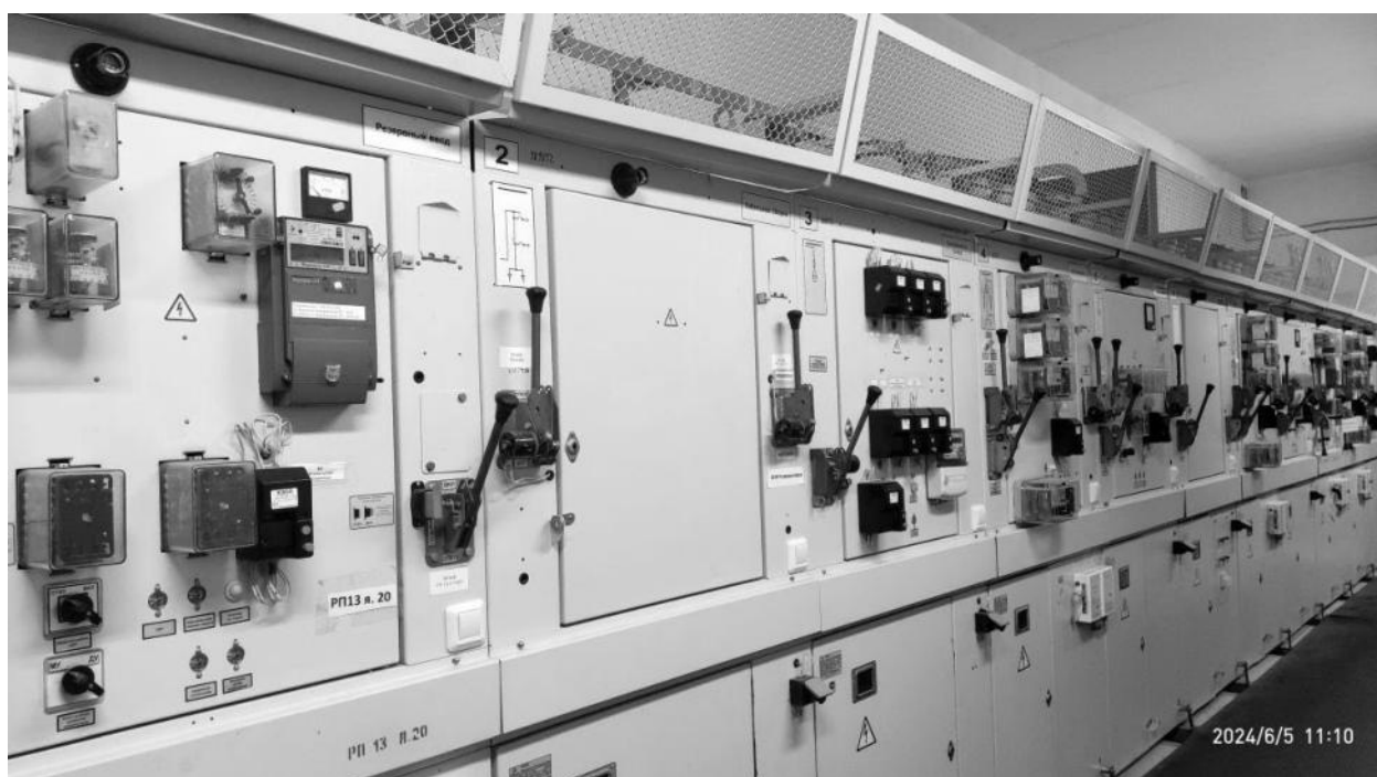
Рисунок 2.231 – Камеры РУ-6 кВ типа КСО-292 на ТП-18
