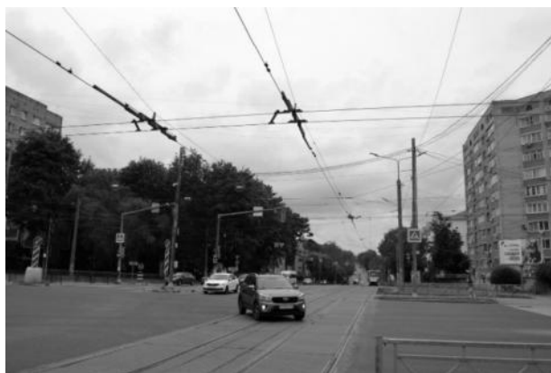
Рисунок 2.381 – Пересечения контактных проводов трамвая и троллейбуса
