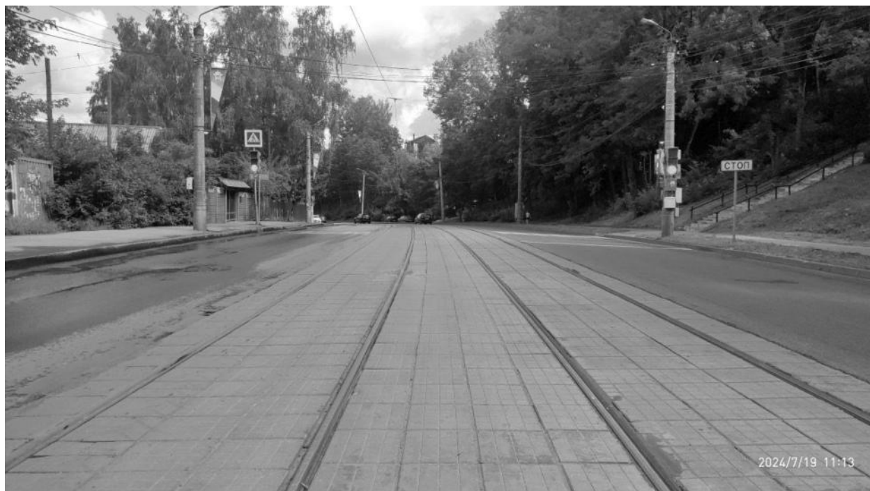
Рисунок 2.831– Общий вид участка трамвайных путей – ул. Дзержинского
