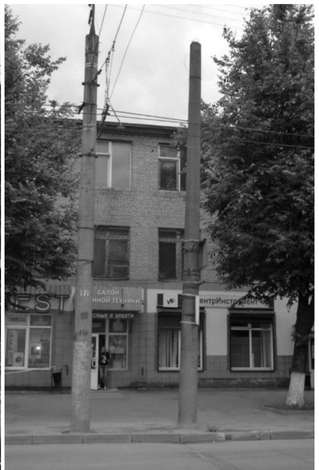
Рисунок 2.613 – Железобетонные опоры
