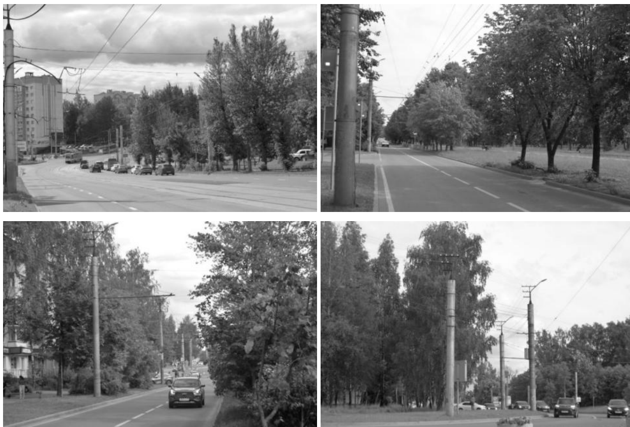
Рисунок 2.551 – Существующие опоры контактной сети
