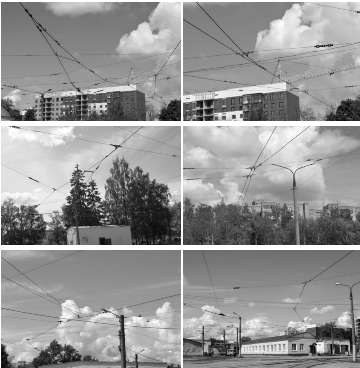
Рисунок 2.482 – Подвески из стальных канатов
