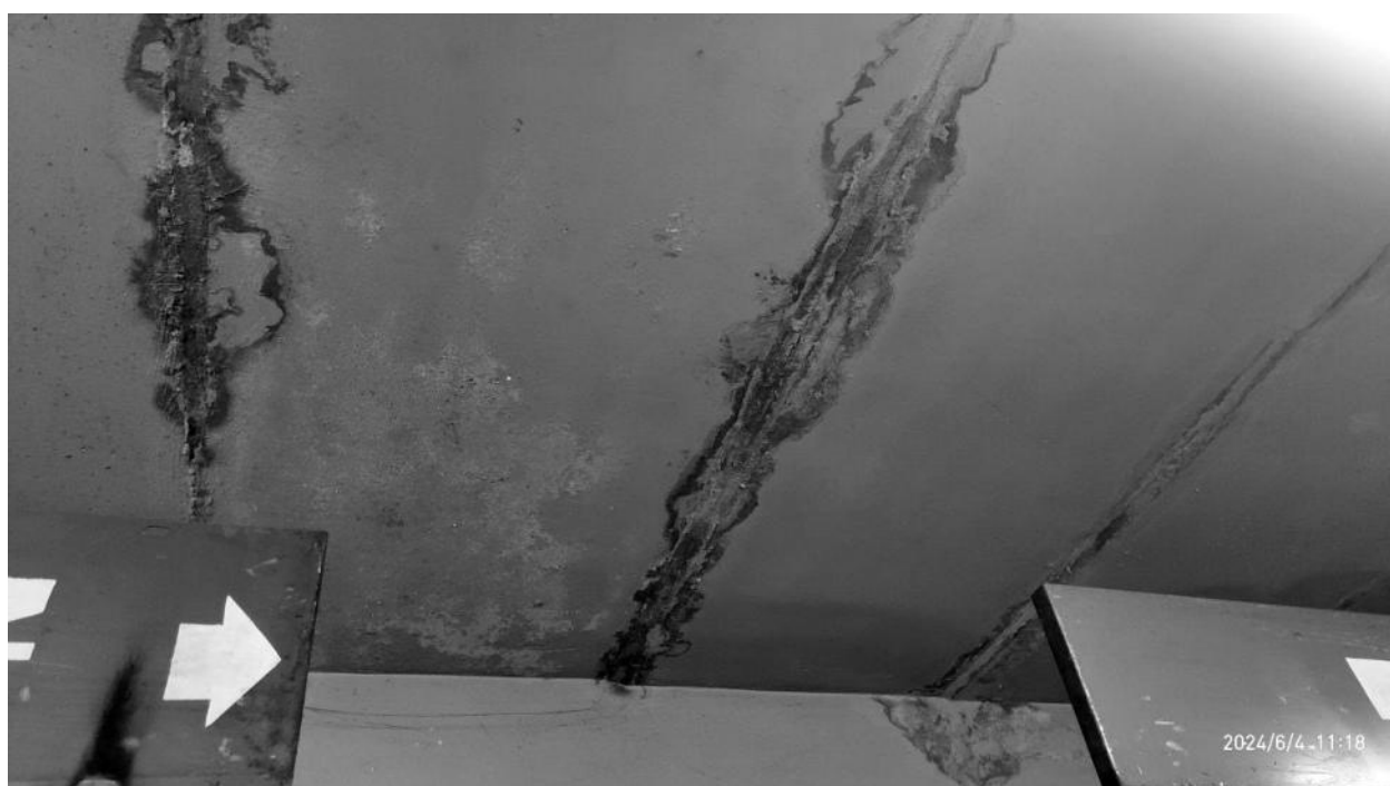
Рисунок 2.176 – Внутренний вид ТП-1
