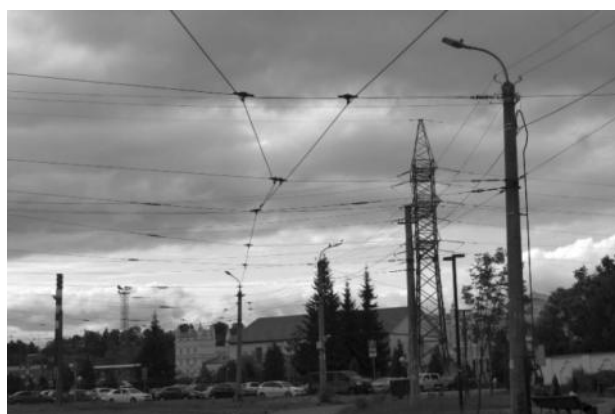
Рисунок 2.306 – Системы подвески из стальных канатов
