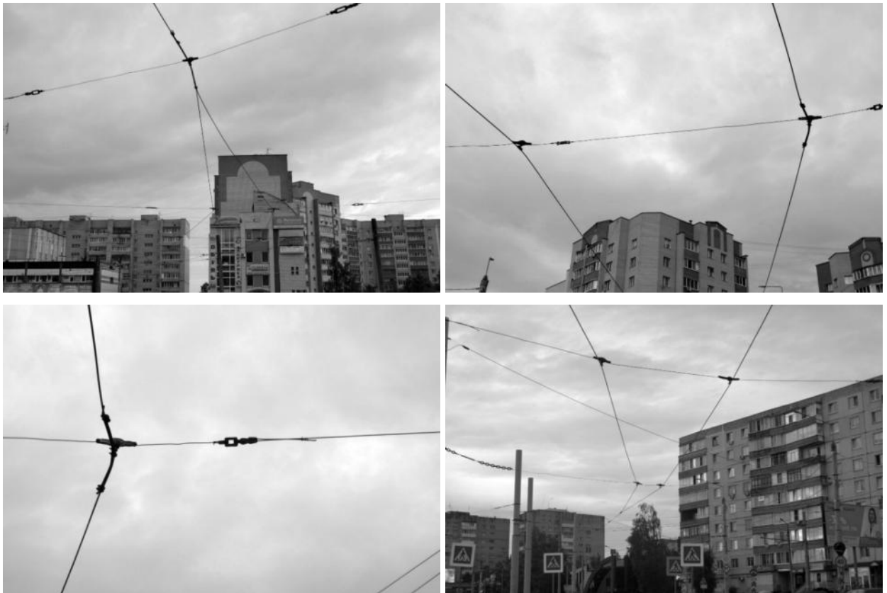
Рисунок 2.474 – Системы подвески из стальных канатов
