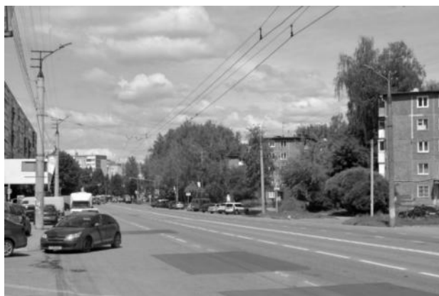
Рисунок 2.509 – Контактный провод троллейбуса
