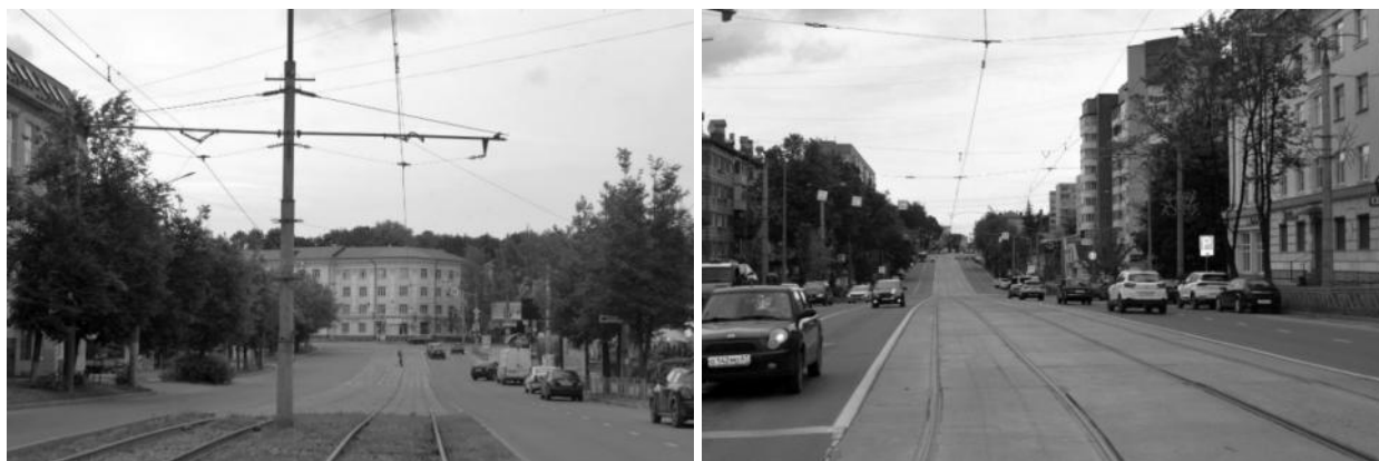
Рисунок 2.346 – Существующие опоры контактной сети
