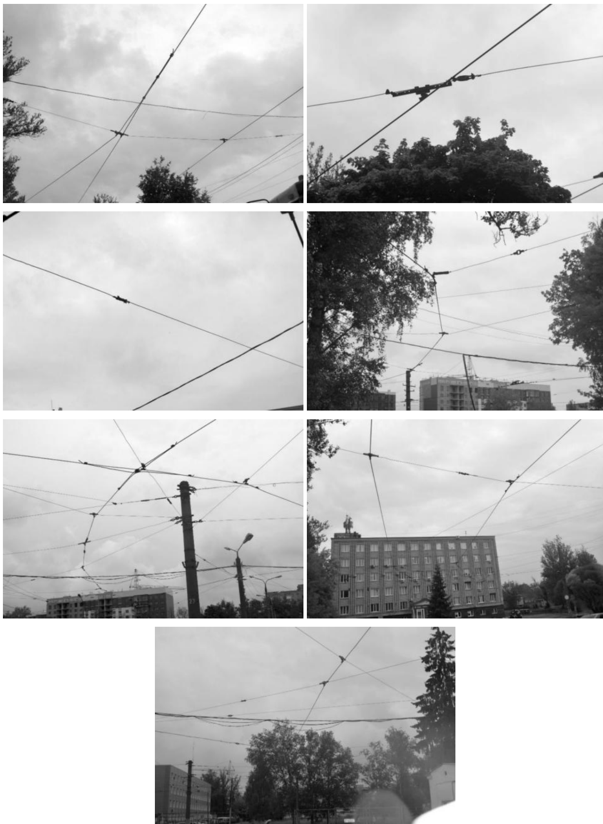
Рисунок 2.401 – Системы подвески из стальных канатов
