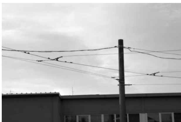
Рисунок 2.335 – Контактный провод трамвая
