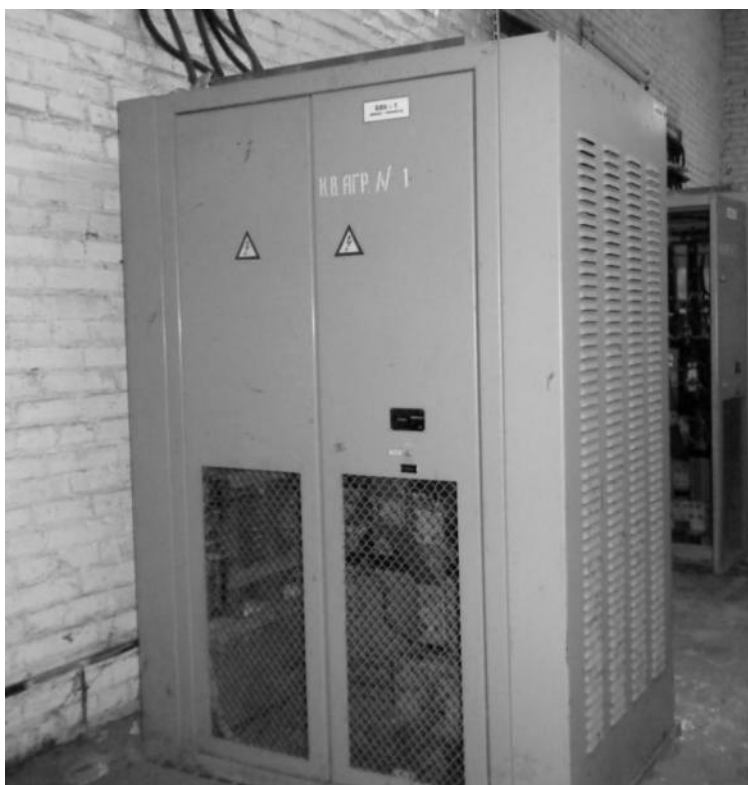
Рисунок 2.225 Блоки выпрямителя БВКЛЕ-1000 и шкафы управления ШУЛЕ-1000 (ТП-8)
