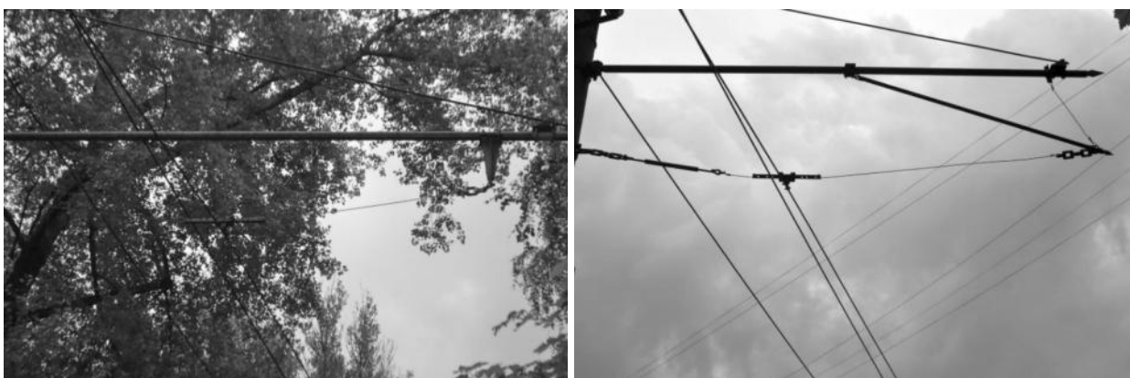
Рисунок 2.410 – Системы подвески из стальных канатов
