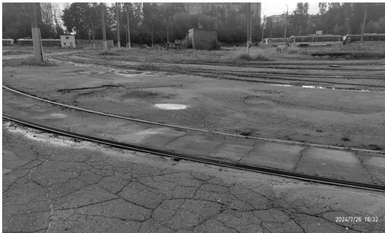
Рисунок 2.73 – Общий вид асфальтобетонного покрытия территории депо
