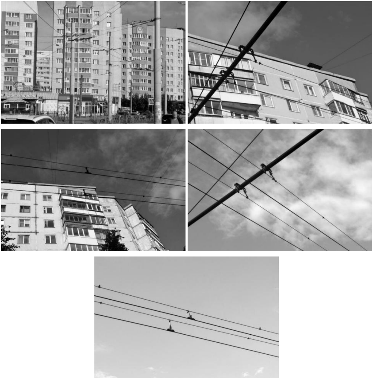
Рисунок 2.568 – Системы подвески из стальных канатов
