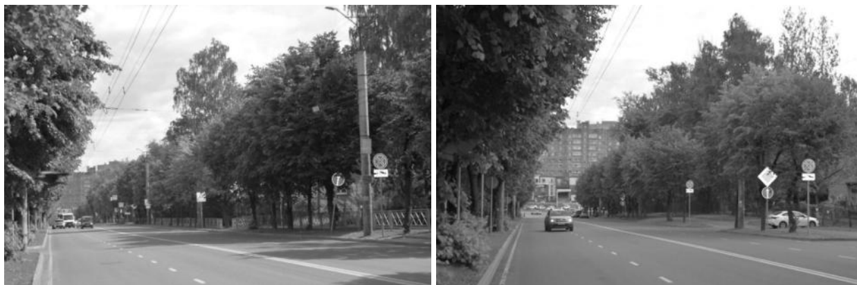
Рисунок 2.543 – Существующие опоры контактной сети
