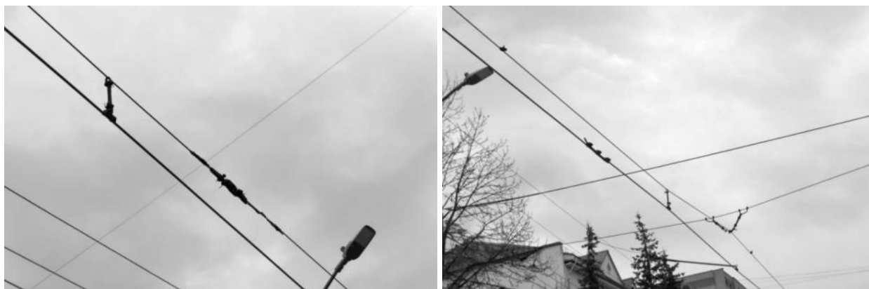
Рисунок 2.378 – Продольный стальной канат
