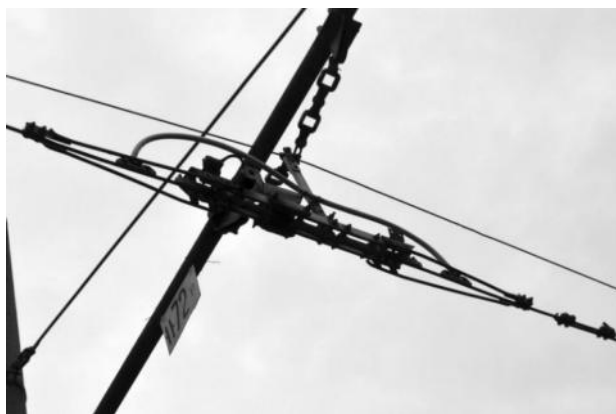
Рисунок 2.435– Секционный изолятор
