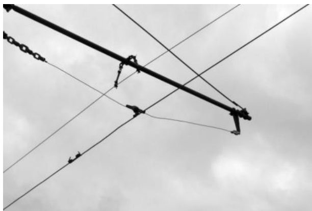
Рисунок 2.270 – Элементы подвески контактной сети
