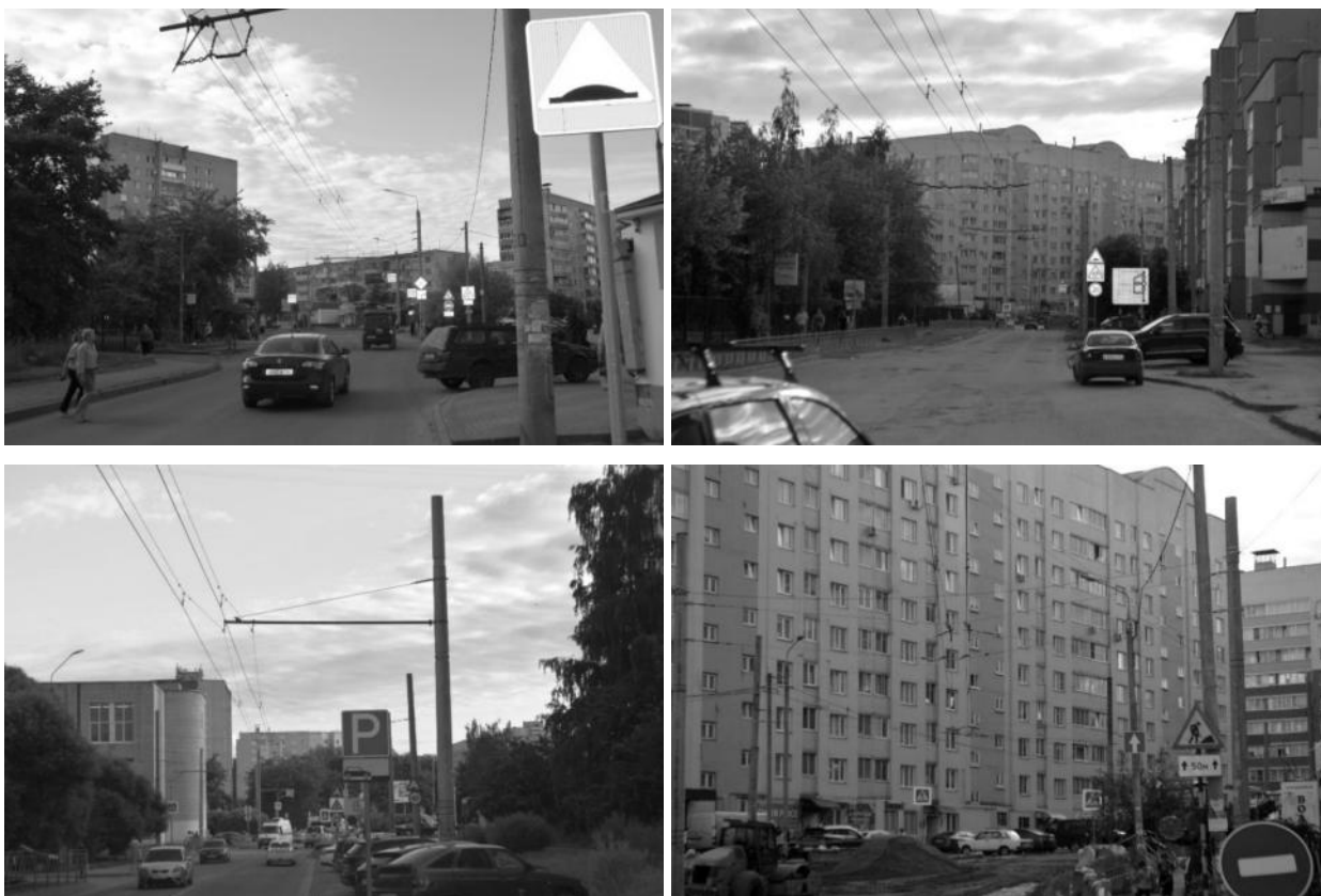
Рисунок 2.577 – Опоры контактной сети
