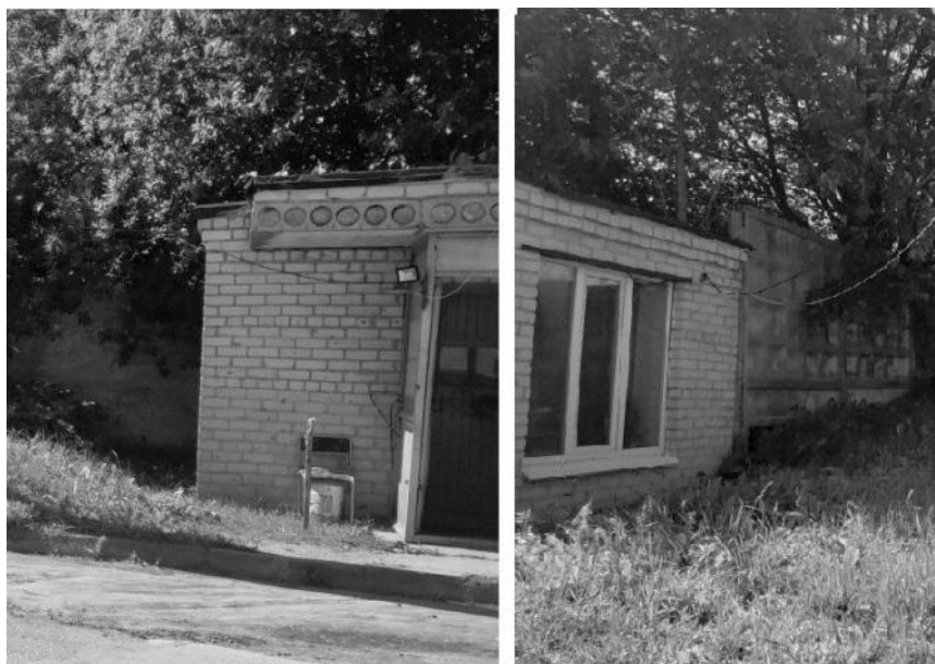
Рисунок 2.29 – Общий вид проходной №1 на дату проведения обследования
