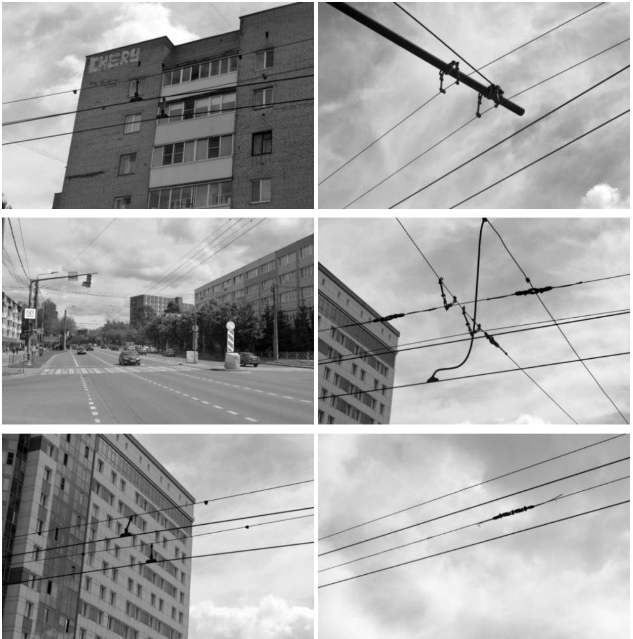
Рисунок 2.525 – Системы подвески из стальных канатов
