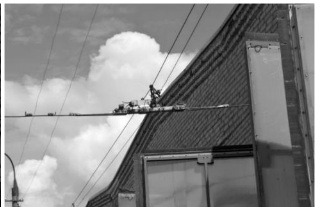
Рисунок 2.484 – Секционные изоляторы на участке контактной сети
