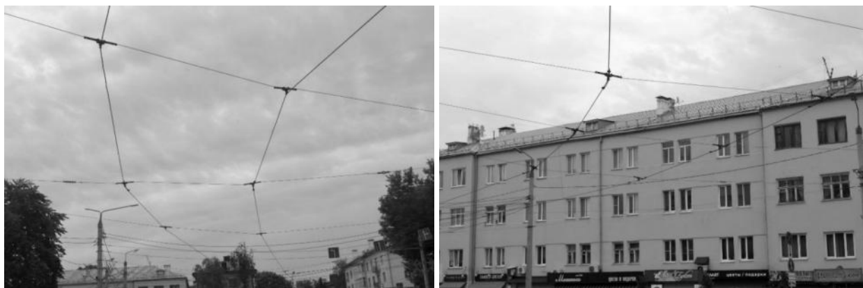
Рисунок 2.359 – Контактный провод трамвая
