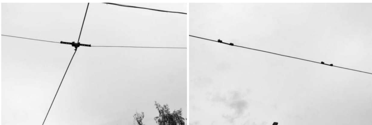
Рисунок 2.433 – Контактный провод трамвая
