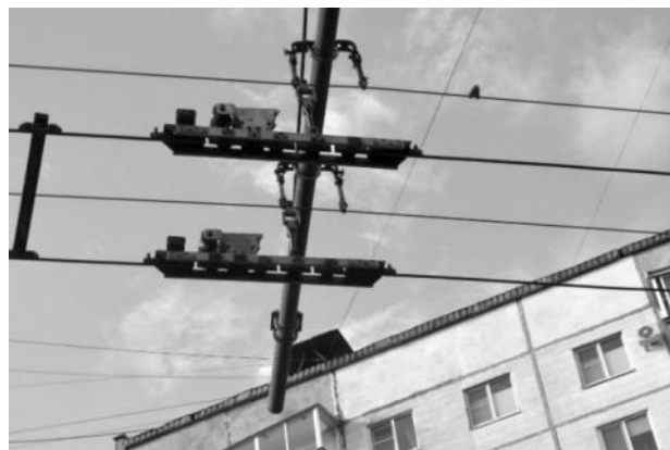
Рисунок 2.567 – Секционные изоляторы
