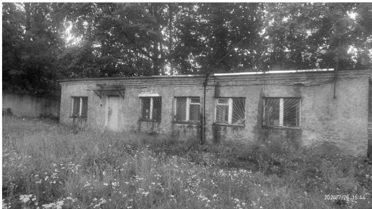
Рисунок 2.66 – Общий вид здания радиоцеха на дату проведения обследования
