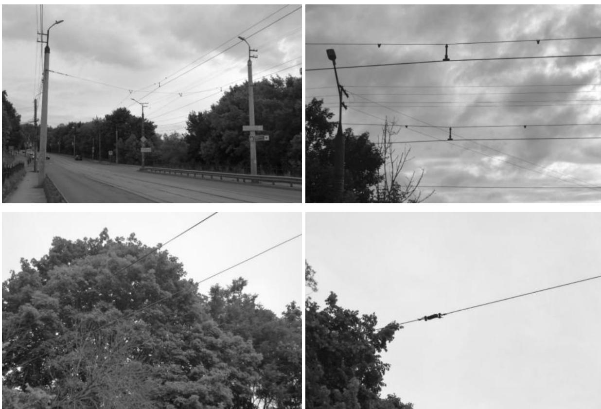
Рисунок 2.317 – Системы подвески из стальных канатов
