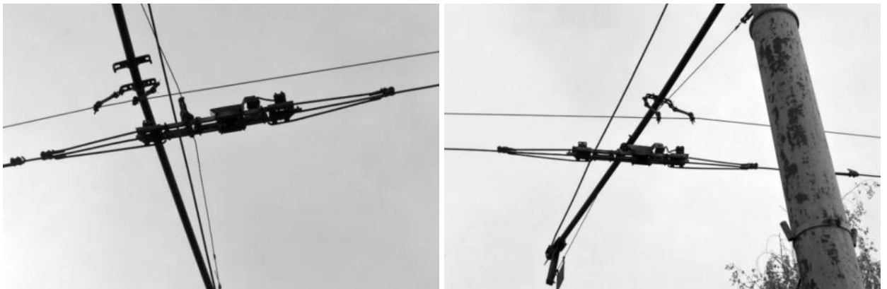
Рисунок 2.321 – Секционные изоляторы
