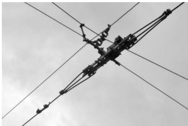
Рисунок 2.449 – Секционный изолятор
