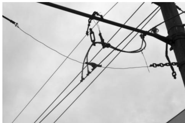
Рисунок 2.467 – Системы подвески из стальных канатов
