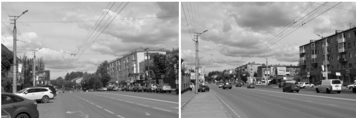
Рисунок 2.528 – Существующие опоры контактной сети
