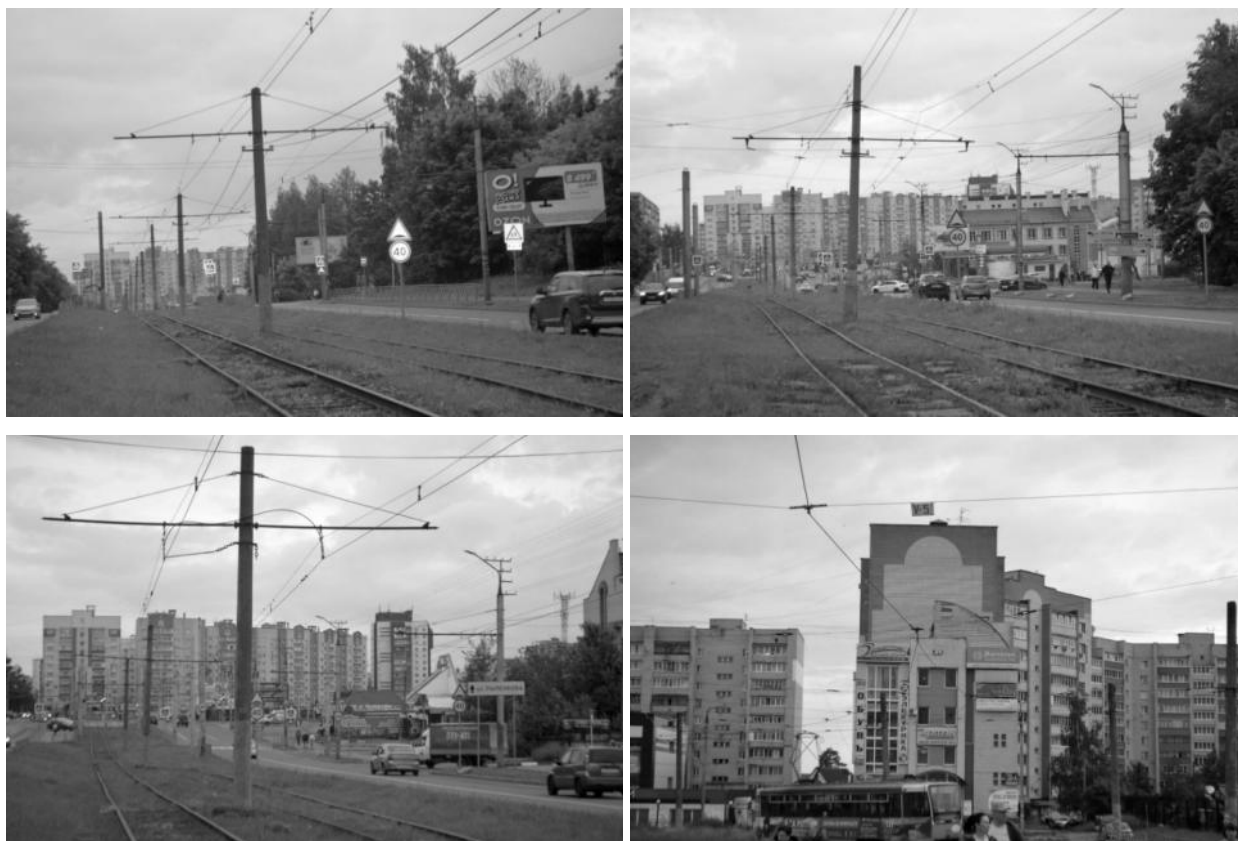
Рисунок 2.469 – Существующие опоры контактной сети
