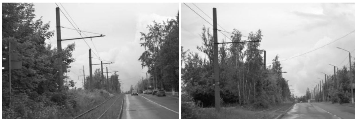
Рисунок 2.438 – Существующие опоры контактной сети
