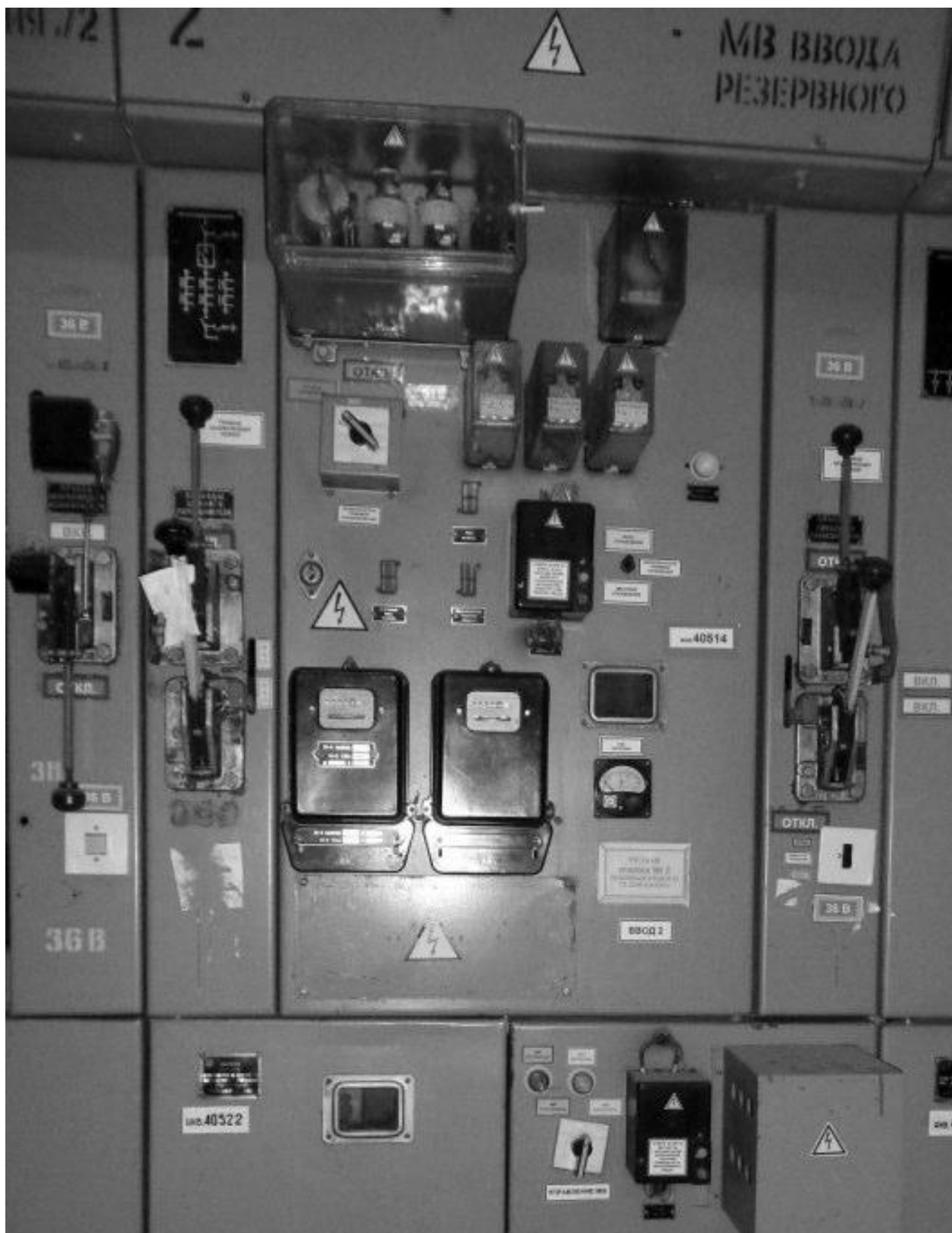
Рисунок 2.233 – Релейная аппаратура РУ-6 кВ
