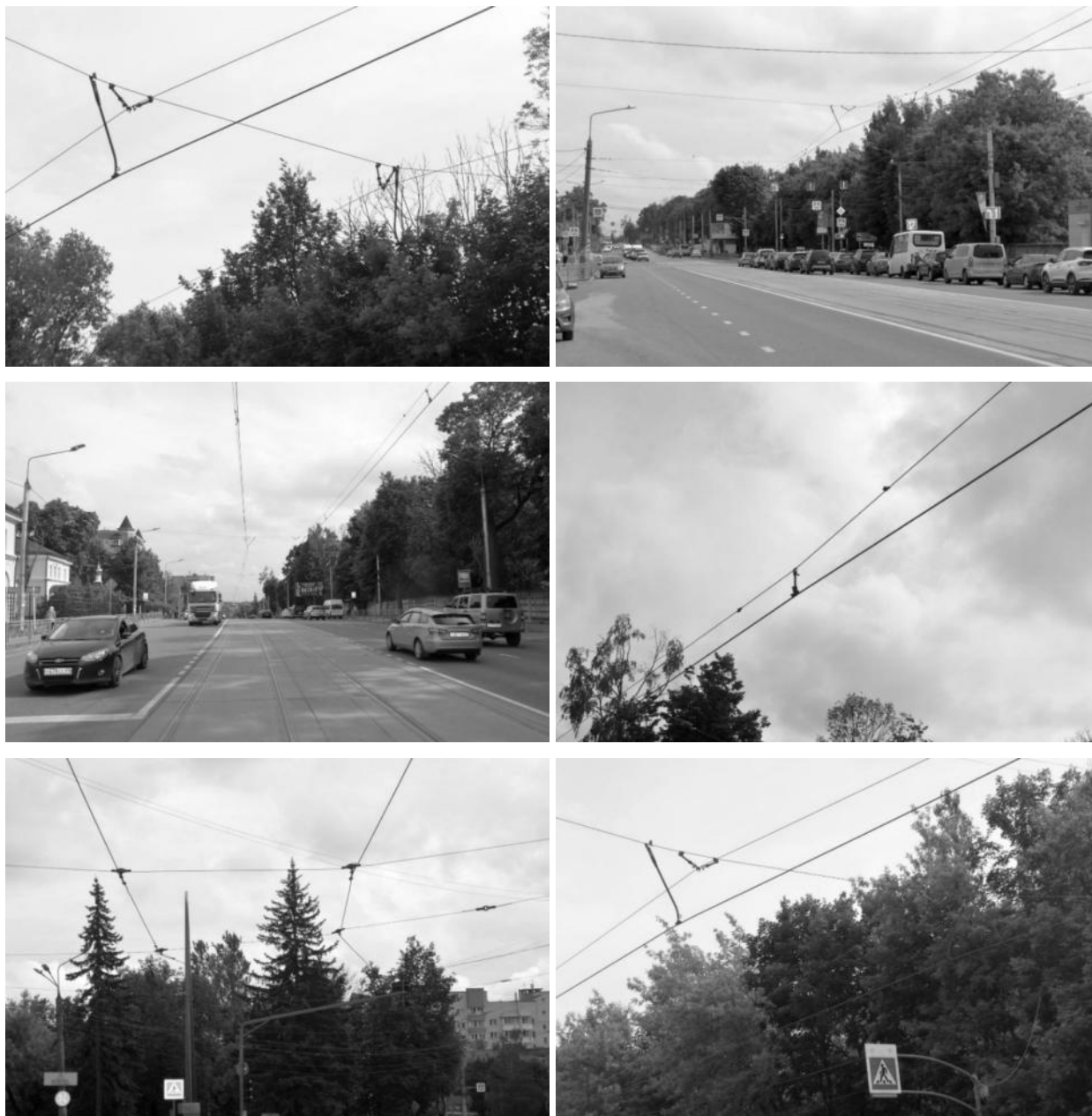
Рисунок 2.282 – Системы подвески из стальных канатов
