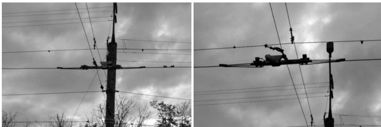
Рисунок 2.312 – Секционные изоляторы
