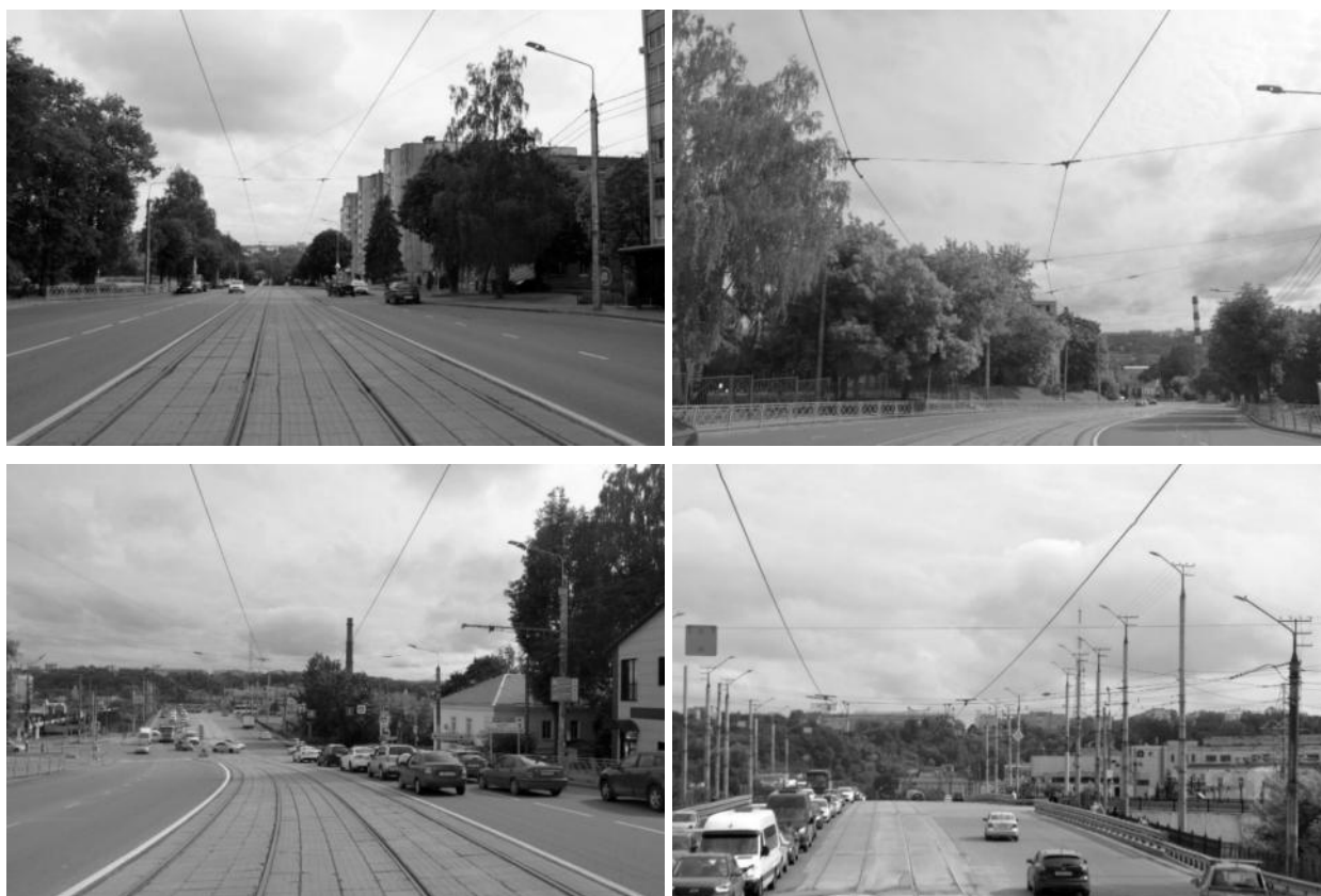
Рисунок 2.283 – Существующие опоры контактной сети
