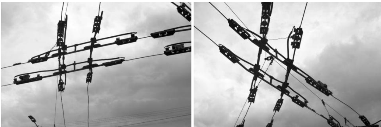
Рисунок 2.620 – Пересечения контактных проводов троллейбуса, находящихся в ограниченно пригодном состоянии и имеющее изгиб ходовых металлических шин
