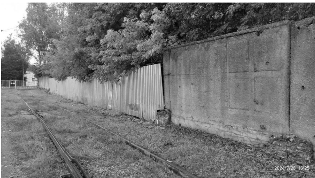
Рисунок 2.77 – Общий вид ограждений из металлического профлиста
