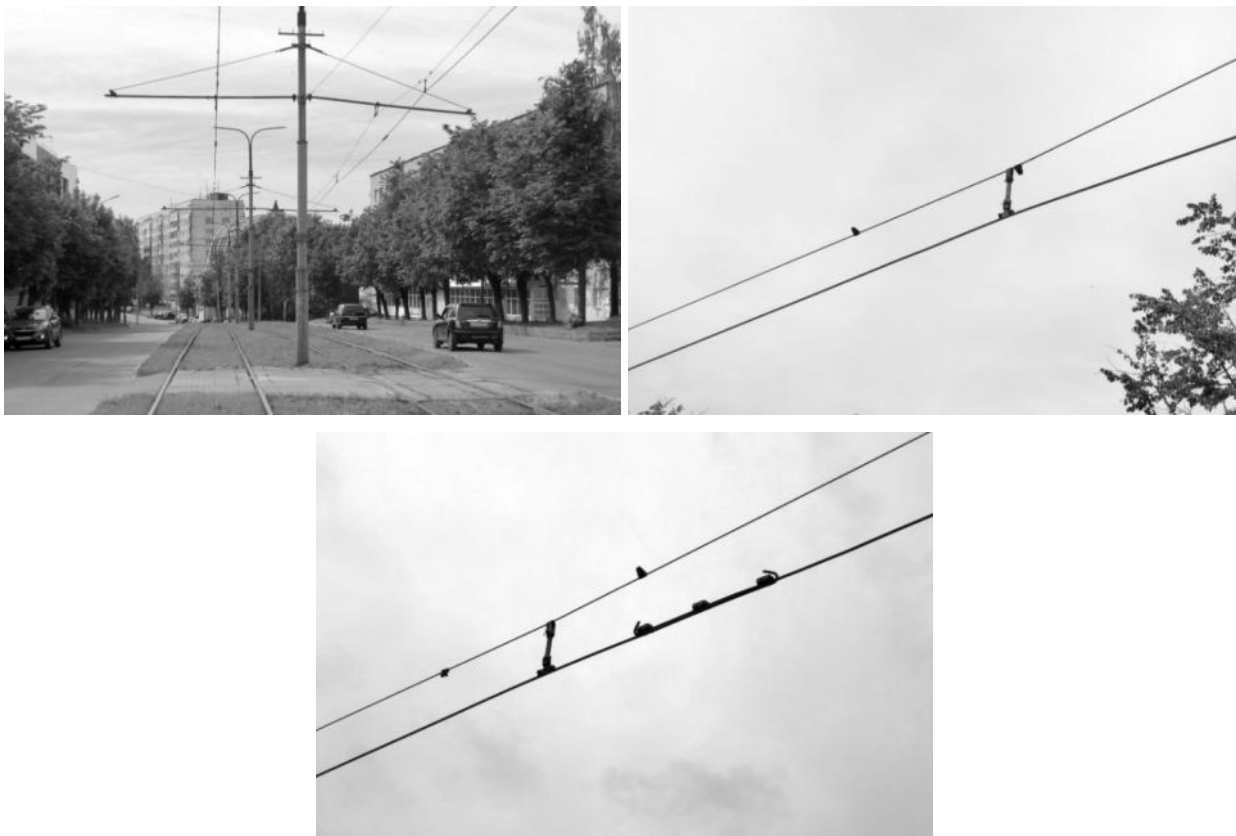
Рисунок 2.342 – Контактный провод трамвая
